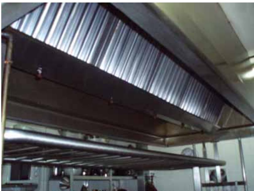
Foto 4.13. Campana extractora en la cocina del restaurante El Alambique.
