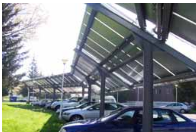
Foto A1.12. Ejemplos de paneles fotovoltaicos instalados en cubiertas de parking de restaurantes (Fuente: Ferrolí).
