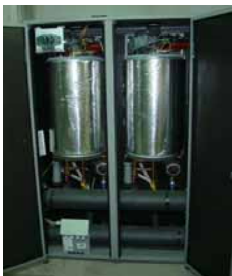
Foto A1.1. Calderas modulares de bajo NO x y condensación a gas natural. Vistas exterior e interior (Fuente: Ferroli).
