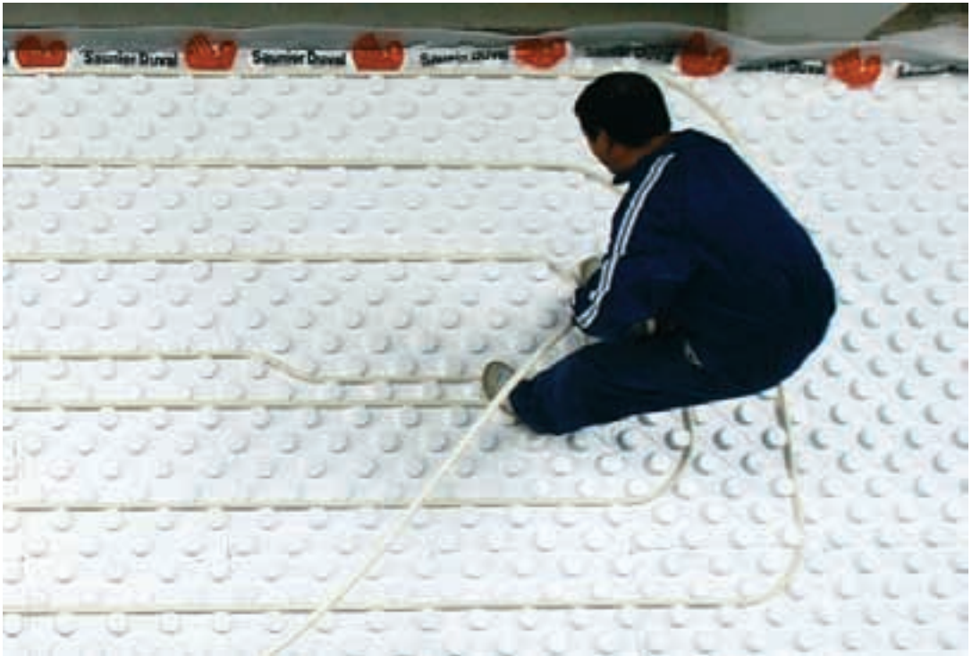
Instalación de suelo radiante (calefacción y refrigeración).
