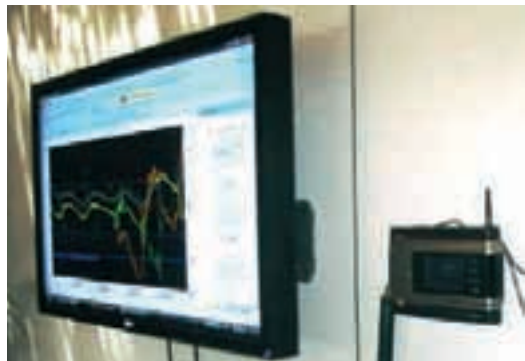
Programa de ensayos y monitorización del sistema de climatización del edificio.
