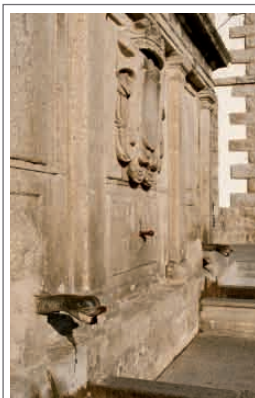
Fuente de Los Caños Water Pipe Fountain
