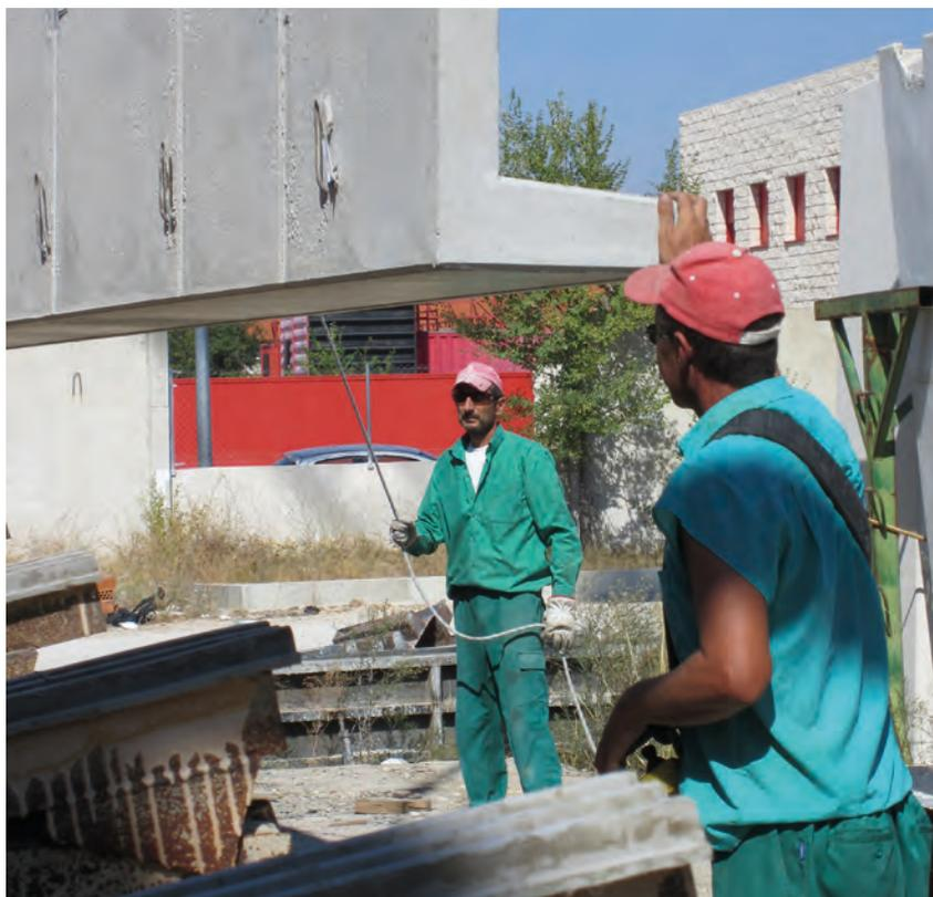
Manejo de paneles prefabricados de hormigón mediante cuerdas guía para su carga en transporte
