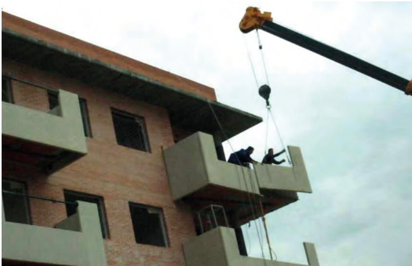
Montaje de prefabricado de hormigón en fachada, mediante grúa autotransportada. Los trabajadores que reciben el prefabricado deberán hacer uso de arnés de seguridad con absorbedor de energía y mantenerse anclados a punto fijo y resistente en todo momento
