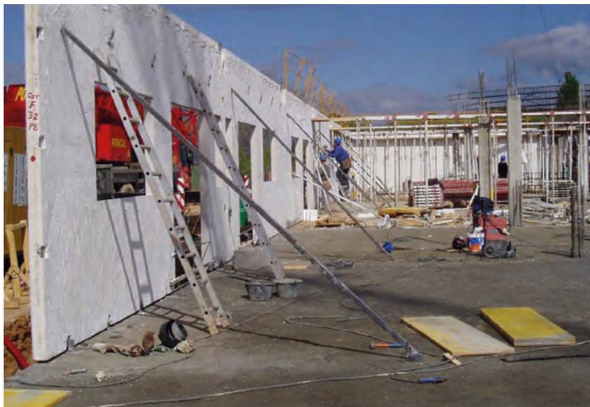
Coocación en obra de paneles prefabricados de hormigón. Se observan los apuntalamientos de los paneles para garantizar su estabilidad durante la ejecución de la fachada
