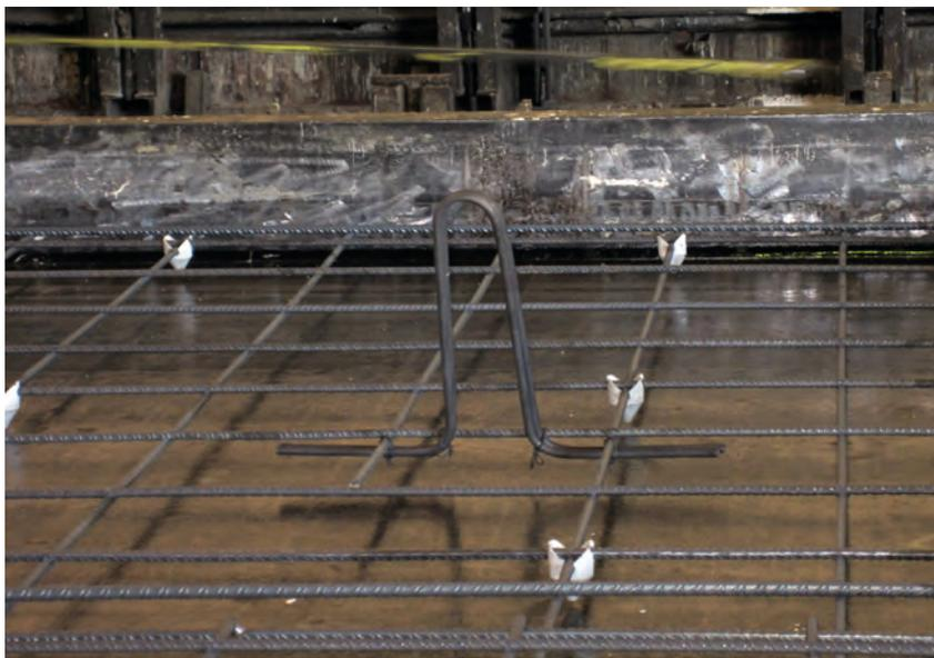
Colocación de cachava en la armadura del panel prefabricado para posterior hormigonado del panel y elevación mediante la misma durante el desencofrado
