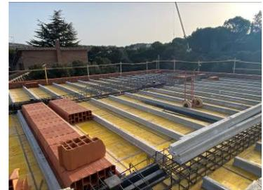
Figura 3. Vista superior del forjado en ejecución
