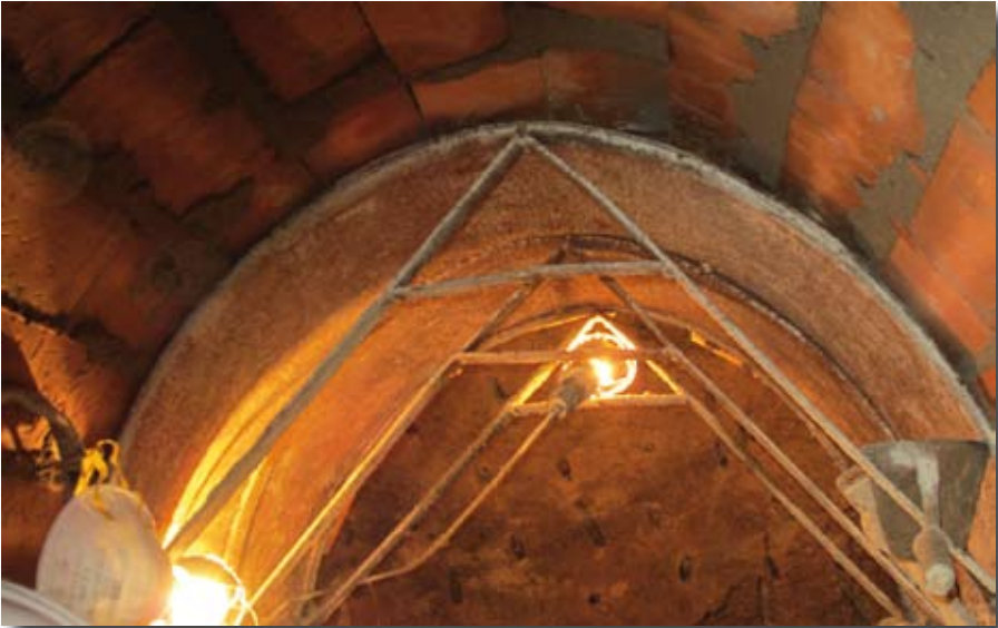
Detalle del camión con el que se forma la bóveda de la galería. La alimentación de los puntos de luz es de 24 voltios.
