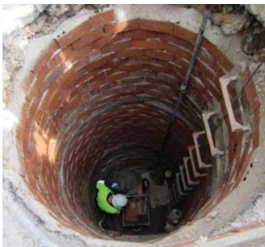
Ejecución de pozo de geometría circular con revestimiento provisional de fábrica de ladrillo.
