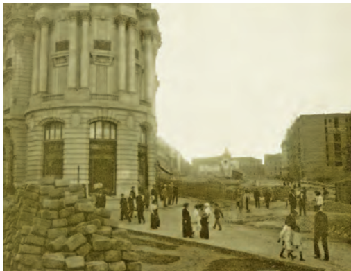
Primeros derribos de la Gran Vía, 1912.
