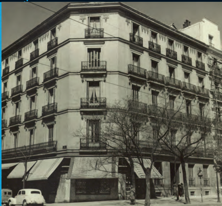
Edificio de la calle de Alfonso XII en el que nació Ortega, frente al parque del Retiro.
