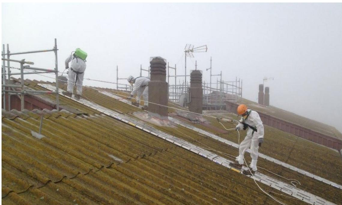
Retirada de cubierta de fibrocemento con amianto en edificio residencial
