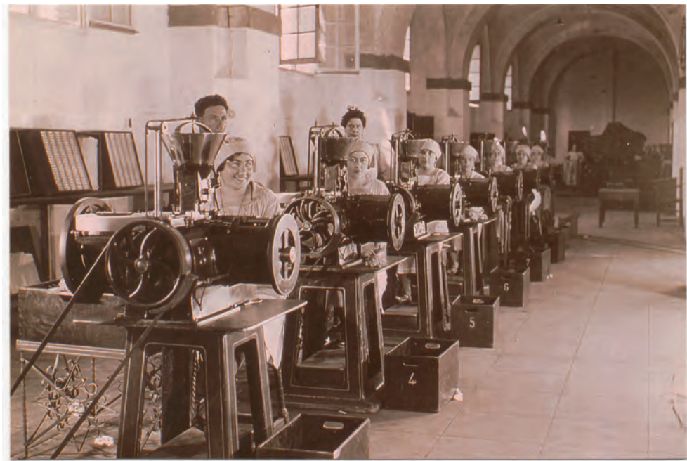
FIGURA 5. Cigarreras. Fábricas de tabacos de Sevilla. Operarias trabajando con máquinas liadoras Vilaseca en el primer tercio del siglo XX. Altadis.
