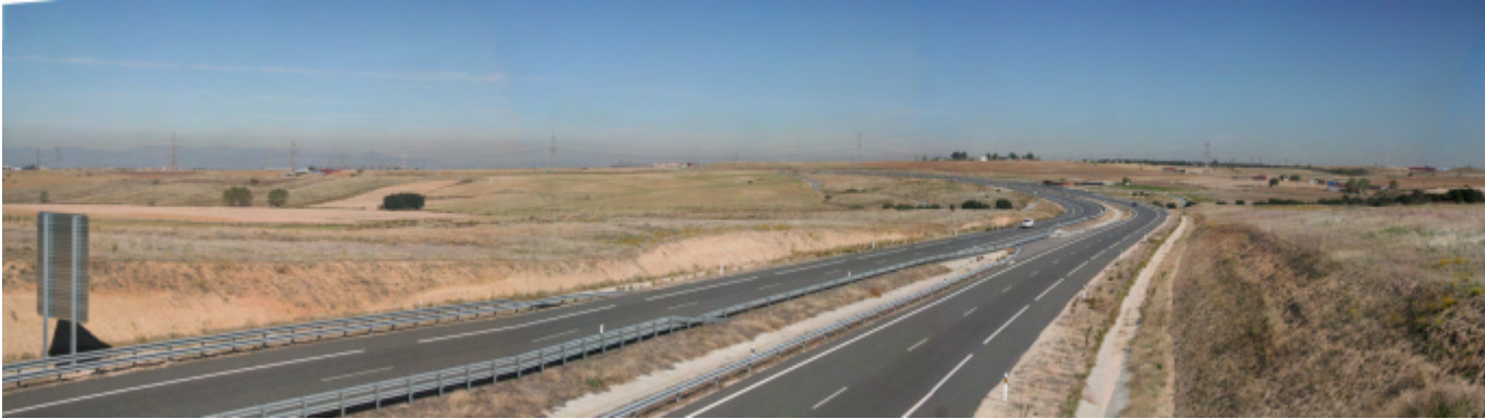
Vista de la autopista AP41 a su paso por el corredor
