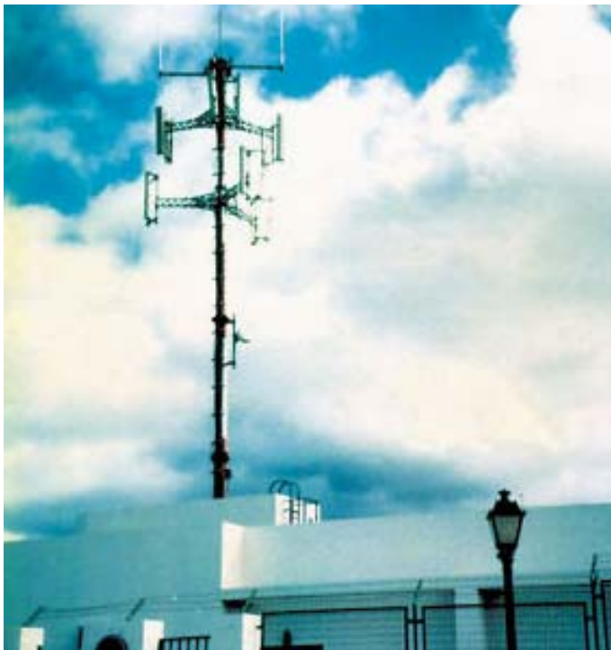
Figura .1. Antena sobre un edificio.
