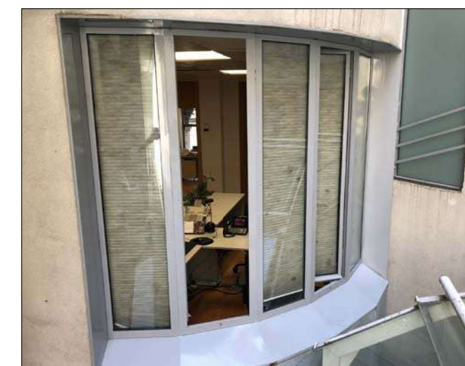
estado actual. exterior
