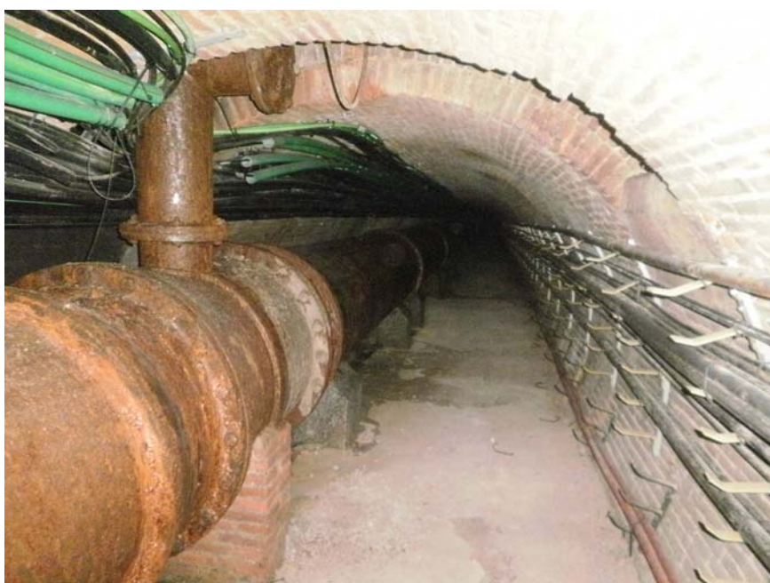
Fotografía 08. Vista general interior de galería. Punto de conexión a tubería de Ø 800 FG.
