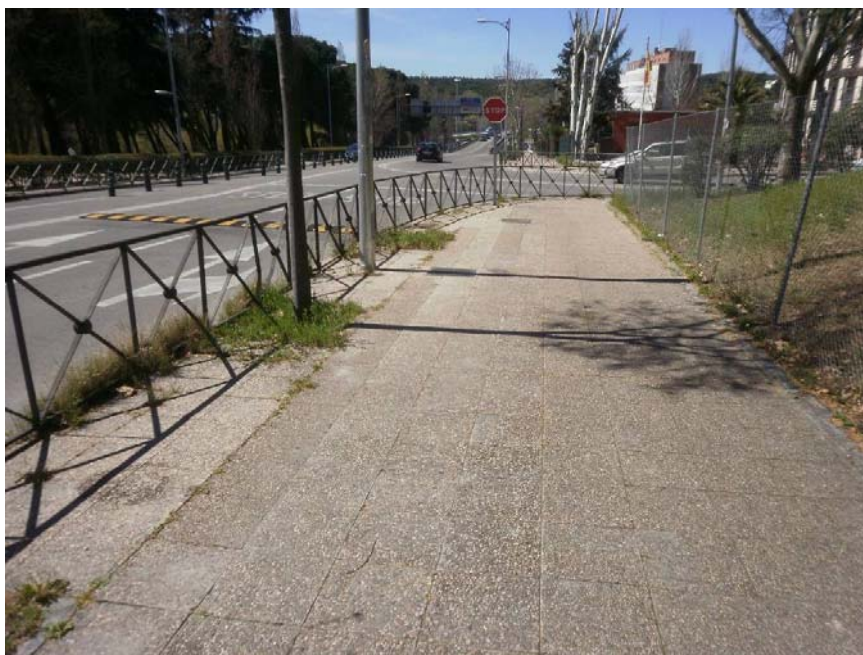
Fotografía 3. Vista general de pavimento de acera existente, de tipología de baldosa hidráulica de chino lavado.
