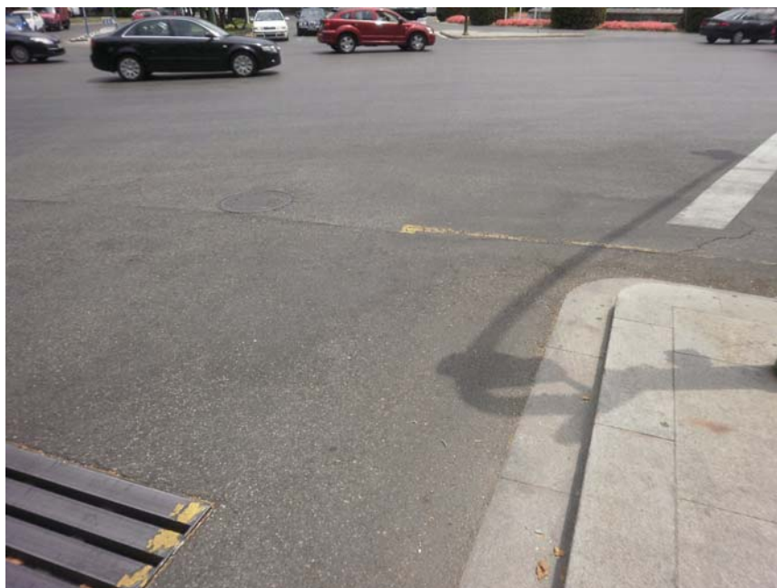
Fotografía 6. Vista general de tapa de pozo en calzada de válvula VA.54IJ-376.
