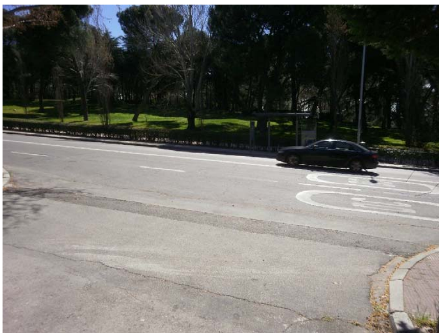
Fotografía 2. Vista general desde zona de ubicación de arqueta de válvulas reguladoras hacia cruce de calzada de la Avd. Seneca.
