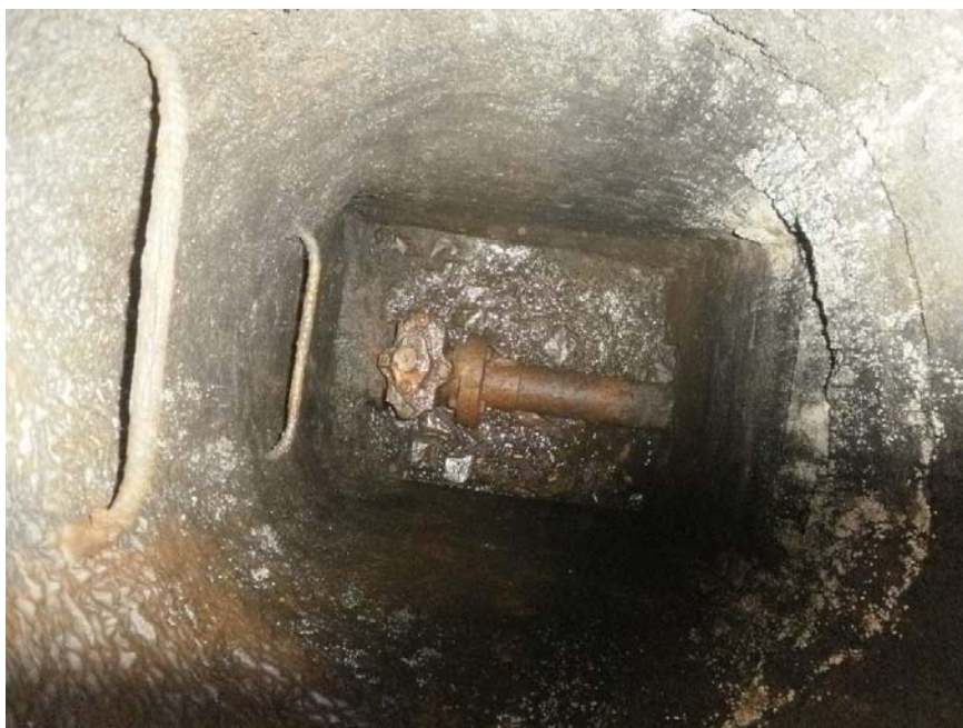
Fotografía 01. Vista interior de pozo de registro de válvula VD.54HJ-179.
