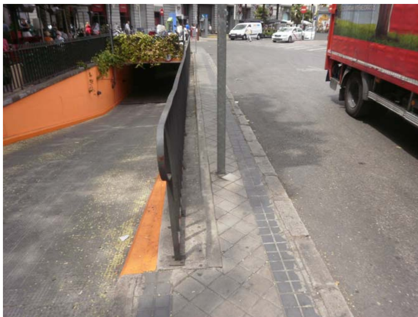
Fotografía 2. Vista general salida de parking y tipología de acera en zona de arqueta de caudalímetro.
