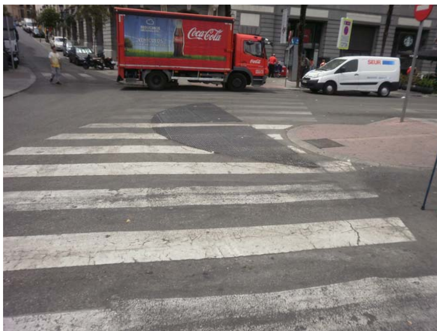
Fotografía 5. Vista general de marcas viales y rejilla de ventilación de aparcamiento subterráneo.
