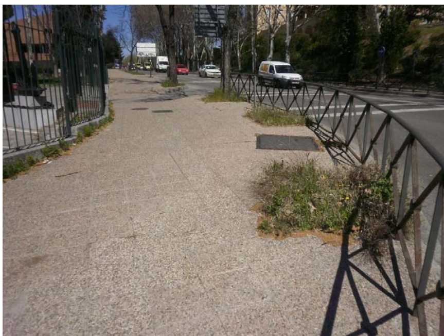
Fotografía 4. Vista general de pavimento de acera existente, de tipología de baldosa hidráulica de chino lavado.
