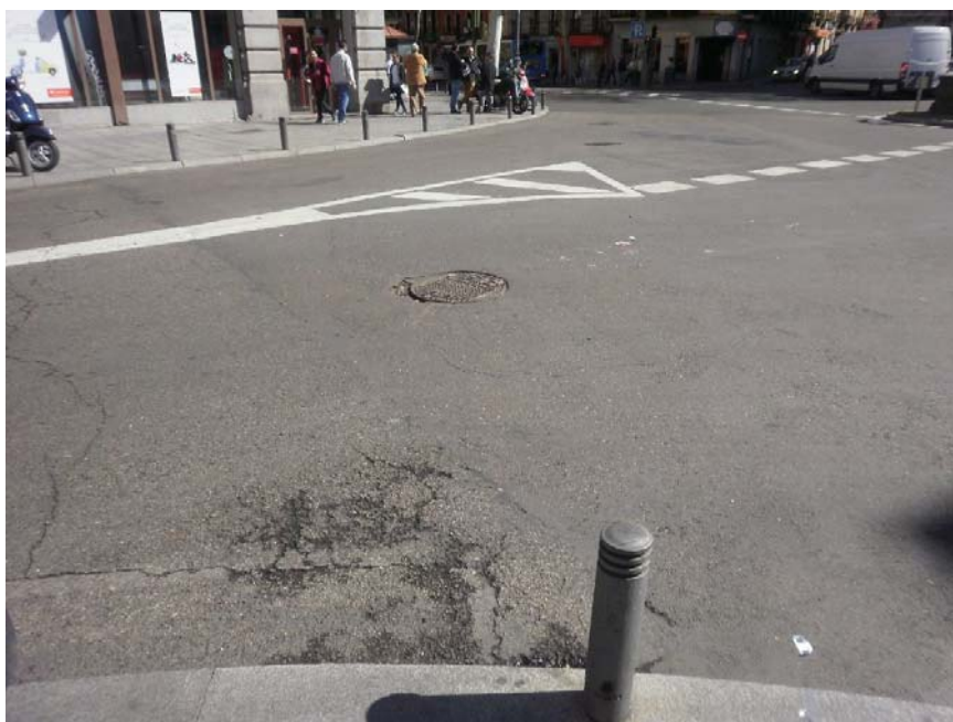
Fotografía 2. Vista general de calzada y tapa de pozo de válvula VA.54IJ-167 desde acera de cruce C/ Plaza de la Cebada y Calle de Toledo.
