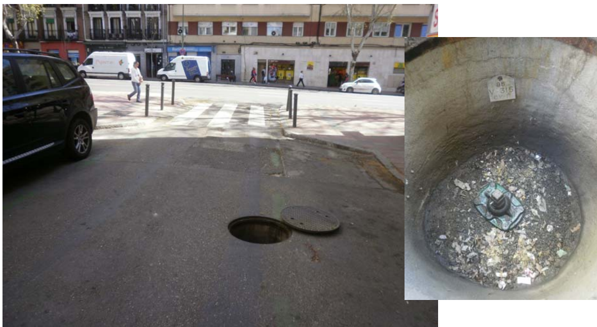
Fotografía 01. Vista general e interior de pozo de registro de válvula de corte VA.54JJ-315.
