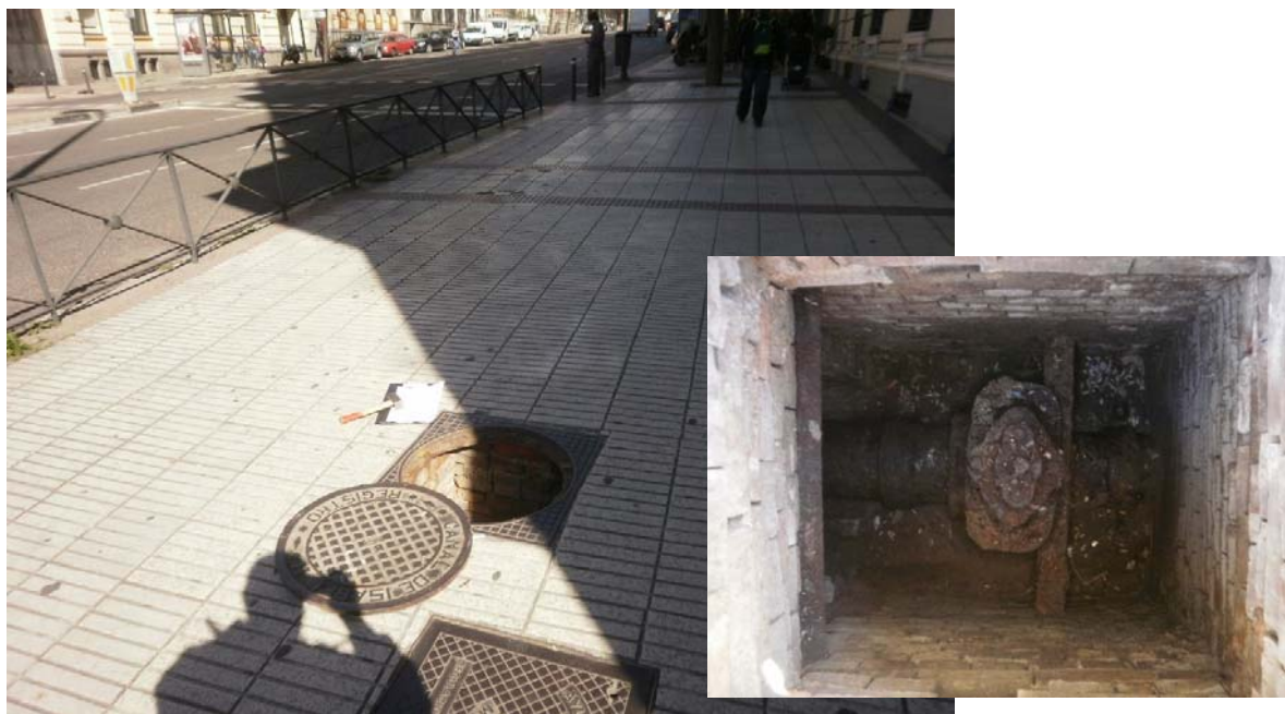
Fotografía 04. Vista general e interior de registro de válvula VA.54HJ-328. Pavimento de loseta de 40x 40
