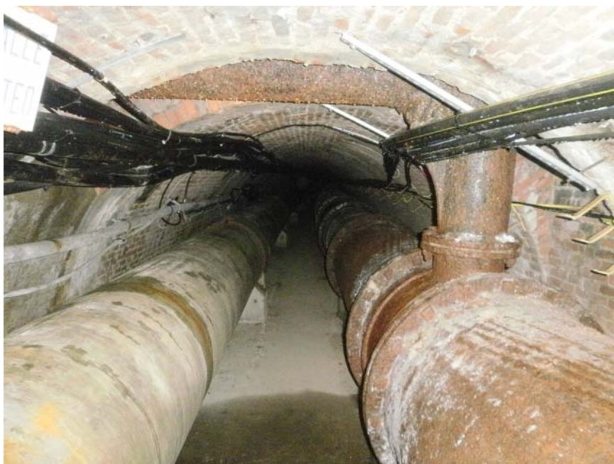
Fotografía 06. Vista interior de galería, general de conducciones y servicios existentes.
