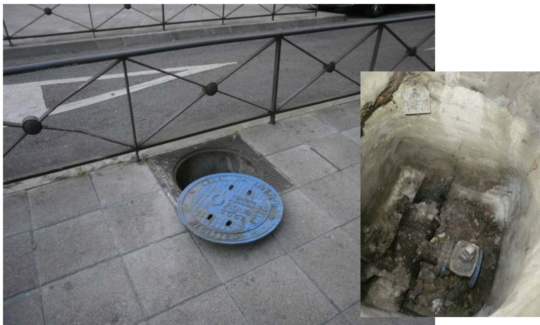
Fotografía 07. Vista general e interior de desagüe DE.54JJ-1093. Tipología de pavimento de acera de loseta hidráulica de 40 x 40.
