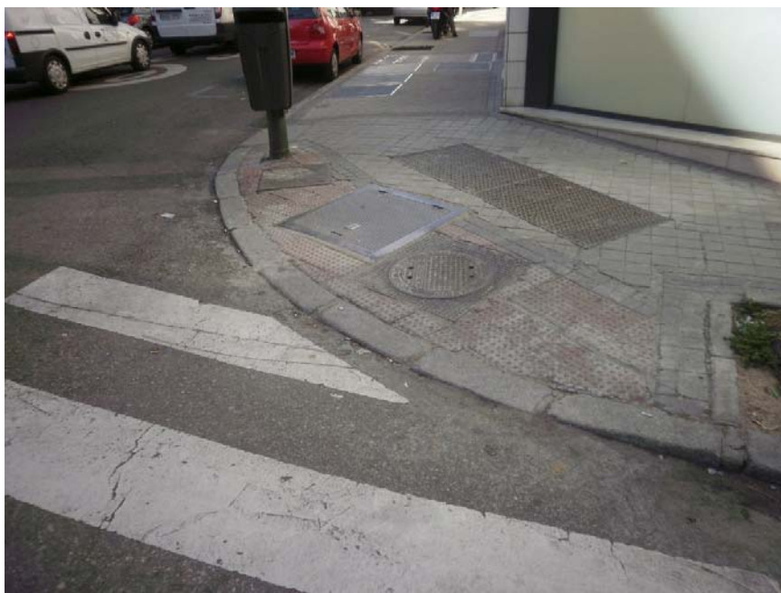
Fotografía 03. Vista general de arqueta de contador de red de riego en acera.
