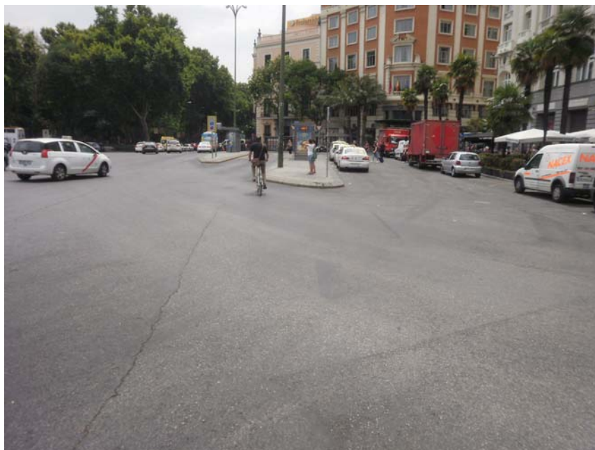
Fotografía 6. Vista general desde pozo de válvula VA.54IJ-376 hacia trazado de tubería de FD de \varnothing 300, donde se instalará el caudalímetro.
