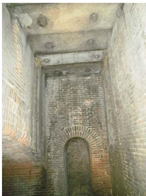
Fotografía 10. Interior de galería. Entrada de Materiales en Calle Marqués de Riscal. Cobijas en acera.
