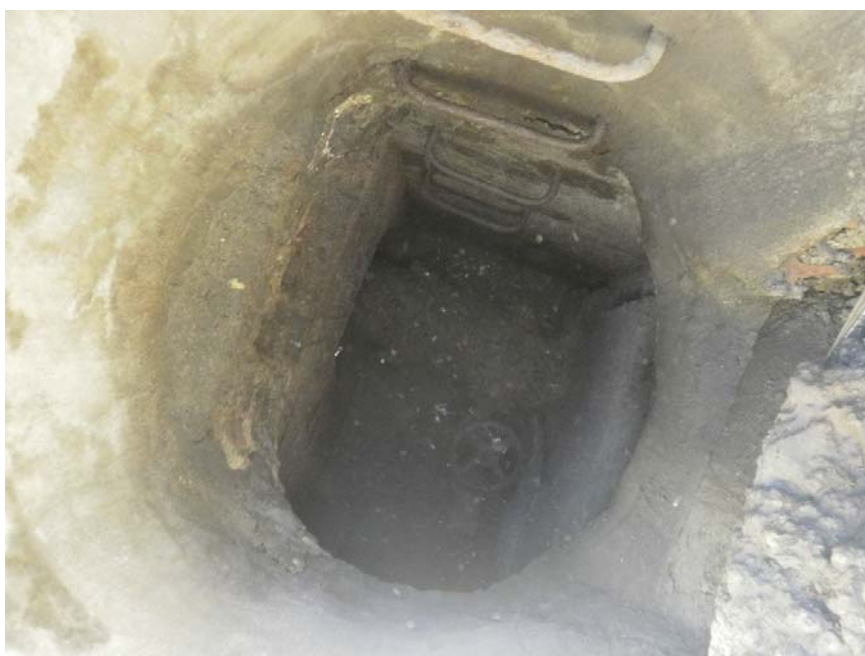
Fotografía 04. Vista interior de pozo de registro de válvula VD-54HJ-177.
