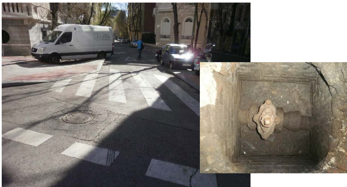
Fotografía 06. Vista general de cruce de C/ Almagro y C/ de Jenner. Marcas viales e interior de pozo de registro de válvula VA.54GK-76.
