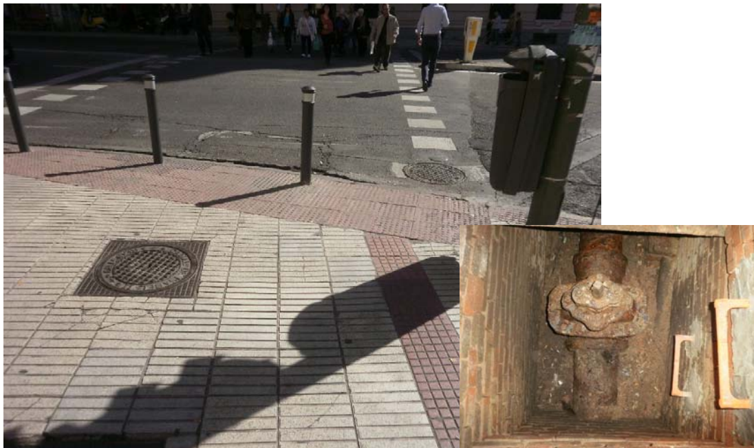
Fotografía 01. Vista general e interior de registro de válvula VA.54HJ-233
