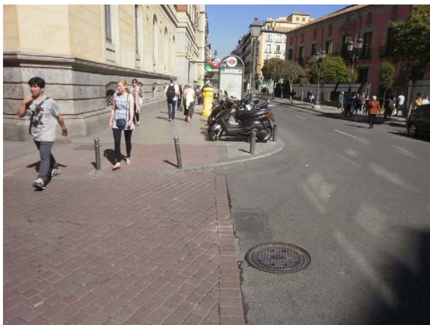
Fotografía 02. Vista general de tapa de pozo de registro de válvula VA.54HJ-179 en calzada. Tipología de pavimento de Calle San Vicente Ferrer de adoquín.
