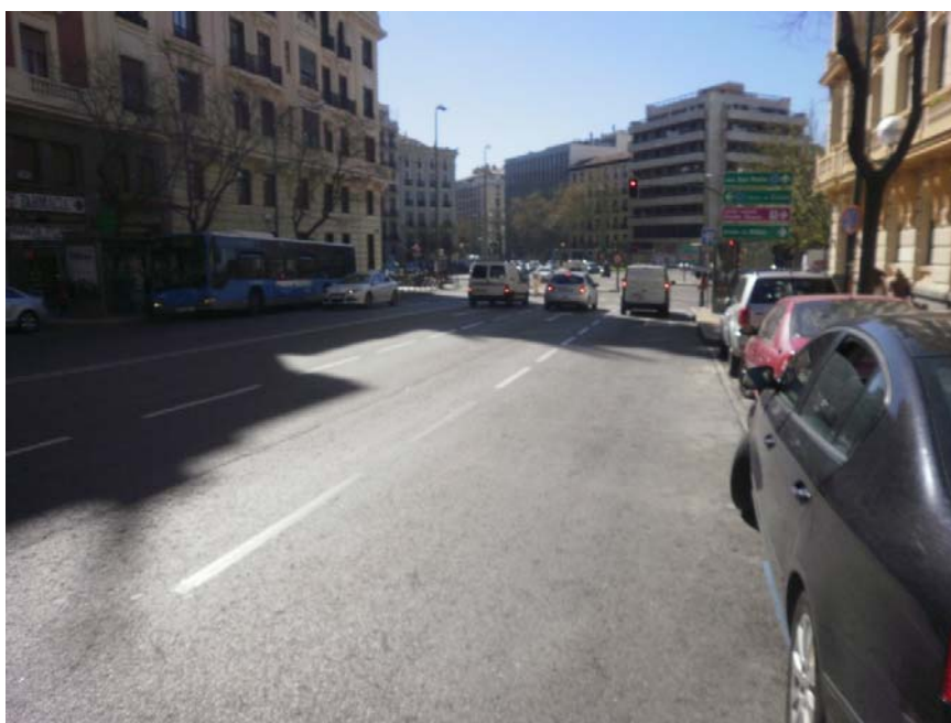
Fotografía 08. Vista general de calzada nº impares desde nº 3 hacia Plaza de Alonso Martínez.
