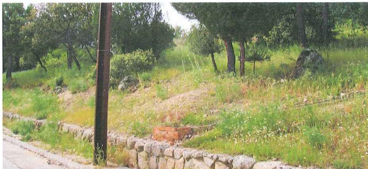
F.6. Pequeño talud en suelos con algún bolo residual de granito en la curva sureste de la C/ Clavel
