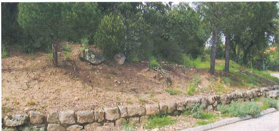
F.6. Pequeño talud en suelos con algún bolo residual de granito en la curva sureste de la C/ Clavel
