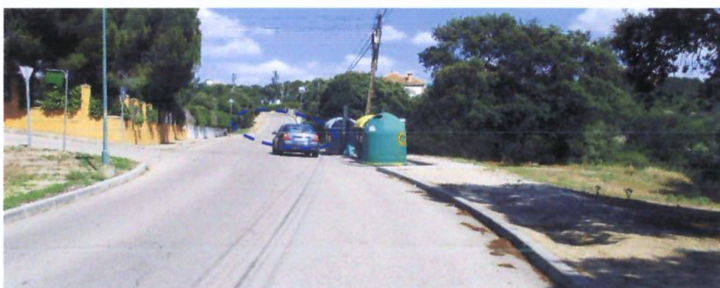
F.2. Vista de una zona de la calle de la Gacela a media ladera, con desmonte a la izquierda y relleno a la derecha. En los taludes de desmonte se observan suelos areno-arcillosos con cantos.
