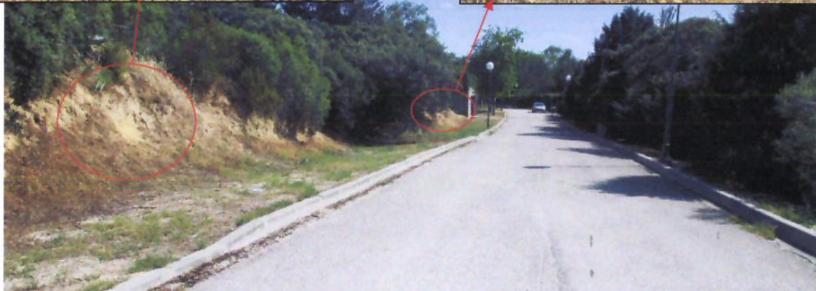
F.2. Vista de una zona de la calle de la Gacela a media ladera, con desmonte a la izquierda y relleno a la derecha. En los taludes de desmonte se observan suelos areno-arcillosos con cantos.
