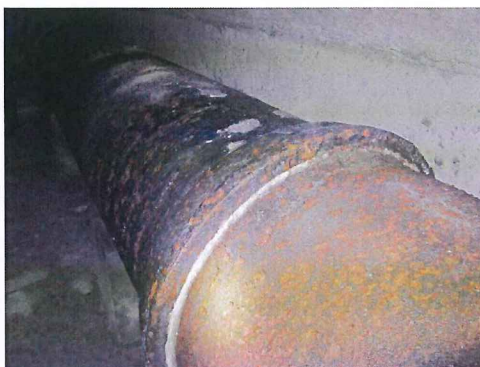
Corrosión en tubería de fundición
