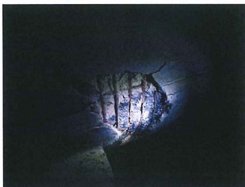
Corrosión en armadura vista de hormigón armado
