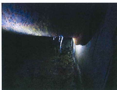
Filtraciones en tubería
