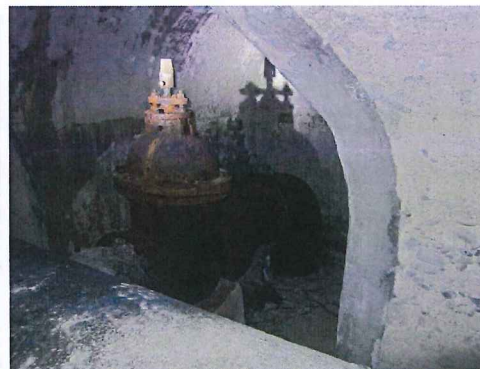
Corrosión en valvulería
