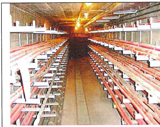
Cables en galería visitable
