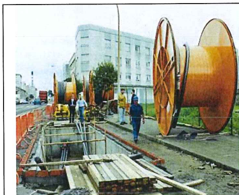
Cables en canalización entubada
