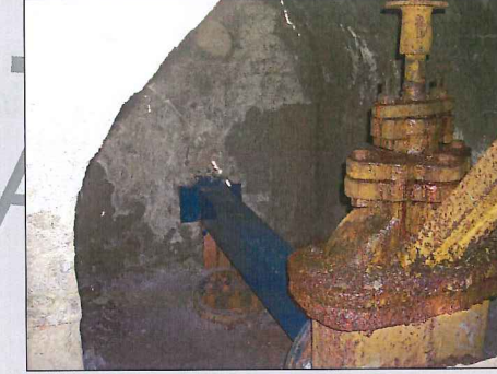
FOTO E : - Tubería DN 900 HAcCCh - Derivación con brida ciega.
