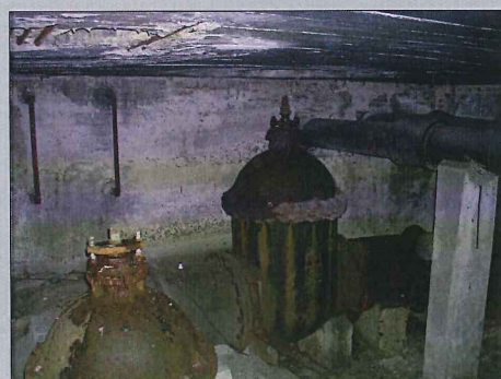
FOTO 74: - Tubería DN 700 FG. - Válvula de compuerta.
