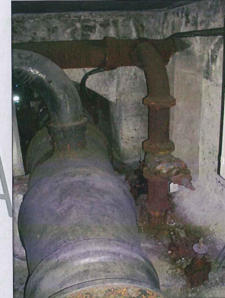
FOTO 71: - Tubería DN 900 - Tuberías DN 300 elevadas. - Desagüe DN 200. Válvulas de compuerta.
