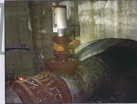
FOTO D : - Tubería DN 900 HAcCCh - Ventosa. - Válvula de mariposa.
