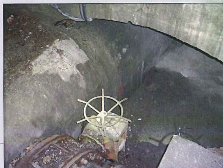
FOTO A : - Tubería DN 1250 HAcCCh - Tubería DN 900 de derivación. - Válvula de mariposa.
