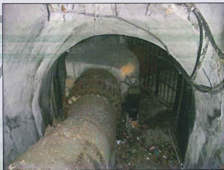
FOTO 69 (de primer plano hacia atrás): - Tubería DN 900 AC - Válvula Mariposa. - Macizo de hormigón. - Ventosa
