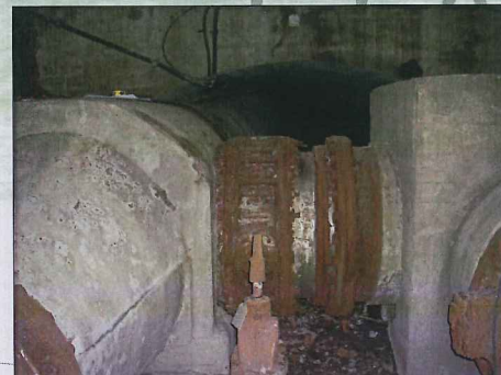
FOTO B : - Tubería DN 900 de derivación. - Válvula de mariposa. - Desagüe.
