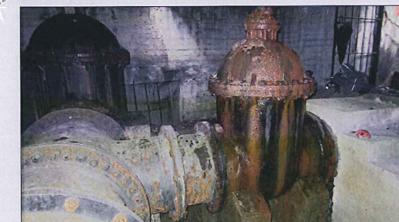
FOTO 73: - Tubería DN 500. - Válvula de compuerta.
