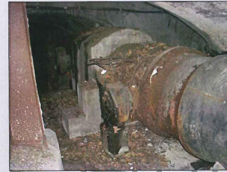
FOTO 70 (de primer plano hacia atrás): - Tubería DN 900 - Válvula mariposa. - Escaleras. - Macizo de hormigón.
