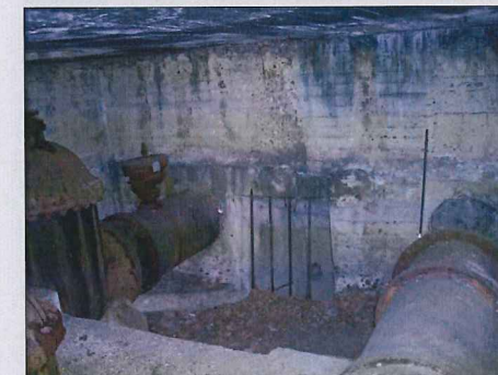
FOTO 72: - Tubería DN 700 FG. - Pozo de desagüe. - Tubería DN 700 FG - Válvula de compuerta. - Ventosa.
