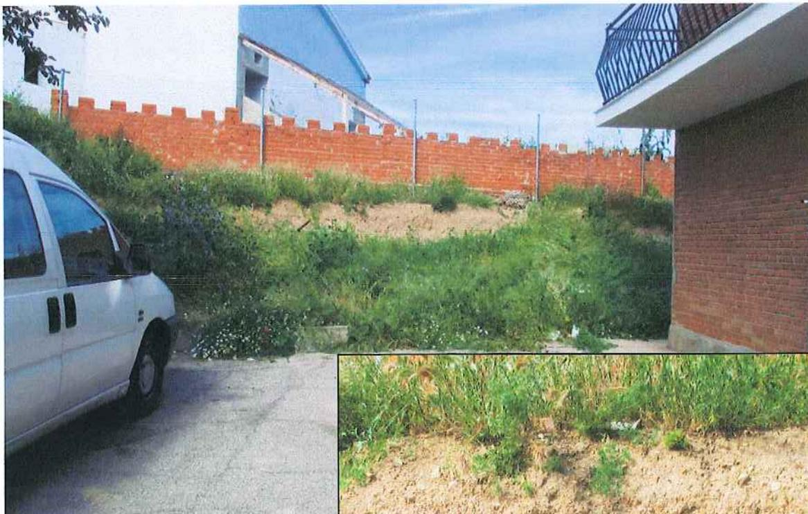
**F.8/8bis. Talud de desmorte en callejón junto a C/ Granada y detalle del mismo. Se observan depósitos de glacia: arenas arcillosas con cantos.**
