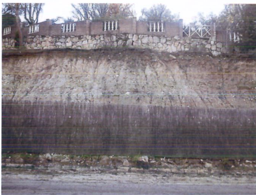
Fotografía 1. Material tipo suelo observado en un talud
