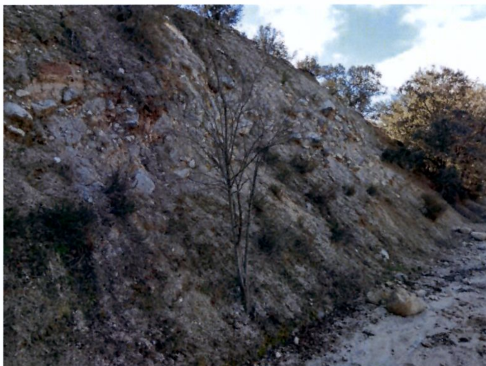
F4. Vista de afloramiento en la C/ Cabo Machichaco
