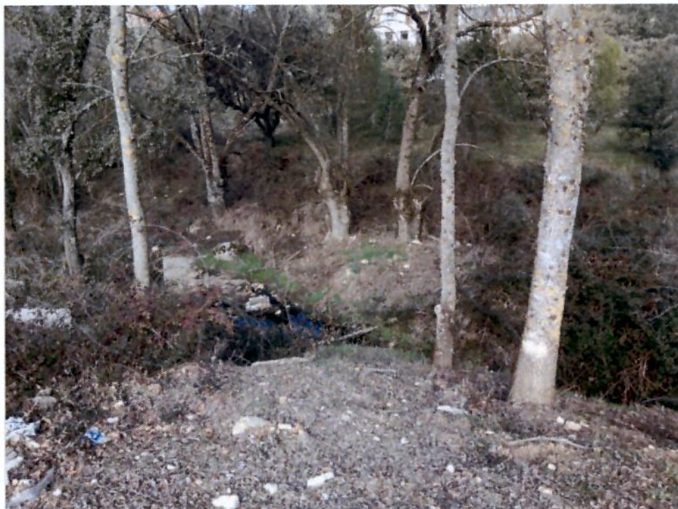
F7. Vista de afloramiento en la C/ Cabo Machichaco
