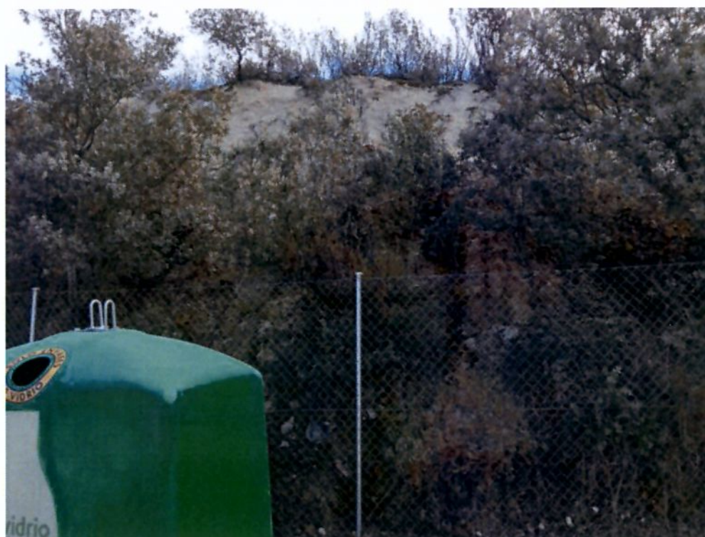
F8. Vista de afloramiento en la C/ Cabo Machichaco
