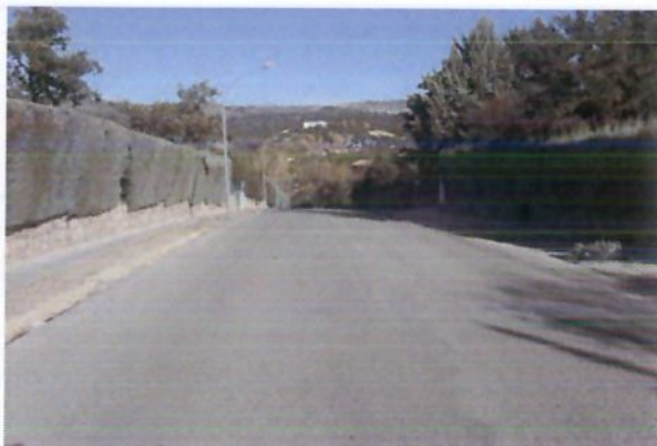
19 CALLE CABO LA NAC
