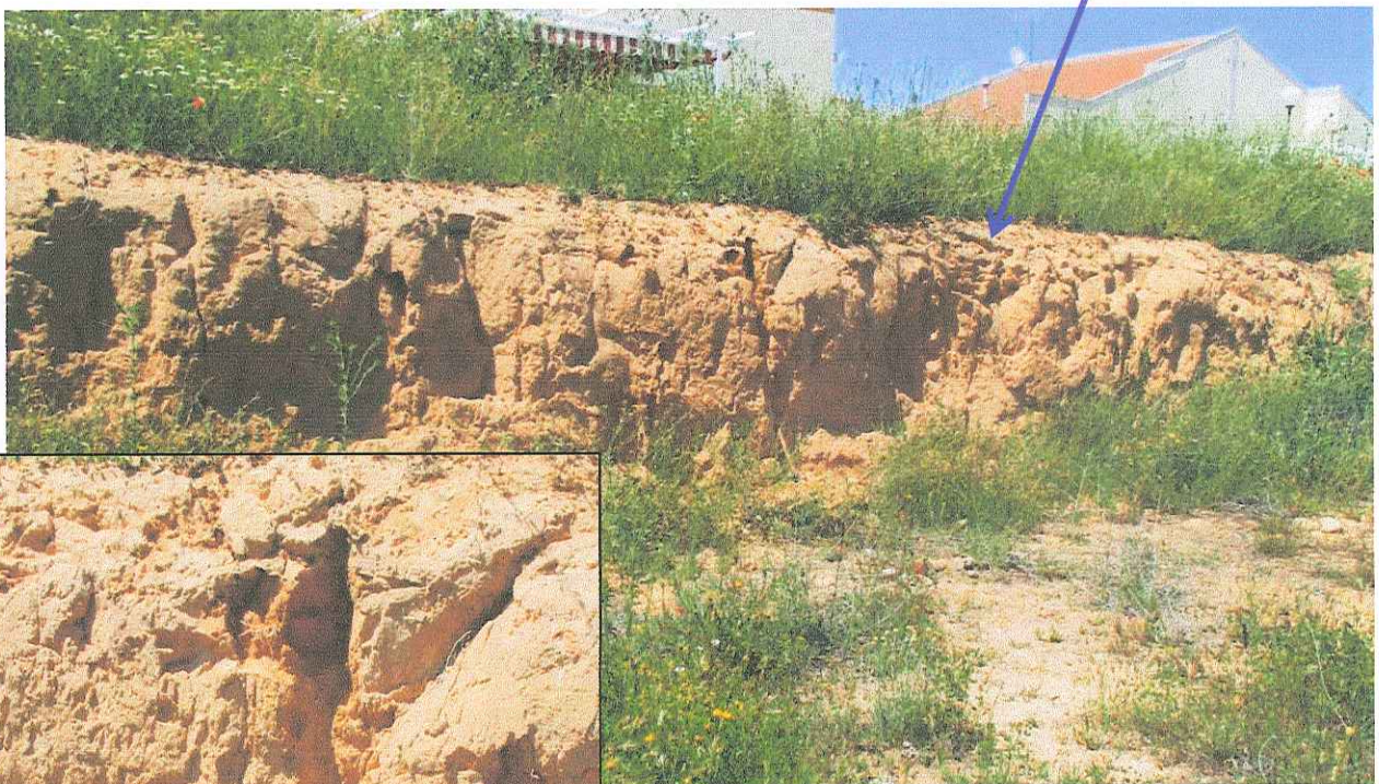
F.8. Pequeña excavación junto a la calle anterior en la zona de la terraza alta. Los suelos son arenas limosas. Talud subvertical estable.
