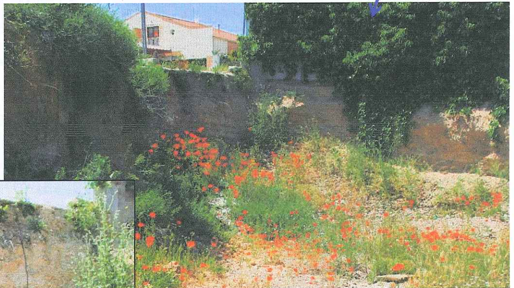
F.6. Excavación y detalle en la zona de pendiente. Niveles de terrazas: gravas y arenas limosas ligeramente cementadas. Talud subvertical estable.
