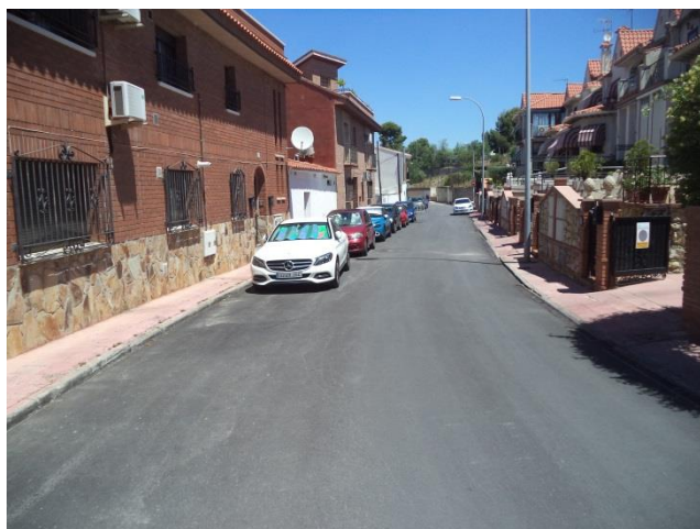
Fotografía 14: Calle Miguel de Unamuno a la altura del nº 20, hacia pares crecientes
