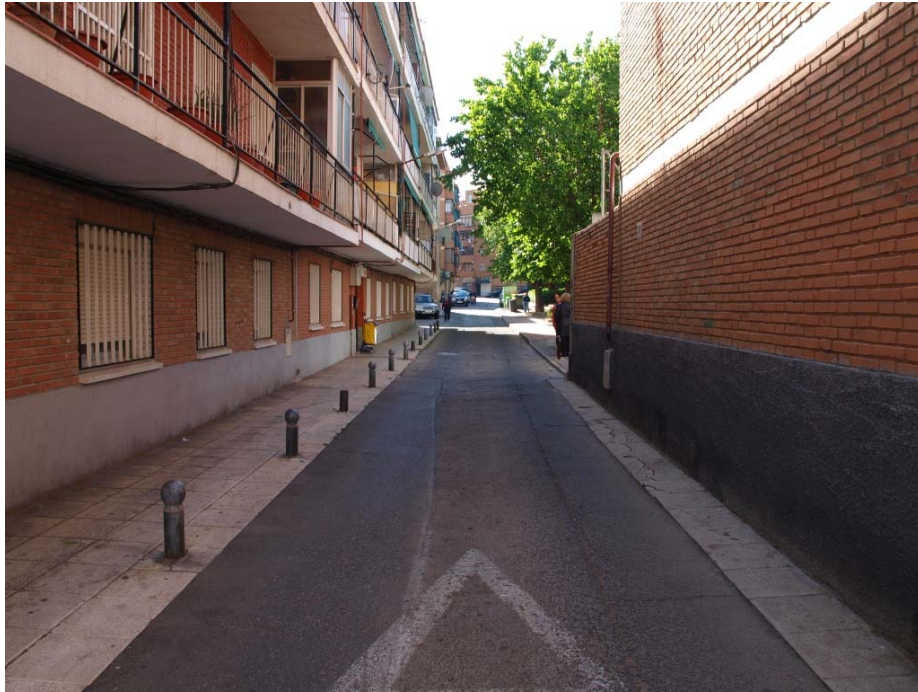
F11. Vista del inicio de la C/ Virgen del Rosario. Se observa una antigua zanja cubierta
