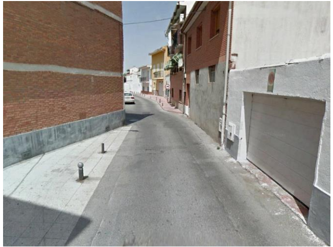
Fotografía 50: Calle Virgen del Pilar a la altura del nº 16, hacia pares crecientes
