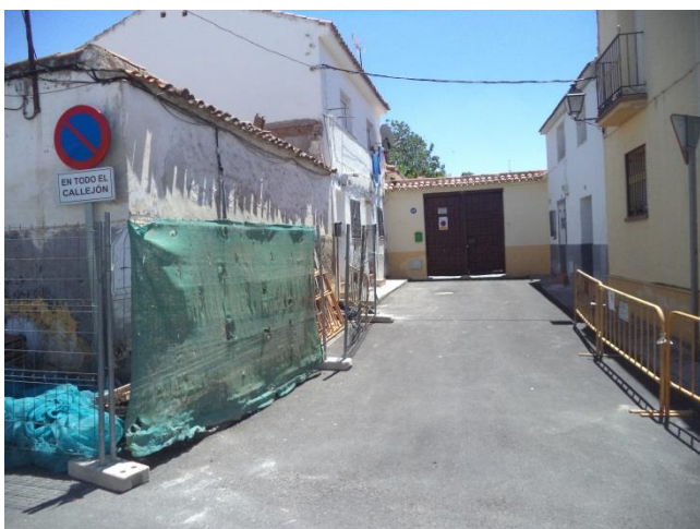
Fotografía 3: Callejón de la calle Grupo Escolar, donde se localizan los nº 8, 10 y 12 de esta calle
