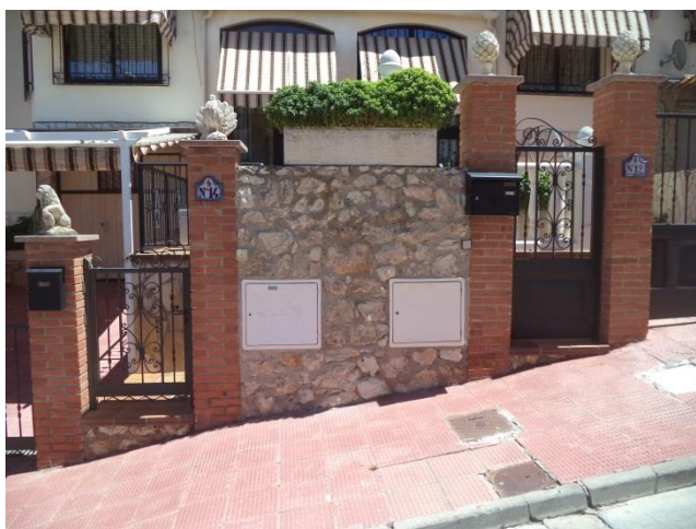
Fotografía 24: Armarios de registro en las fachadas de los nº 12 y 14 de la calle Nuestra Señora de la Esperanza
