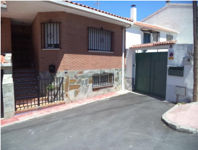
Fotografía 7: Vista a los nº 33 y 35 de la calle Grupo Escolar
