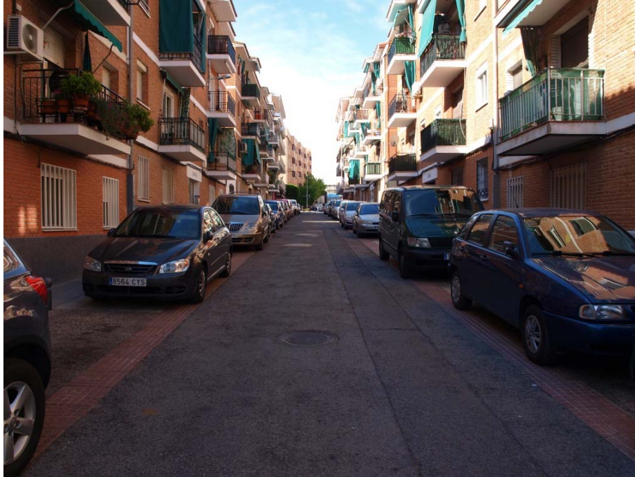
F5. Vista de la C/ de la Inmaculada Concepción. Se observa una antigua zanja cubierta
