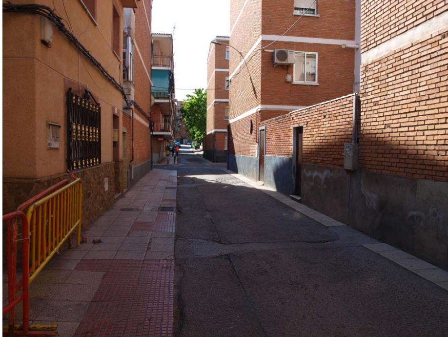
F9. Vista de la C/ Virgen del Pilar. Se observa una antigua zanja cubierta
