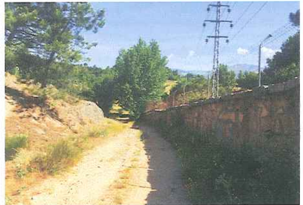
8 BAJADA DEL DEPÓSITO
