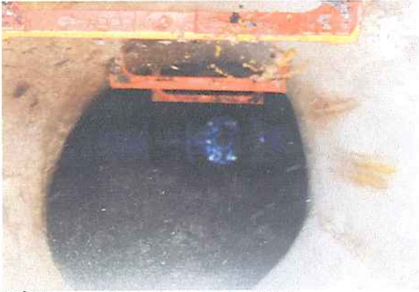
37 VÁLVULA EN CALLE LOPE DE VEGA
