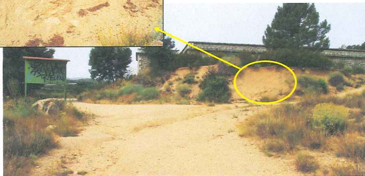
F.10/F.11. Desmonte en zona de roca alterada (jabre) junto al depósito.
