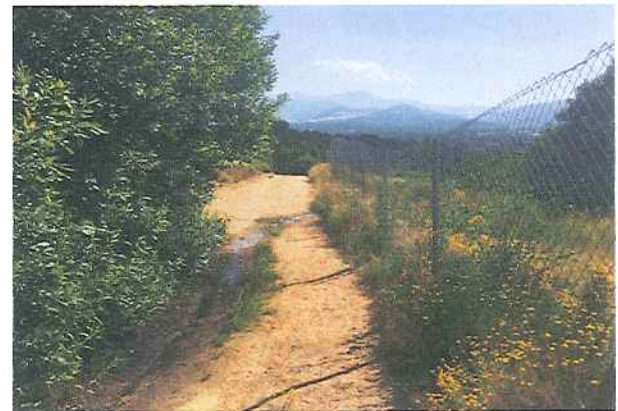
4 BAJADA DEL DEPÓSITO
