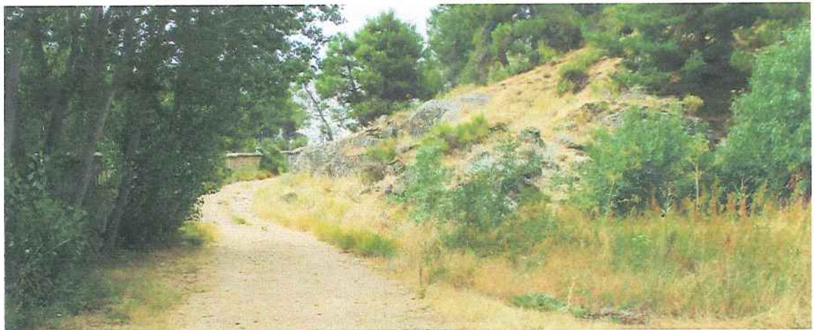
F.7. Entre la vaguada y el depósito el trazado discurre en pendiente por zona claramente rocosa.
