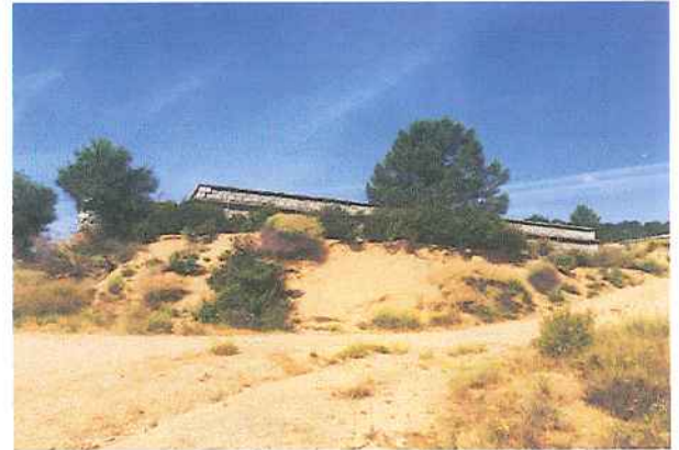
2 BAJADA DEL DEPÓSITO
