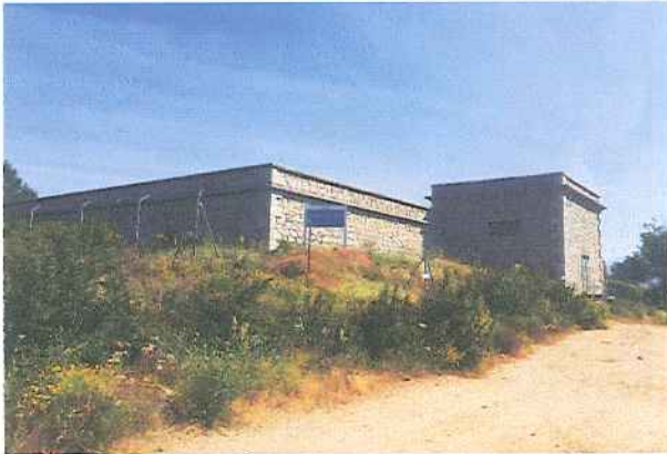
1 BAJADA DEL DEPÓSITO
