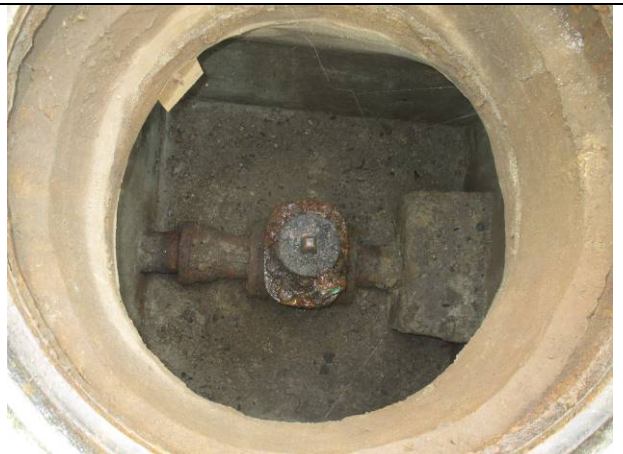
FOTO 10. Valvula existente en calle Monterrey.
