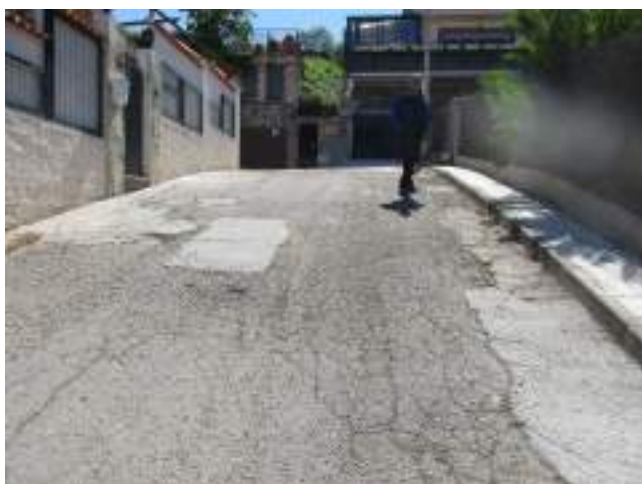
Fotografía 29: Vial de acceso a los nº 12 y 14 de las calle las Viñas, desde el vial principal
