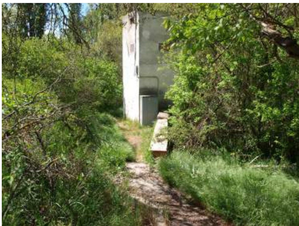
F29. Vista de la estación de bombeo
