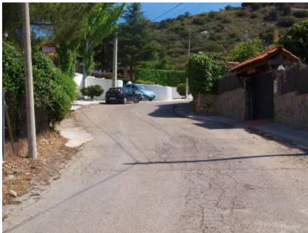
F9. Vista de la C/ Joaquín Dos Santos Ferreira a la altura del nº 7
