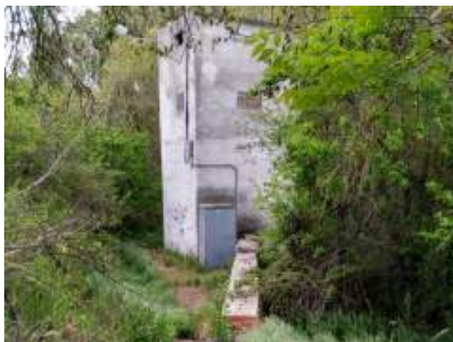
Fotografía 2: Aspecto exterior de la Estación Elevadora de Villar del Olmo
