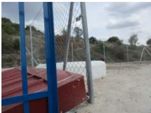
Fotografía 26: Imagen del interior del Depósito de Villar del Olmo
