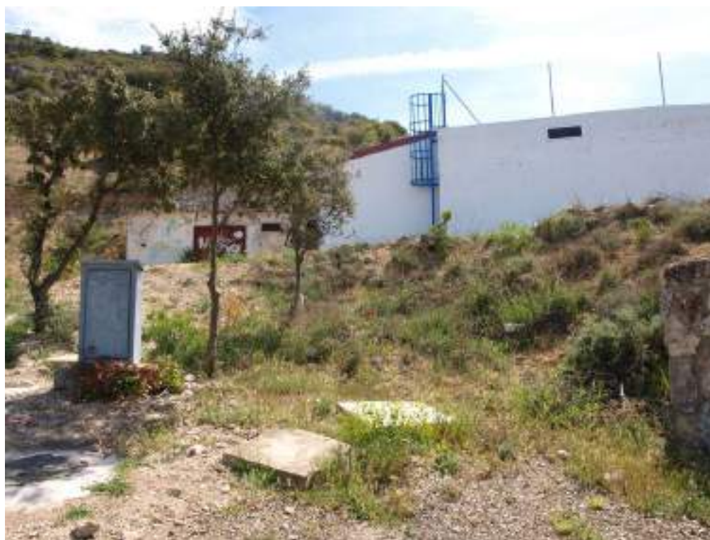
F20. Vista del final de la calle perpendicular a la C/ Joaquín Dos Santos Ferreira a la altura del nº 29
