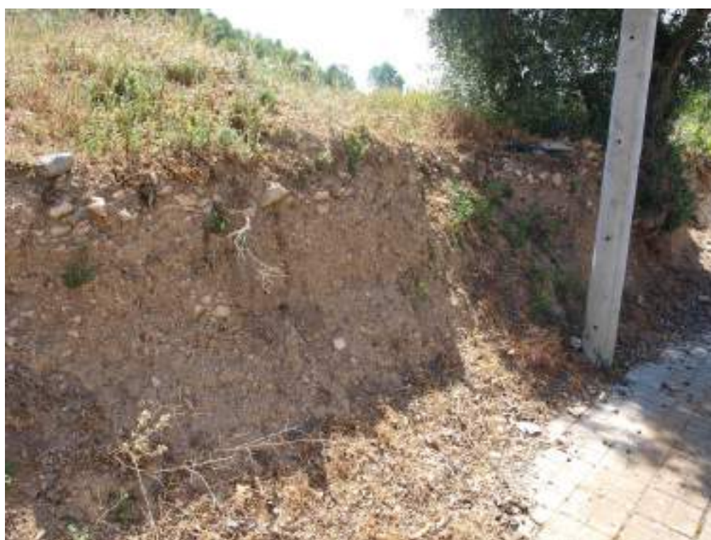
F6. Vista del corte del terreno del descampado anterior
