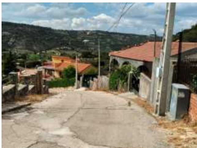
Fotografía 19: Calle Joaquín Dos Santos Ferreira a la altura del nº 29, pares decrecientes
