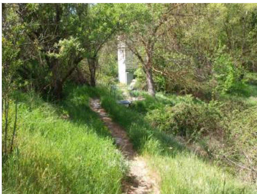
F28. Vista de la estación de bombeo
