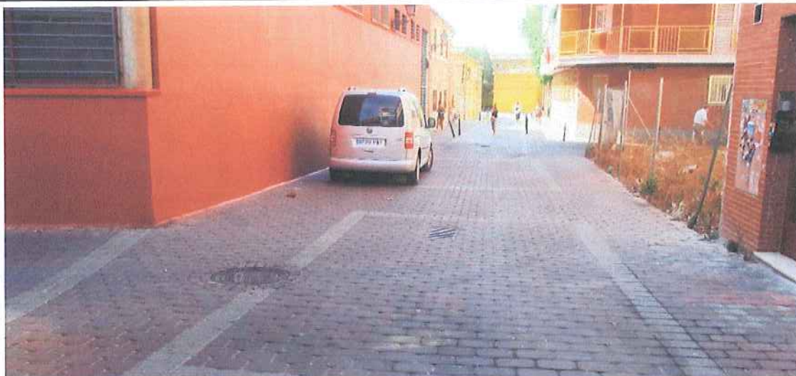
F.4. Vista de la calle Paso de Villamanrique, con ligera pendiente descendiendo hacia el sur.
