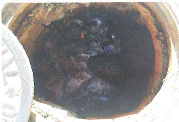
61 VÁLVULA EN CALLE DEL PUERTO DE BENASQUE
