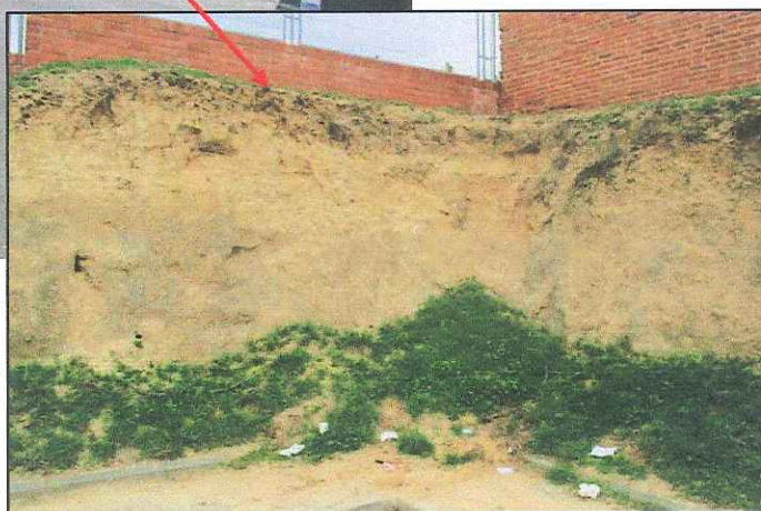
F.8/F.9. Otro tramo de la calle Andorra, con un desmonte de varios metros en arenas mas o menos arcillosas. Talud subvertical estable.
