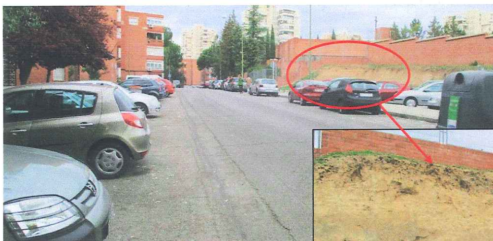
F.8/F.9. Otro tramo de la calle Andorra, con un desmonte de varios metros en arenas mas o menos arcillosas. Talud subvertical estable.
