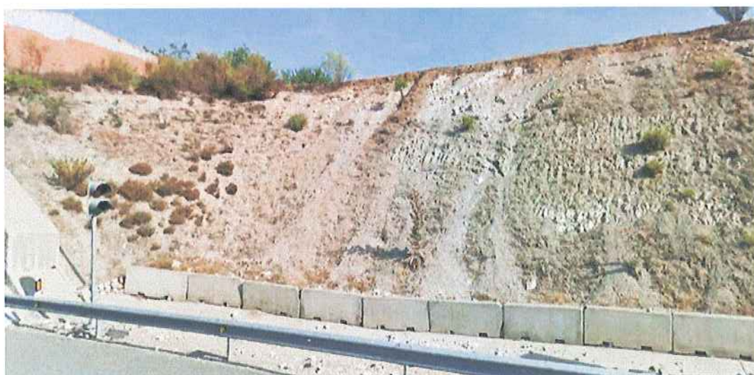
F.6. Corte del terreno en la excavación para el paso bajo la cañada de la Autopista R-3. Materiales arcillosos verdosos y rosáceos, con niveles carbonatados y presencia de sílex.
