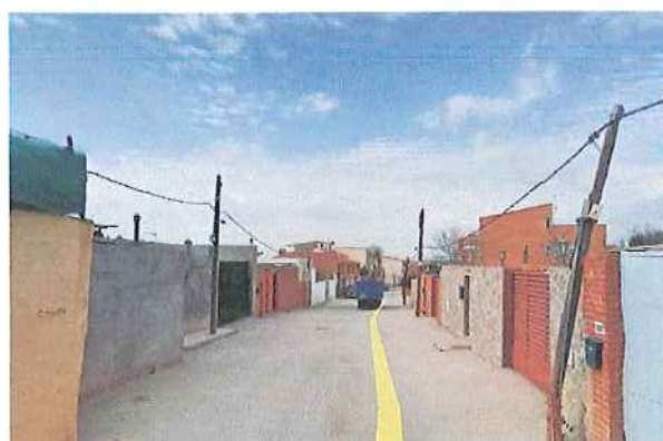
23 CAÑADA REAL DE MERINAS
