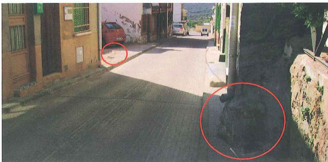
F.7. Calle Bonar, con apreciable pendiente y vestigios de roca en algunos puntos.
