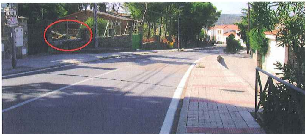
F.1. Vista general del trazado por la Ronda Este, entrando a la población desde Cadalso de los Vidrios. Se señala a la izquierda una parcela con claros afloramientos de granito.
