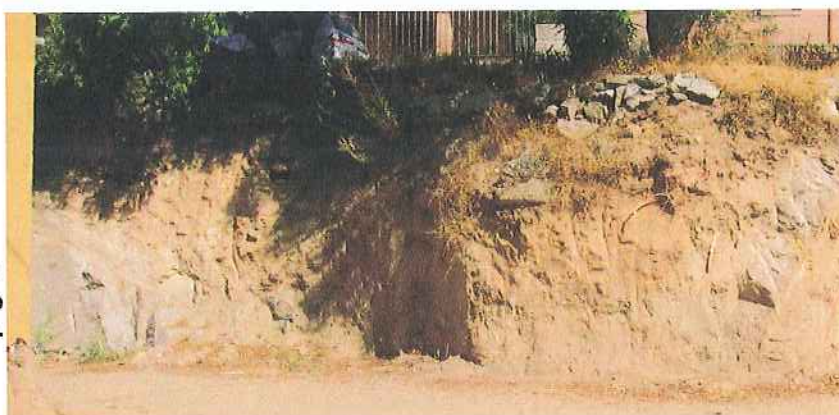
F.2. Excavación con talud subvertical en granito más o menos alterado, en el entorno del extremo norte del trazado.
