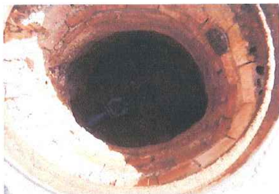
27 VÁLVULA CALLE DEL CHOPO
