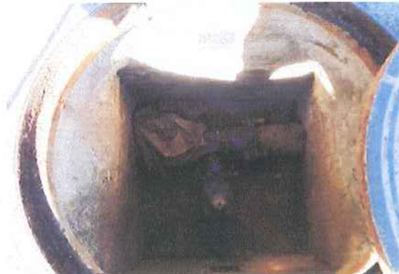
9 DESAGÜE AVENIDA DE LA CONSTITUCIÓN
