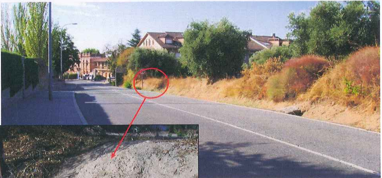
F.2. Pequeño desmonte en la margen Oeste de la carretera de San Martín de Valdeiglesias. Detalle de suelos residuales arenosos (jabre) con restos de roca en descomposición.
