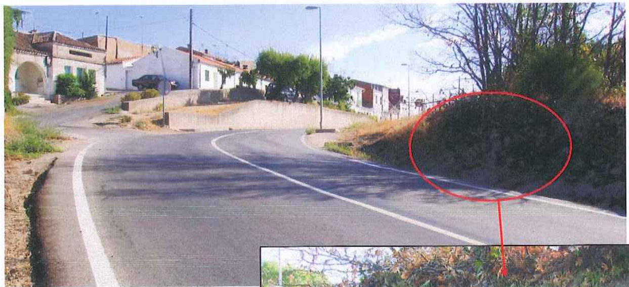
F.7. Zona de actuación a la salida por la carretera de Cenicientos. Disposición aterrazada con varios muros de contención, lo que implica zonas de posibles rellenos. Presencia de roca junto a la cuneta.
