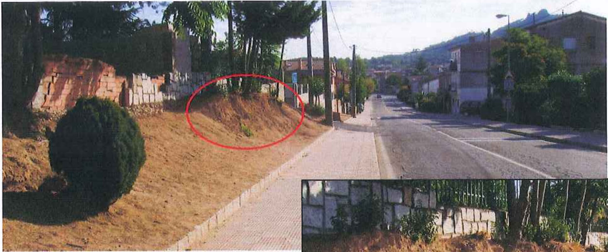
F.1. Aspecto de la carretera de Rozas de Puerto Real, a media ladera, con pequeños desmontes a la izquierda (Norte) y posibles rellenos a la derecha. Detalle de desmonte en suelos residuales arenosos (jabre) de alteración del sustrato granítico.
