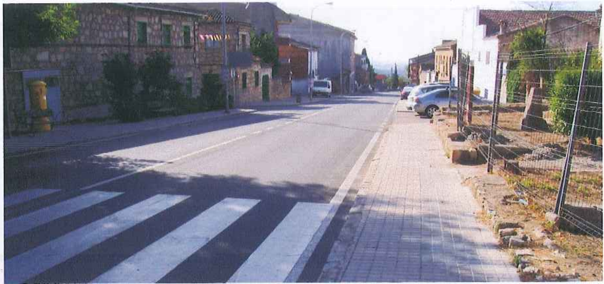
F.3. Vista general de la zona de actuación en la Avda. de la Constitución. Trazado urbano en pendiente.
