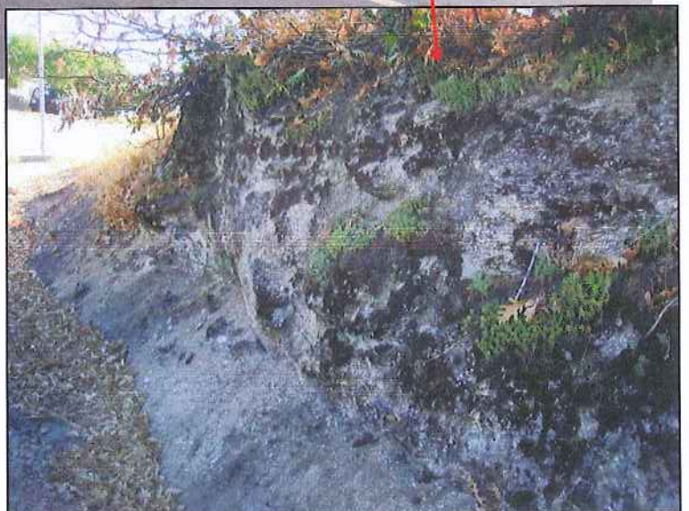
F.7. Zona de actuación a la salida por la carretera de Cenicientos. Disposición aterrazada con varios muros de contención, lo que implica zonas de posibles rellenos. Presencia de roca junto a la cuneta.
