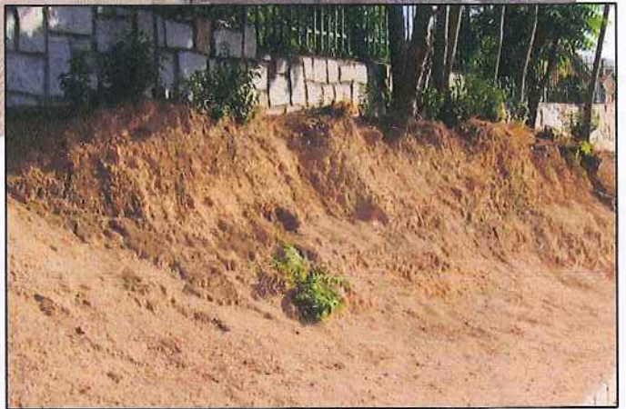
F.1. Aspecto de la carretera de Rozas de Puerto Real, a media ladera, con pequeños desmontes a la izquierda (Norte) y posibles rellenos a la derecha. Detalle de desmonte en suelos residuales arenosos (jabre) de alteración del sustrato granítico.
