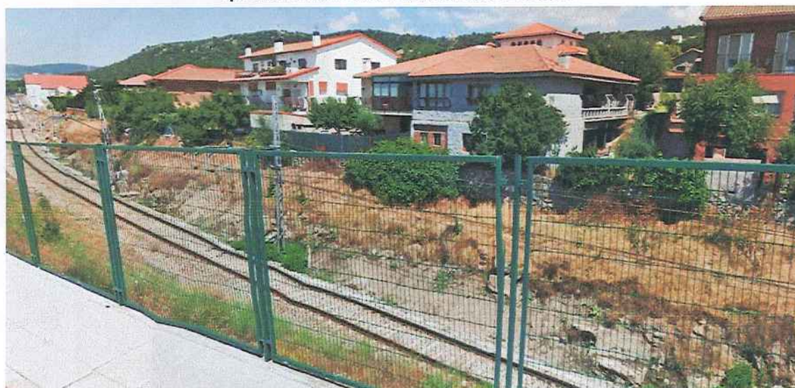
F.6. Vista general de la trinchera del ferrocarril al sur de la zona de actuación. Se aprecian zonas de roca y recubrimientos de espesor variable de suelos con bolos y bloques.
