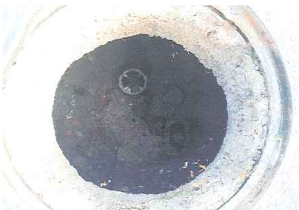
21 VÁLVULA CALLE DE LA FUENTE
