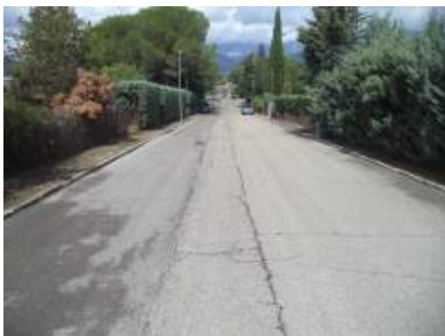
Fotografía 59: Avenida Soto a la altura del nº 61, pares decrecientes.
