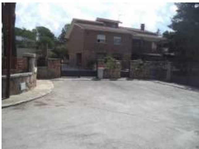
Fotografía 43: Final del testero a la altura del nº 1 de la calle de Málaga.
