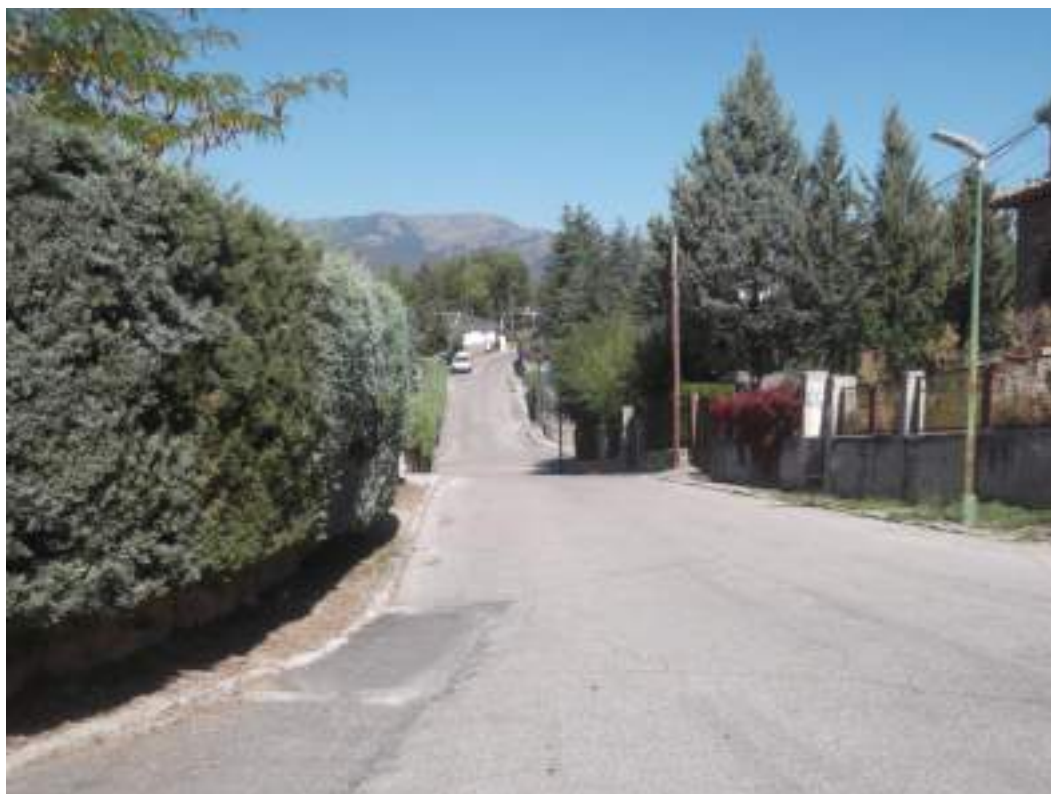
F16. Tramo 60 FC Vista Avenida de Santander esquina C/Guadalajara
