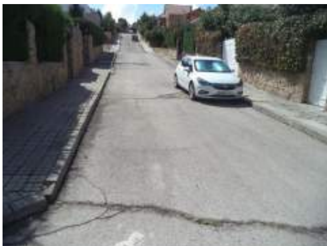
Fotografía 7: Calle del Monte Zamorano desde el testero a la altura del nº 1, pares crecientes.
