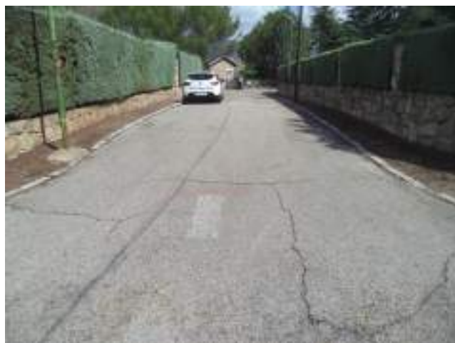
Fotografía 62: Calle Murcia desde el cruce con la Avenida Soto.
