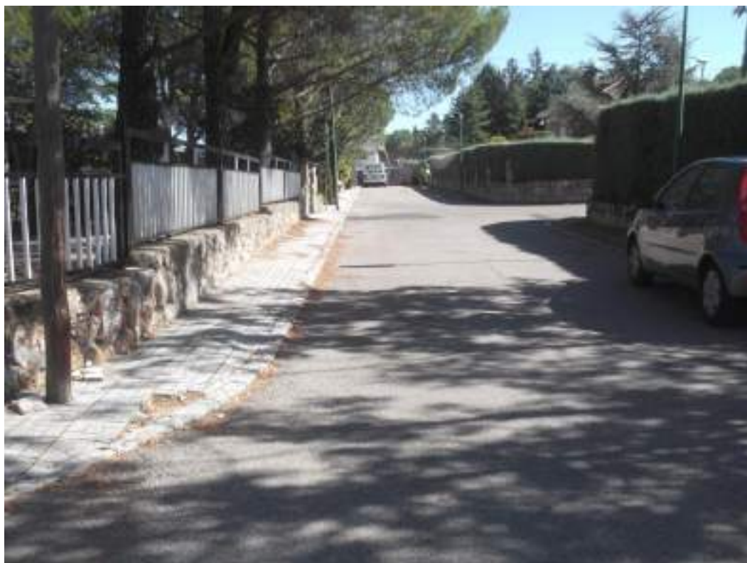
F12. Tramo 100 FC Vista C/Alicante
