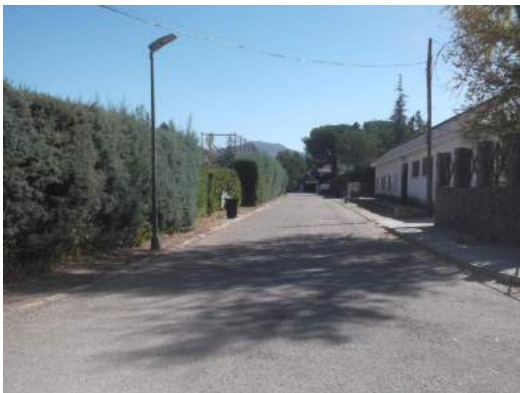
F1. Tramo 60 FC Vista C/Salamanca esquina Avenida de Madrid
