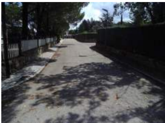
Fotografía 67: Calle Alicante desde el testero a la altura del nº 1, pares crecientes.
