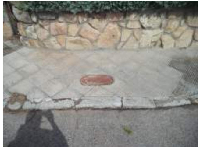
Fotografía 50: Hidrante HI.34GF-52 a la altura del nº 19 de la Avenida Soto.
