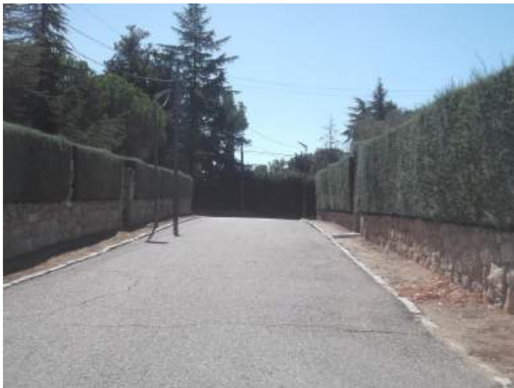
F13. Tramo 100 FC Vista C/Murcia esquina C/Alicante
