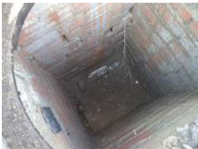
Fotografía 4: Válvula VA.34GF-63 en el cruce de las calles Paseo de Monte Real y Monte Cervino.
