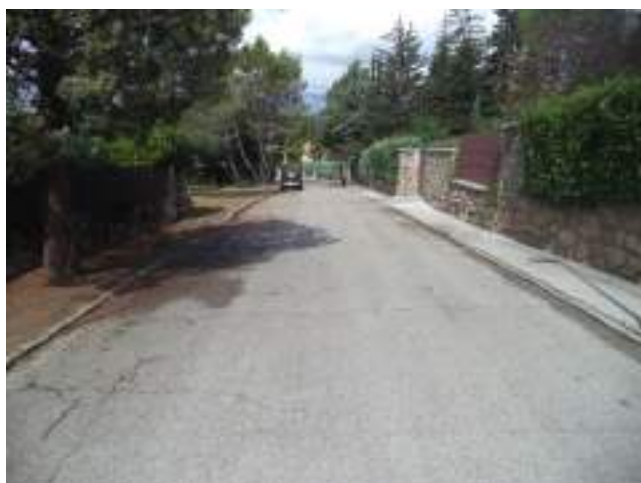
Fotografía 76: Avenida Bertolez a la altura del nº 29, pares crecientes.
