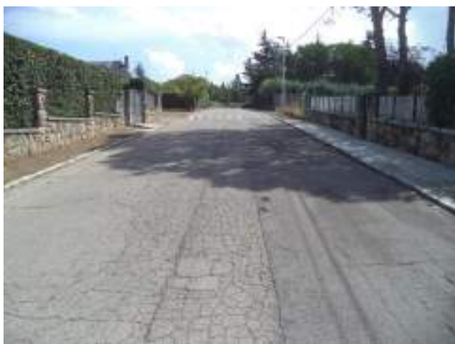
Fotografía 47: Avenida Soto desde el cruce con la calle de Málaga, pares crecientes.
