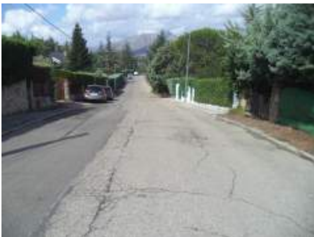
Fotografía 53: Avenida Soto a la altura del nº 37, pares decrecientes.
