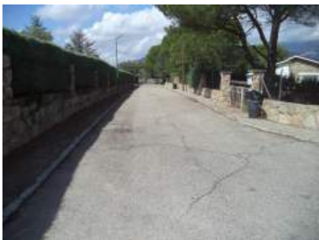
Fotografía 69: Calle Alicante desde el testero a la altura del nº 9, pares decrecientes.
