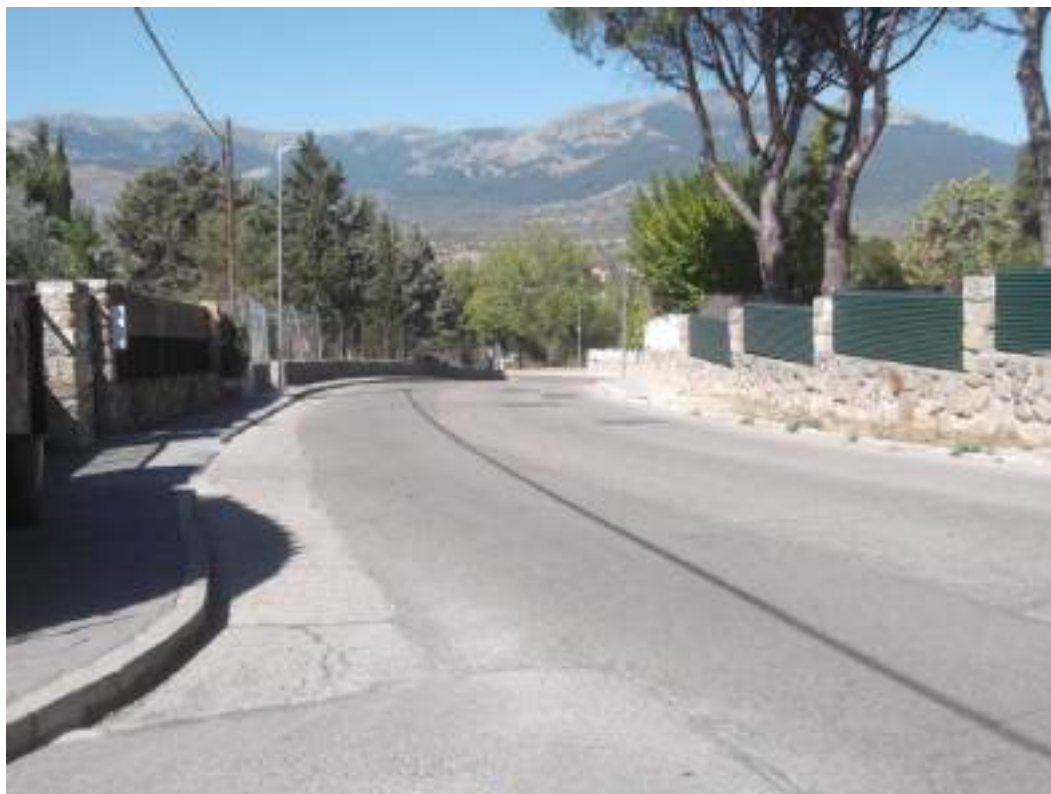
F17. Tramo 100 FC Vista Avenida Soto esquina Avenida de Santander hacia el noroeste
