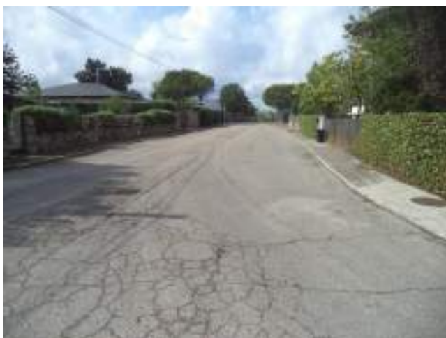
Fotografía 84: Avenida de Madrid desde el cruce con la Avenida Soto, pares decrecientes.
