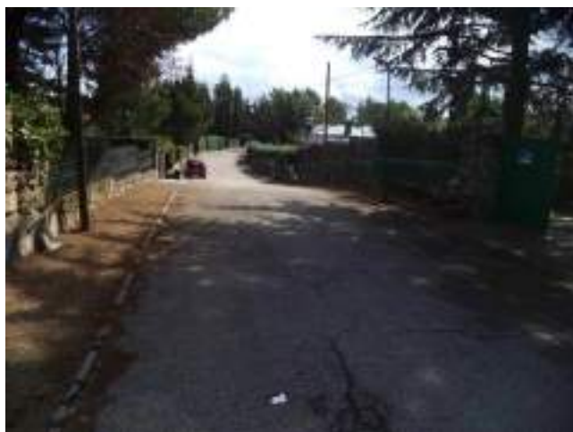
Fotografía 74: Avenida Bertolez a la altura del nº 15, pares crecientes.
