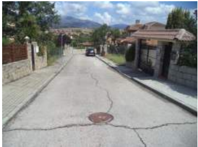
Fotografía 32: Calle del Monte Oiz desde el testero a la altura del nº 7, pares decrecientes.
