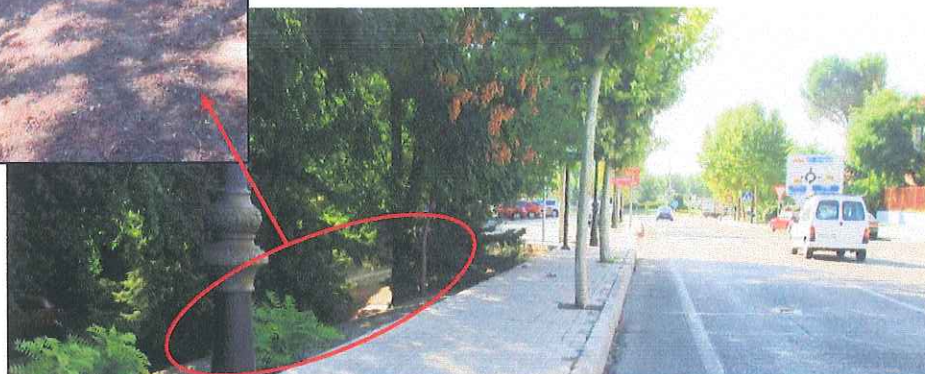
F.1/F.2. Aspecto del trazado en zona urbana, en el tramo de la carretera de Cobeña. Detalle de un talud (por el entorno topográfico, con cotas crecientes de izda a dcha., parece de desmonte) donde se aprecian suelos arenos-arcillosos con algunos cantos.
