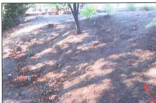
F.1/F.2. Aspecto del trazado en zona urbana, en el tramo de la carretera de Cobeña. Detalle de un talud (por el entorno topográfico, con cotas crecientes de izda a dcha., parece de desmonte) donde se aprecian suelos arenos-arcillosos con algunos cantos.
