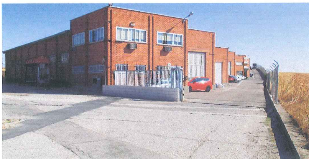
F.8. Zona del ramal del Polígono El Cabril.
