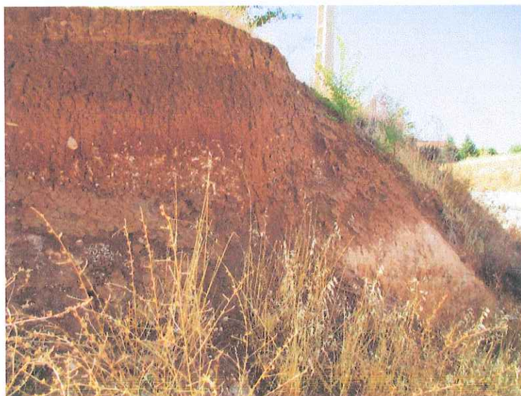
F.12. Desmorte subvertical en camino junto a la vía de servicio en sentido norte, próximo a la zona de la fotografía anterior. Suelos arcillo-arenosos beis claros, más rojizos y alterados en superficie.
