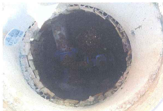
57 DESAGÜE CALLE DE LA AURORA
