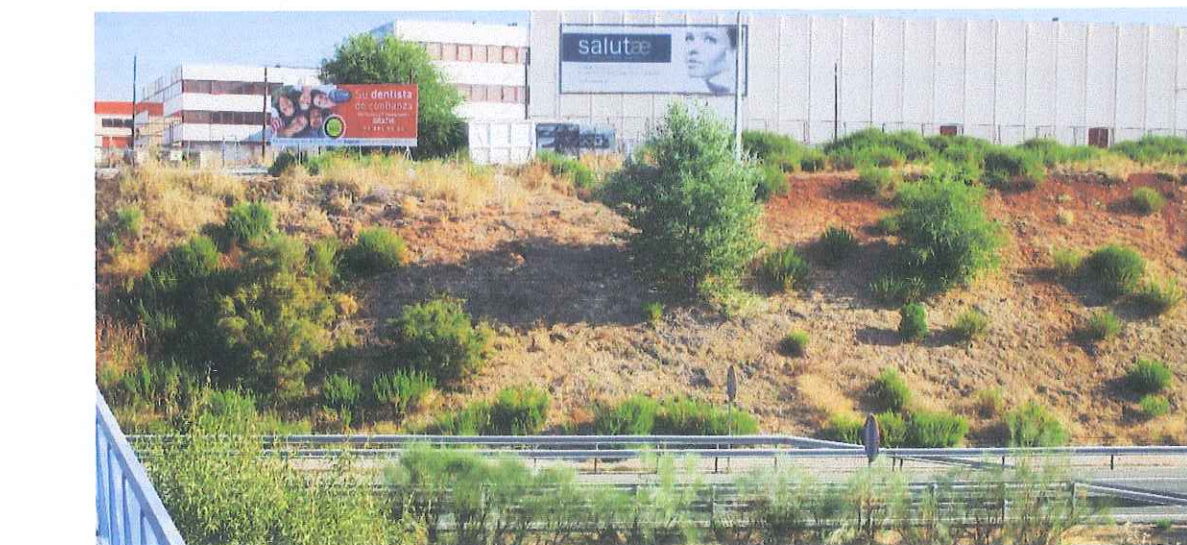
F.13. Aspecto del desmorte para la autopista R-2. Suelos similares a los anteriores.
