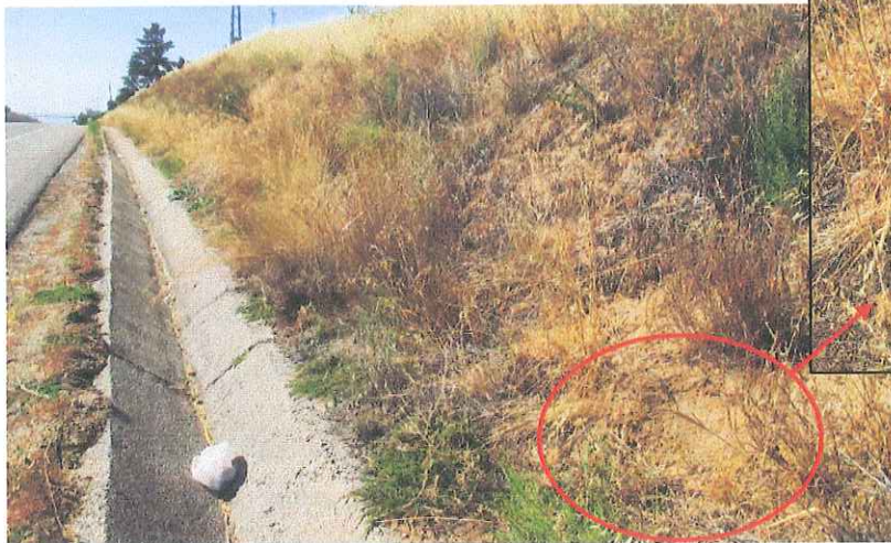
F.11. Talud de desmorte junto a la vía de servicio en una zona no edificada. Se aprecian suelos areno-arcillosos de coloración beis.
