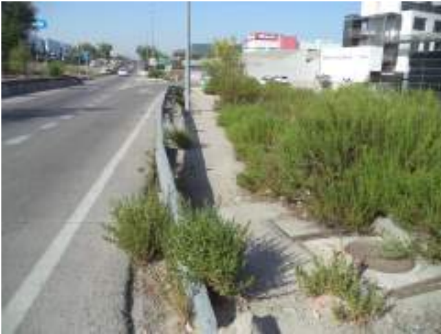
Fotografía 19: Carretera de Fuencarral (M-603) a la altura del nº 14, pares crecientes.
