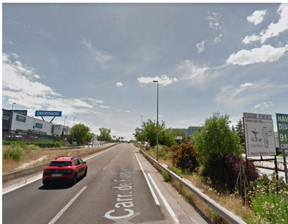
F7. Tramo 500 FD. Carretera de Fuencarral
