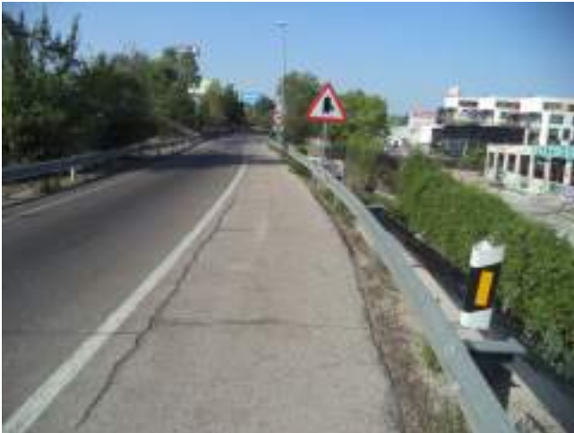
Fotografía 21: Carretera de Fuencarral (M-603) a la altura del nº 10, pares crecientes.
