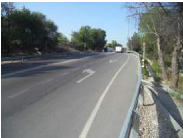
Fotografía 23: Carretera de Fuencarral (M-603) al inicio del nº 10, pares crecientes.
