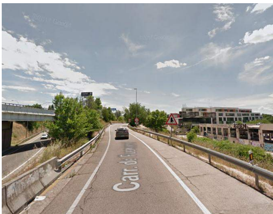
F6. Tramo 600 FG. Vista del inicio de la Carretera de Fuencarral
