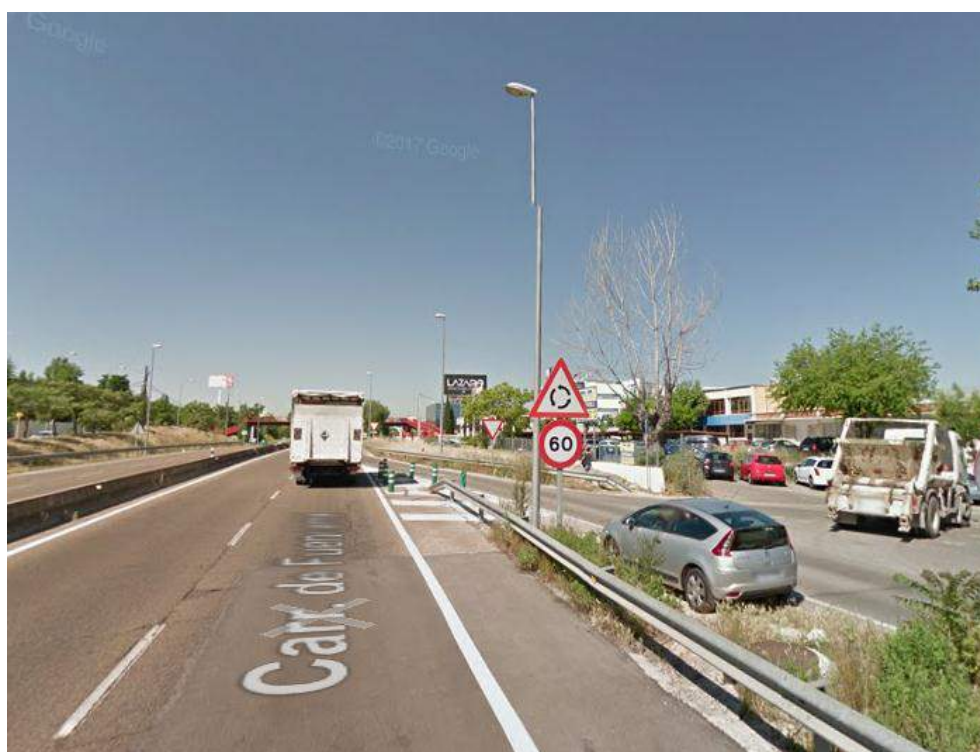
F8. Tramo 500 FG. Carretera de Fuencarral
