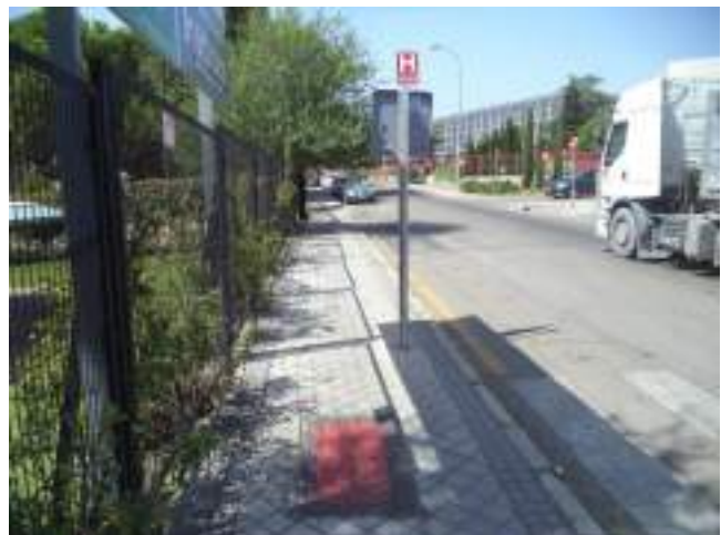
Fotografía 58: Hidrante HI.44NM-270 a la altura del nº 17 de la Avenida de la Industria.
