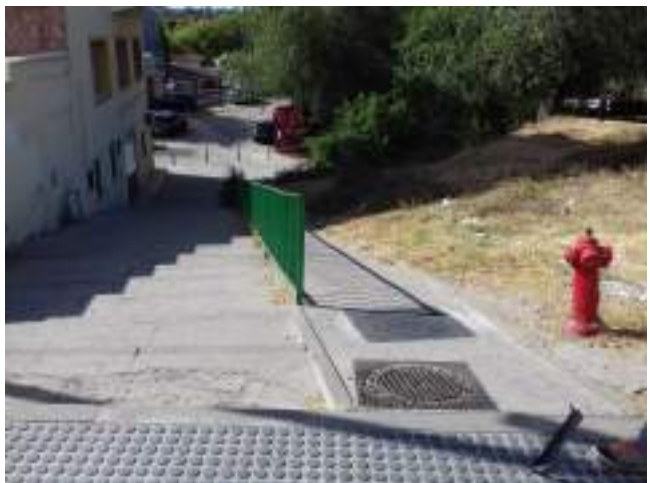
Fotografía 70: Hidrante HI.44MN-1062 en el cruce de la calle Badajoz y el Bulevar de Salvador Allende.
