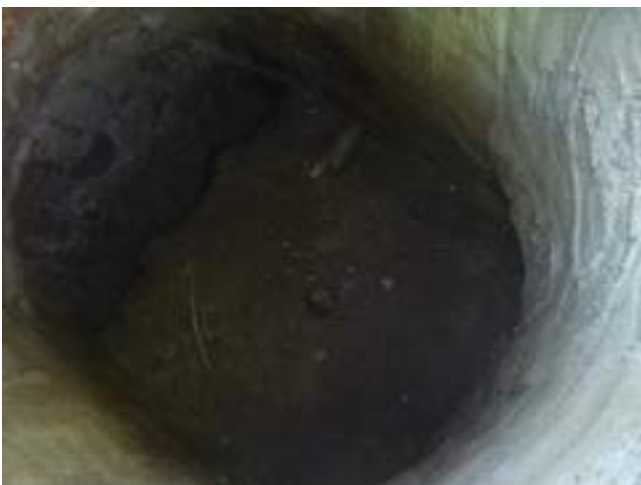
Fotografía 11: Desagüe DE.44NM-8 a la altura del nº 42 de la carretera de Fuencarral (M-603).
