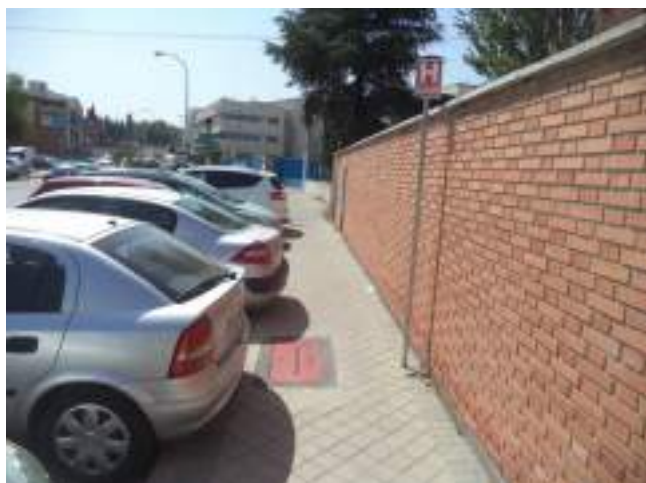
Fotografía 37: Hidrante HI.44NM-209 a la altura del nº 5 de la calle de Francisco Gervás.
