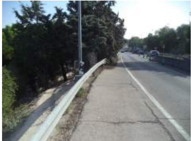
Fotografía 22: Carretera de Fuencarral (M-603) a la altura del nº 10, pares decrecientes.
