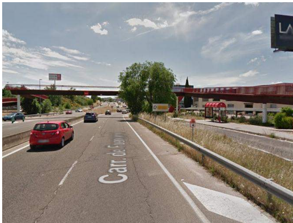
F9. Tramo 500 FG. Carretera de Fuencarral
