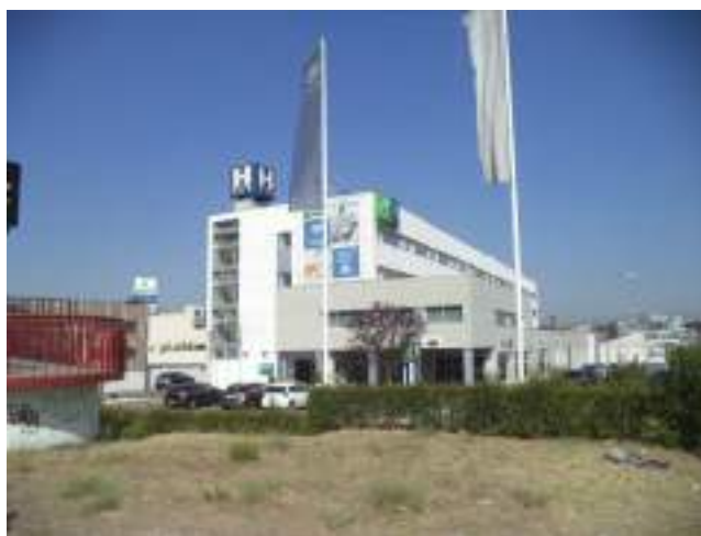
Fotografía 4: Hotel Holiday Inn a la altura del nº 1 de la calle de la Metalurgia.
