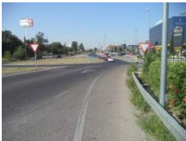
Fotografía 2: Rotonda de conexión de la carretera de Fuencarral (M-603) con la calle de Francisco Gervás.
