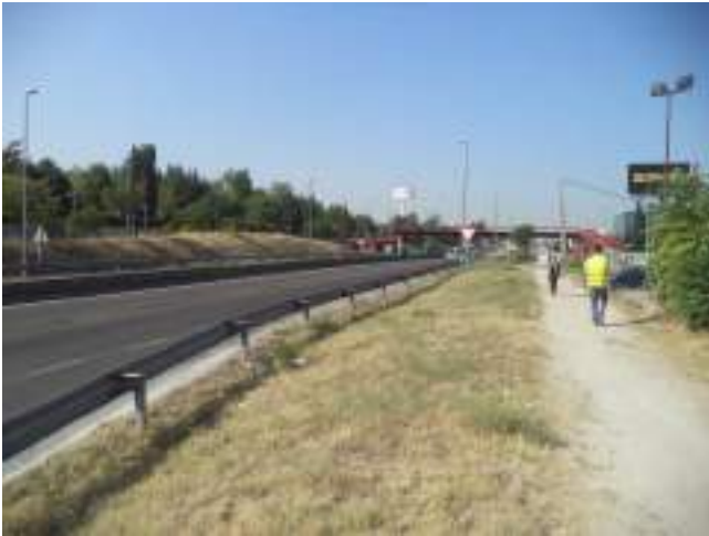
Fotografía 7: Carretera de Fuencarral (M-603) a la altura del nº 46, pares crecientes.
