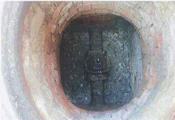
33 VÁLVULA EN LA CALLE DE GARCÍA DE PAREDES
