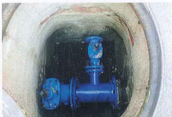
85 DESAGÜE EN EL CRUCE DE LA CALLE DE MODESTO LAFUENTE CON LA CALLE DE GARCÍA DE PAREDES
