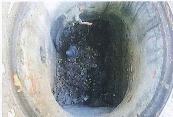
44 DESAGÜE EN EL CRUCE DE LA CALLE DE PONZANO CON LA CALLE DE BRETÓN DE LOS HERREROS
