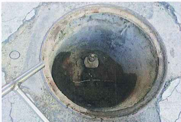
55 DESAGÜE EN EL CRUCE DE LA CALLE DE VARGAS CON LA CALLE DE JOSÉ ABASCAL
