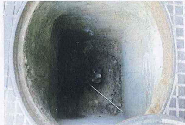
82 DESAGÜE EN LA CALLE DE MODESTO LAFUENTE
