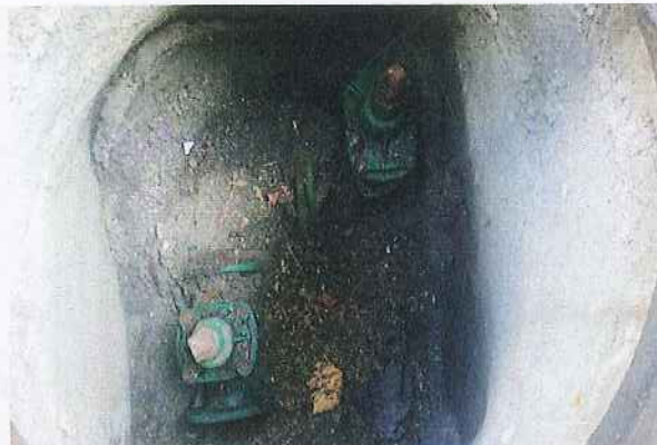
26 DESAGÜE EN LA CALLE DE JOSÉ ABASCAL
