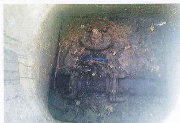
89 DESAGÜE EN EL CRUCE DE LA CALLE DE FERNÁNDEZ DE LA HOZ CON LA CALLE DE VIRIATO
