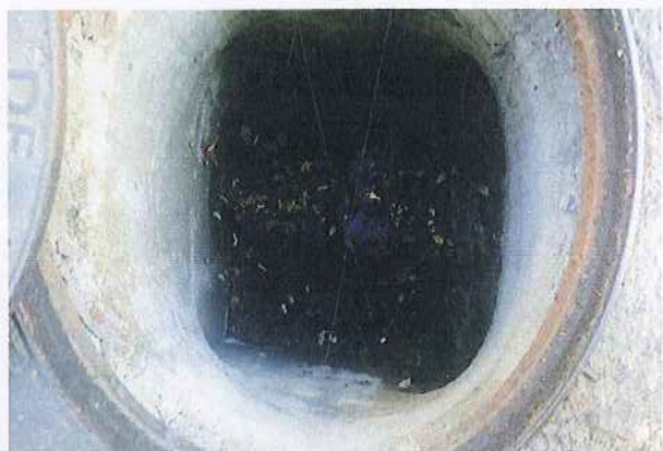
45 VÁLVULA EN EL CRUCE DE LA CALLE DE PONZANO CON LA CALLE DE BRETÓN DE LOS HERREROS
