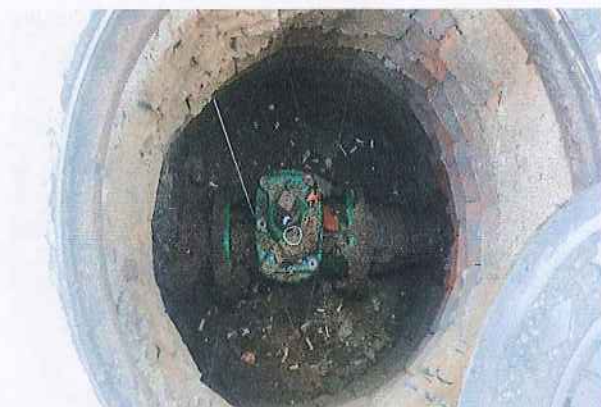
57 VÁLVULA EN EL CRUCE DE LA CALLE DE LAS VIRTUDES CON LA CALLE DE JOSÉ ABASCAL
