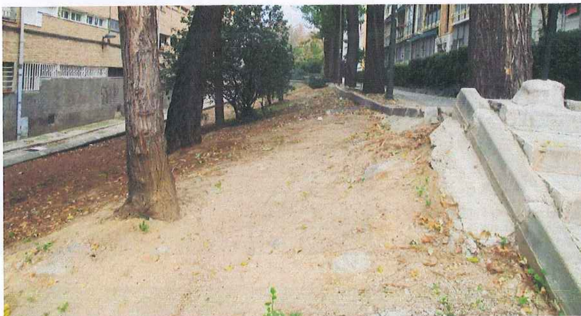
F.2. Talud en materiales arenosos entre bloques a distintos niveles
