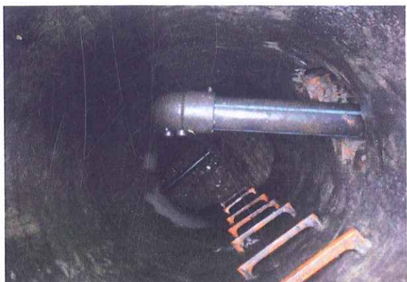
51 POZO CONEXIÓN GALERÍA EN CALLE FÓSFORO
