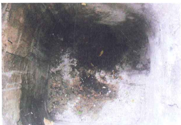
59 DESAGÜE DE-54JI-469 EN CALLE MÁRMOL
