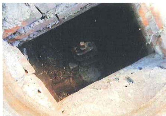
30 DESAGÜE CALLE DE VITAL AZA
