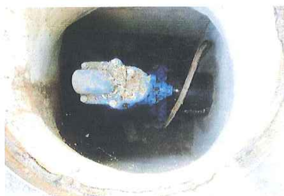
47 DESAGÜE CALLE DE LOS HERMANOS GÓMEZ
