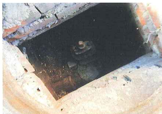
30 DESAGÜE CALLE DE VITAL AZA
