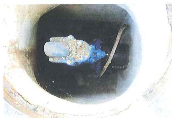
47 DESAGÜE CALLE DE LOS HERMANOS GÓMEZ
