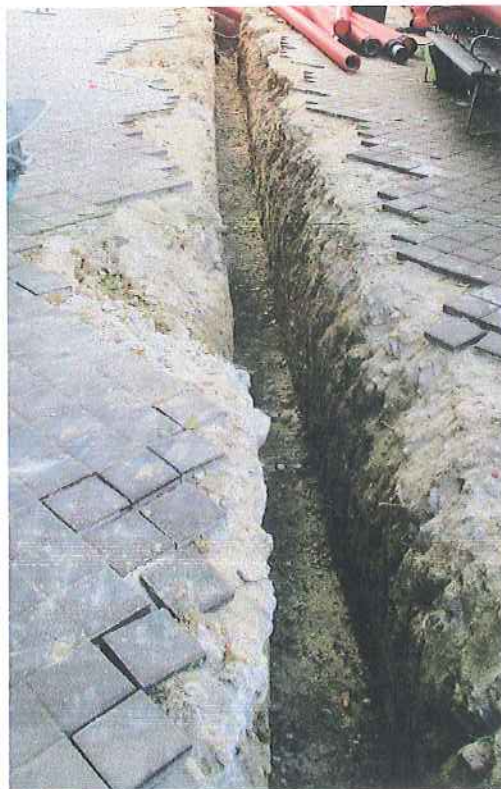
F.3. Pequeña zanja junta a la calle Virgen de la Alegría. Se aprecian suelos areno-arcillosos con alteración superficial.
