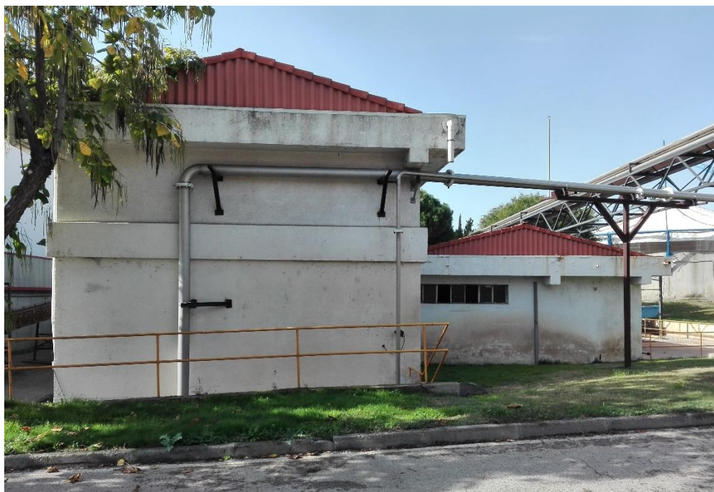
Tubería impulsión escurridos
