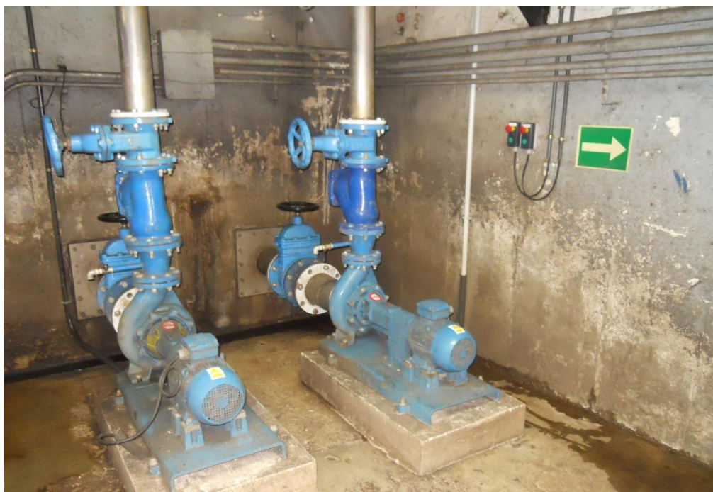
Bombas de impulsión de escurridos de centrifugas
