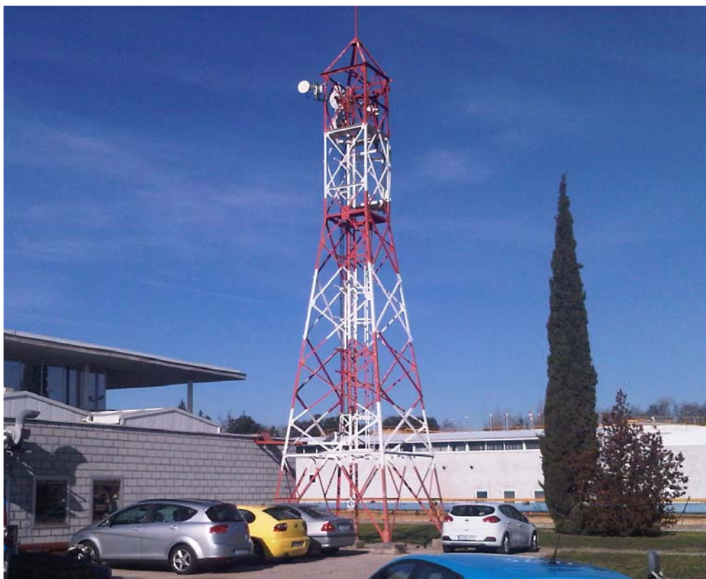
Antena existente a mantener, cuya cimentación se recalza
