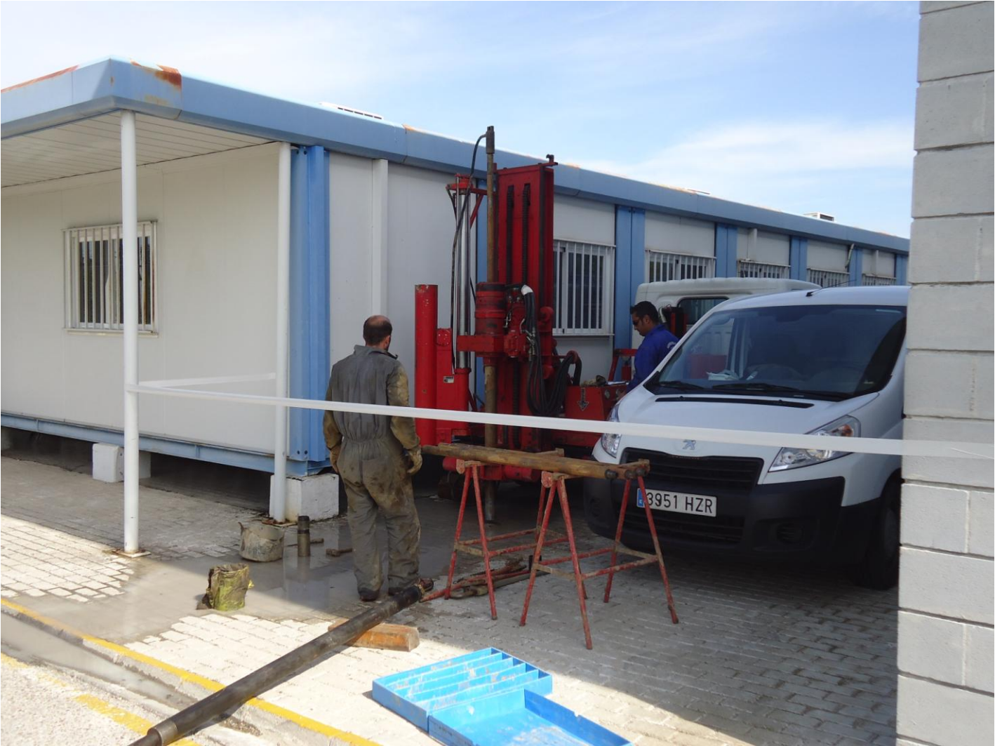
VISTA DE LA EJECUCIÓN DEL SONDEO MECÁNICO.
