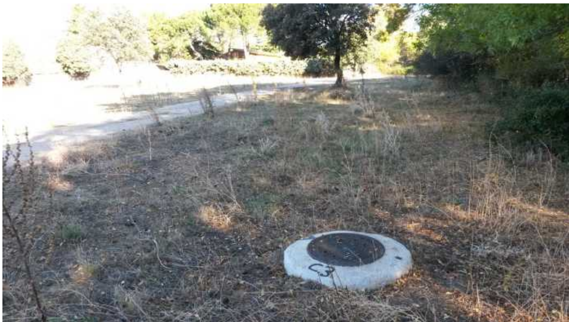
Fotografía 1: Pozo N-1 punto de partida del nuevo tramo del colector C-3.
