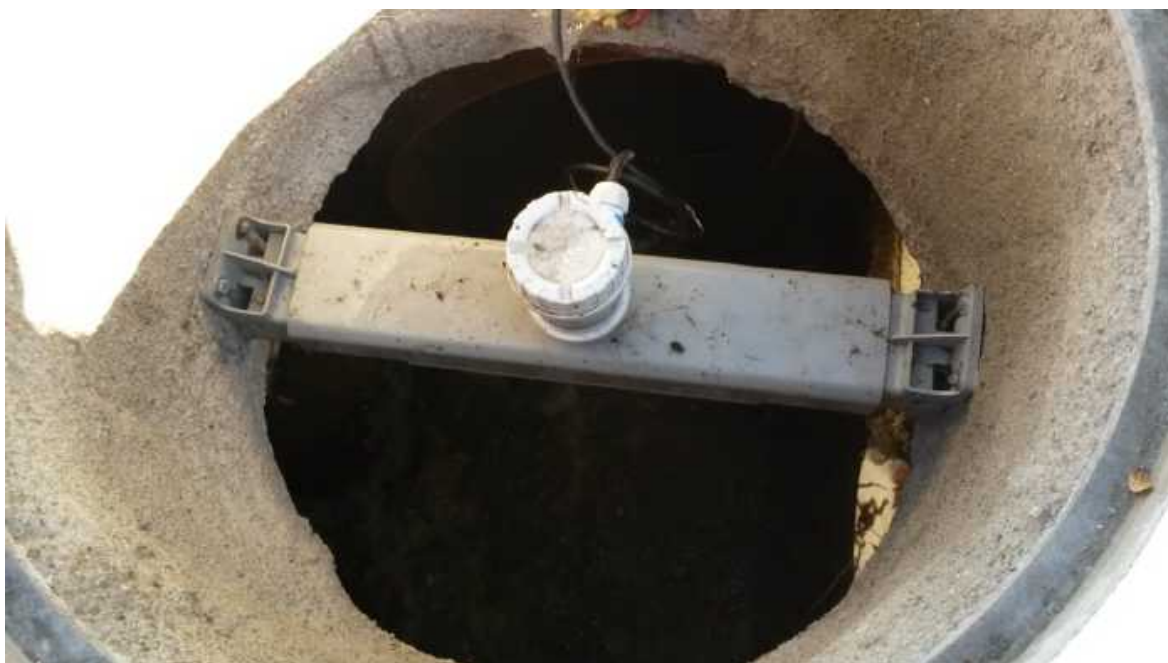
Fotografía 4: Sonda de nivel a trasladar al nuevo aliviadero.
