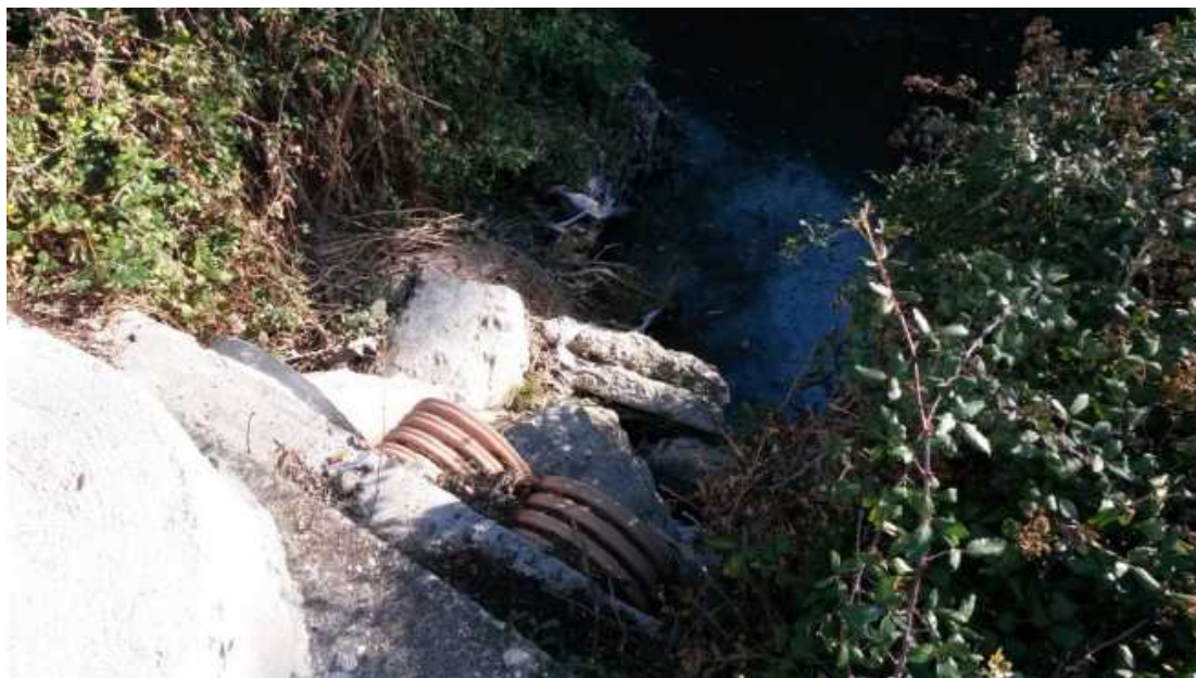
Fotografía 3: Punto de vertido del antiguo aliviadero al cauce del arroyo de la Poveda.
