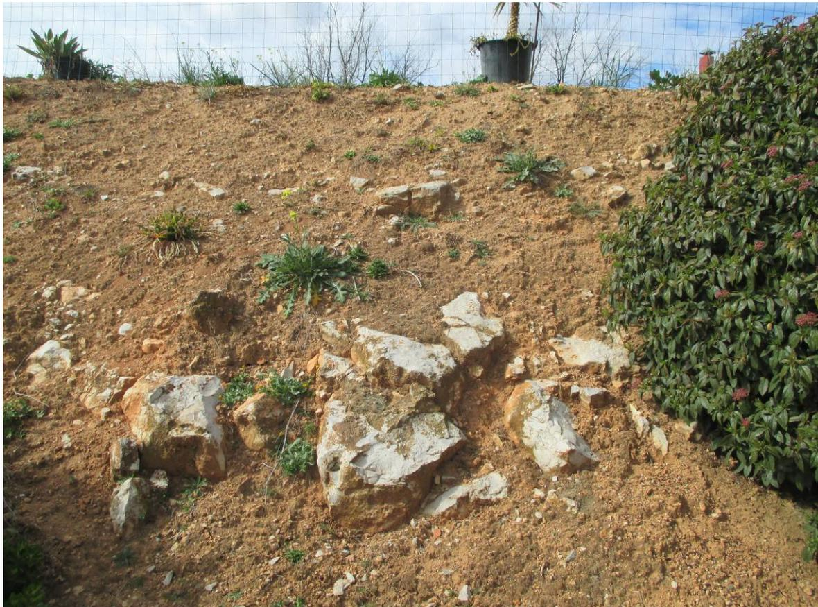
Vista general de la zona alta del trazado de la Actuación 3 y detalle del terreno en el talud de desmonte de la carretera: bloques y bolos residuales de caliza en una matriz arcillosa procedente de la alteración de la roca original.
