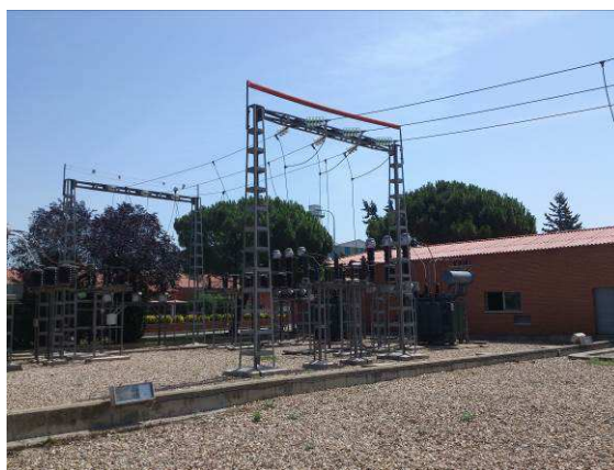
Líneas de entrada de energía a 45kV y transformadores de 2500kVA
