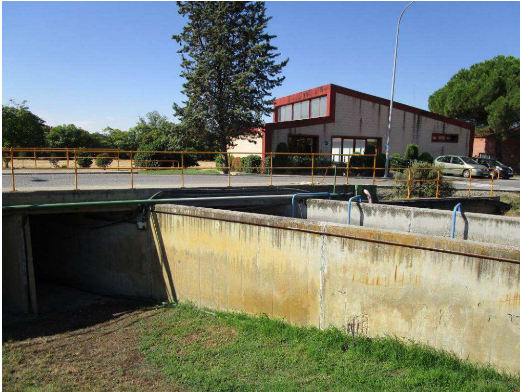
Foto 23. Paso de vial sobre canal de agua a decantación, sobre el que pasarán los nuevos cables de media tensión, canalizados mediante bandeja metálica adosada en vertical al perfil del puente del vial.
