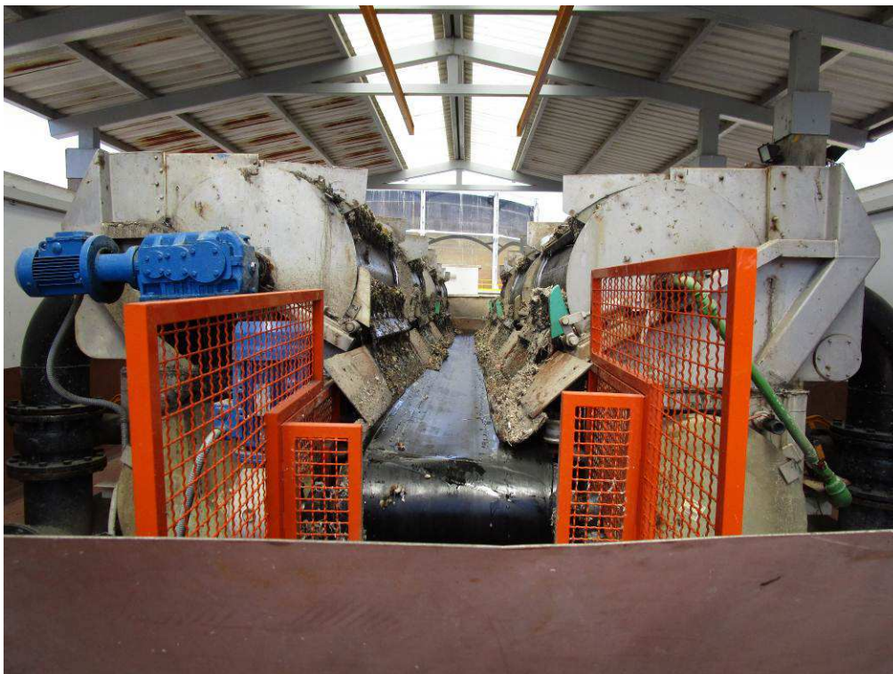
Foto 14. Tamices rotativos de fangos existentes.
