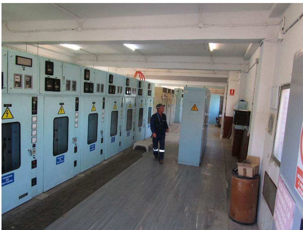
Foto 22. Interior edificio subestación. Armario de distribución a 6,6kV, en el que se realizarán las modificaciones de cableado previstas.
