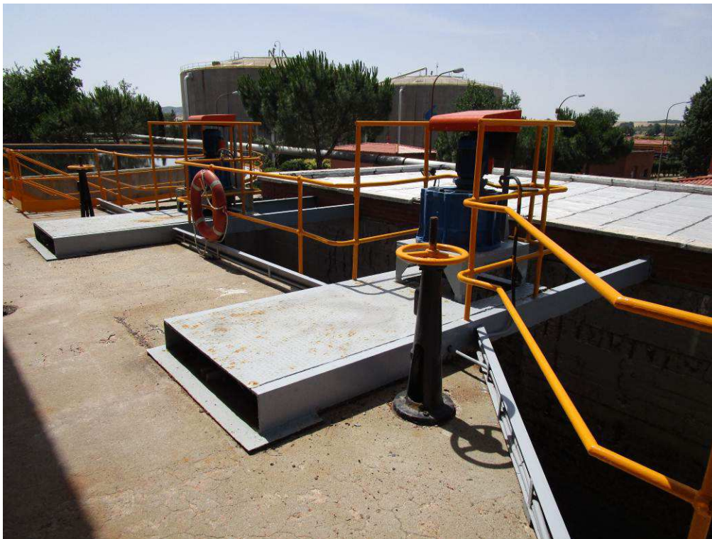
Foto 13. Cámara de mezcla de fangos espesados.
