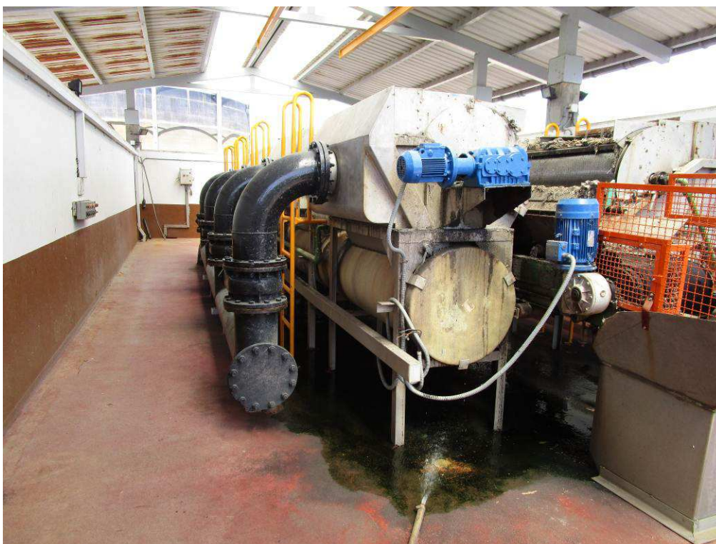
Foto 15. Tamices rotativos de fangos existentes.
