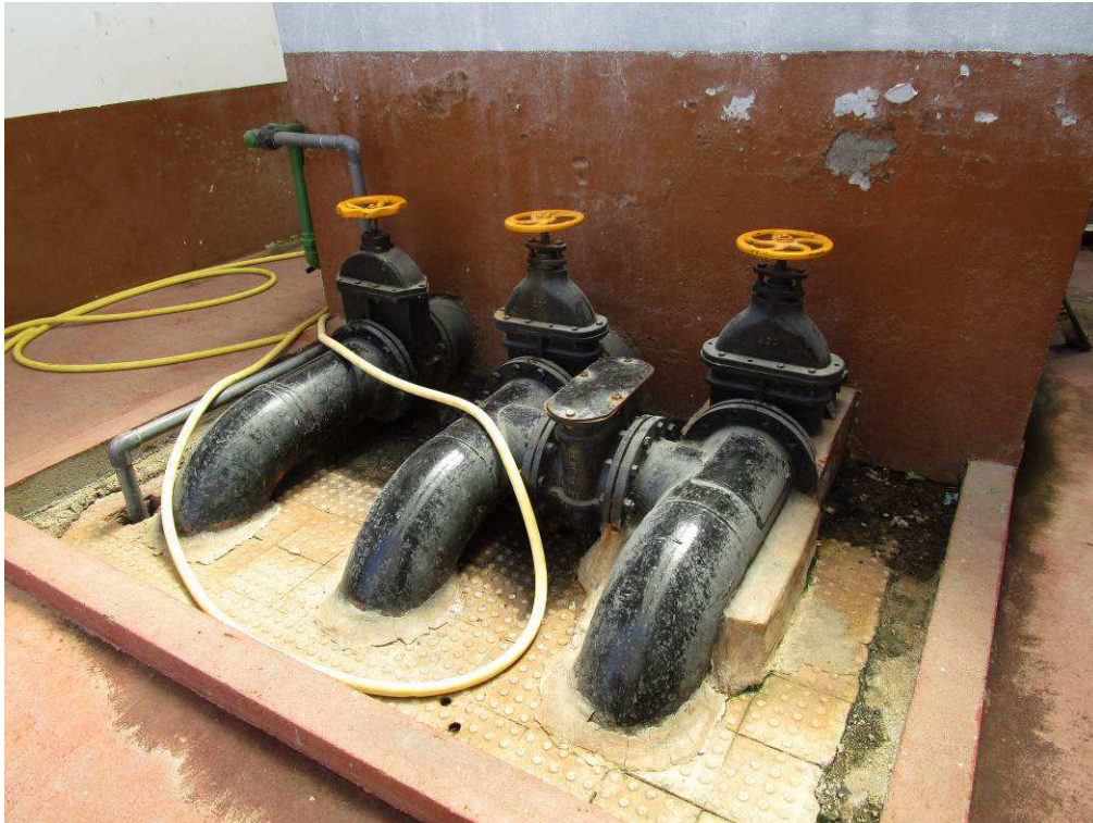
Foto 17. Arqueta de reparto de fangos en edificio de tamizado de fangos.
