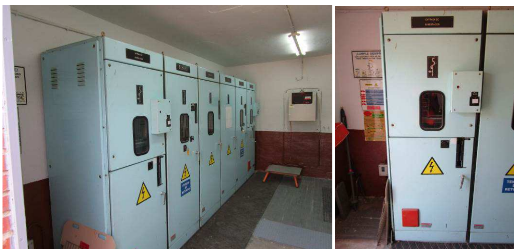
Foto 26. Interior CT Pretratamiento. Conjunto de celdas de media tensión, y detalle de celda de entrada en la que se conectará el nuevo cable de alimentación desde CT Alivio.
