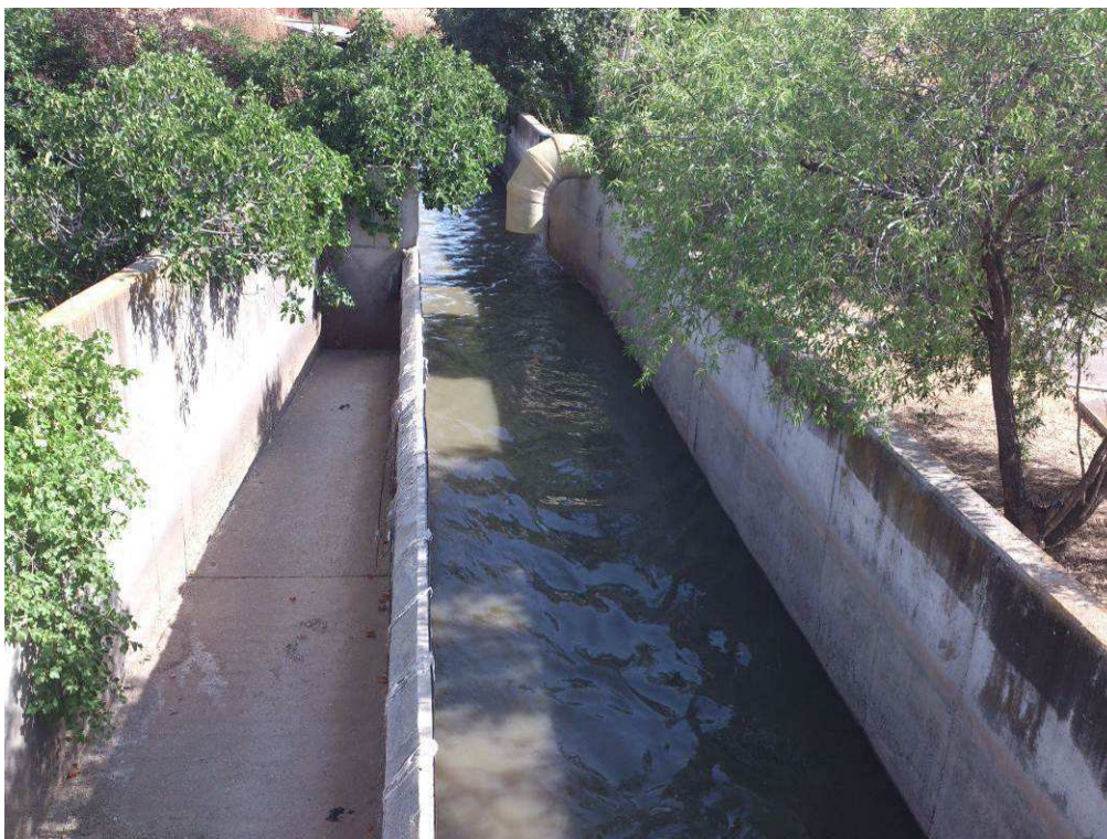
Foto 3. Entrada de agua a EDAR. Vertedero de alivio general de la planta.
