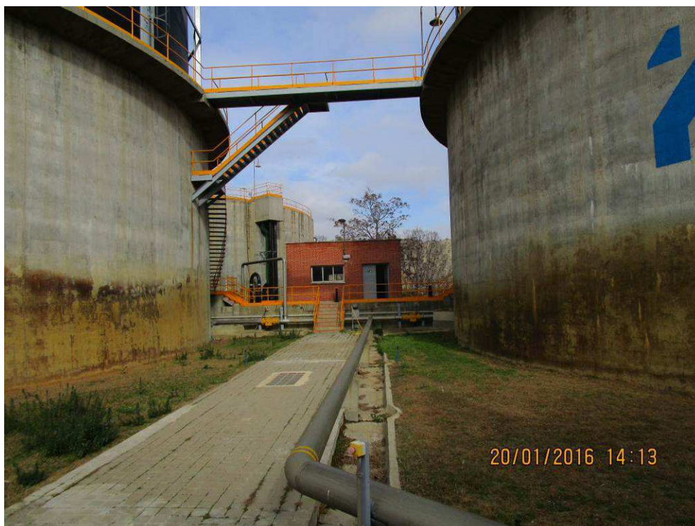
Foto 11. Tubería de gas a gasómetros actuales.
