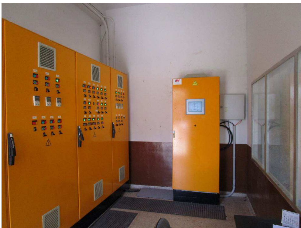
Foto 27. CCM Digestión Fase 1 que se adaptará para añadir ciertas cargas por la Actuación 4 Gasómetros de membrana.
