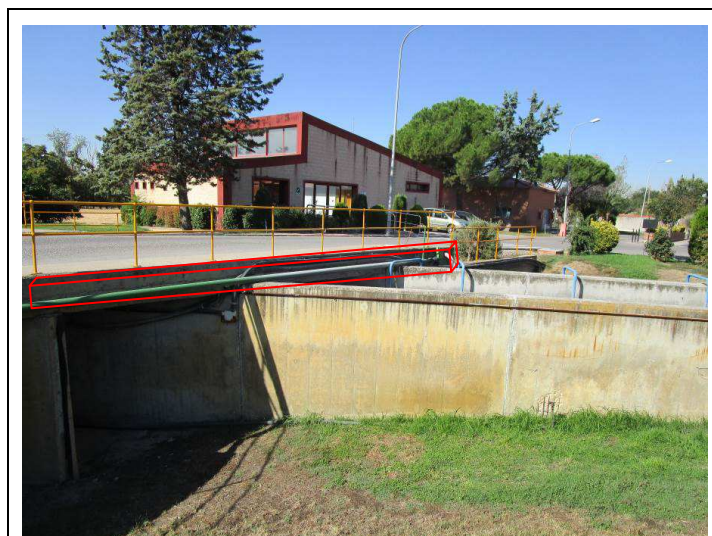
Paso del canal de agua a decantación: se instalará nueva canalización
