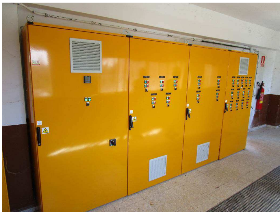
Foto 27. CCM Digestión Fase 1 que se adaptará para añadir ciertas cargas por la Actuación 4 Gasómetros de membrana.
