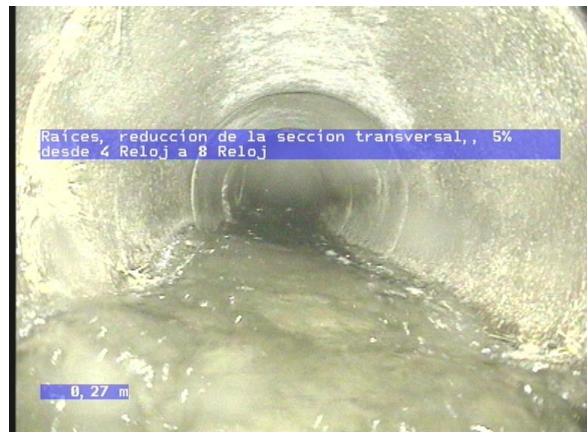
2-2-2A, 00:00:17.36, 0.27 Raíces, reducción de la sección transversal,, 5% desde 4 Reloj a 8 Reloj
