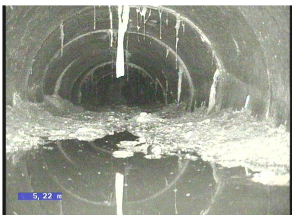
5-10-12B, 00:01:20.32, 17.18 Inspección abandonada, obstrucción / Sedimentos
