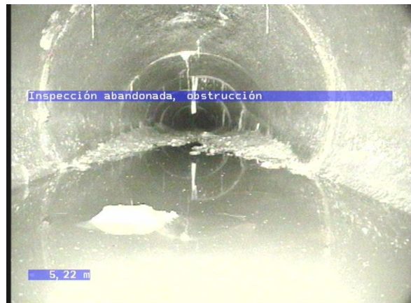
5-10-12A, 00:01:20.32, 17.18 Inspección abandonada, obstrucción / Sedimentos
