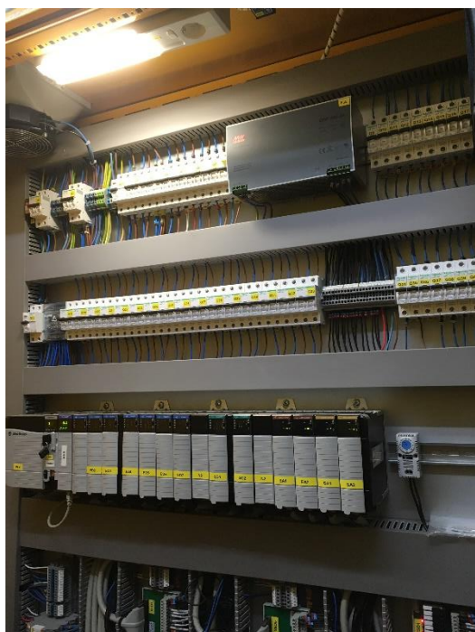
Ilustración 1: Módulos de entradas y salidas y PLC
