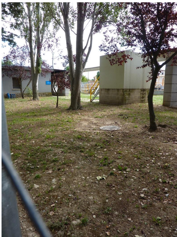
Arqueta de reunión de colectores de alivio y de salida de agua tratada de la EDAR
