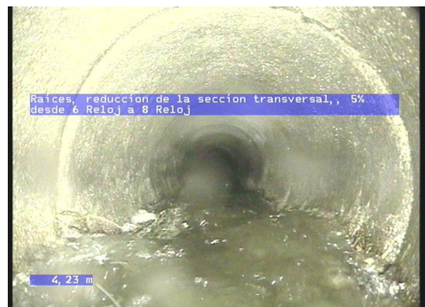
2-2-5A, 00:01:45.45, 4.23 Raíces, reducción de la sección transversal,, 5% desde 6 Reloj a 8 Reloj
