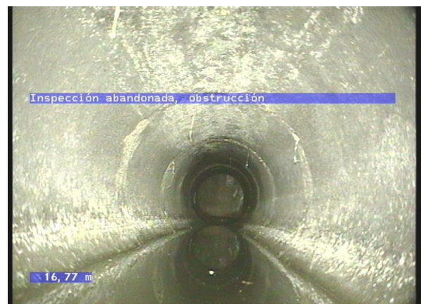
5-10-6A, 00:02:50.32, 16.77 Inspección abandonada, obstrucción / Obstáculo
