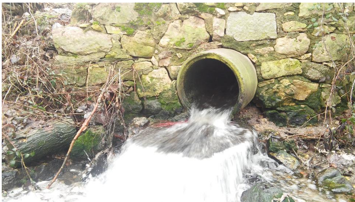
Obra de mampostería en la entrega del colector de vertido
