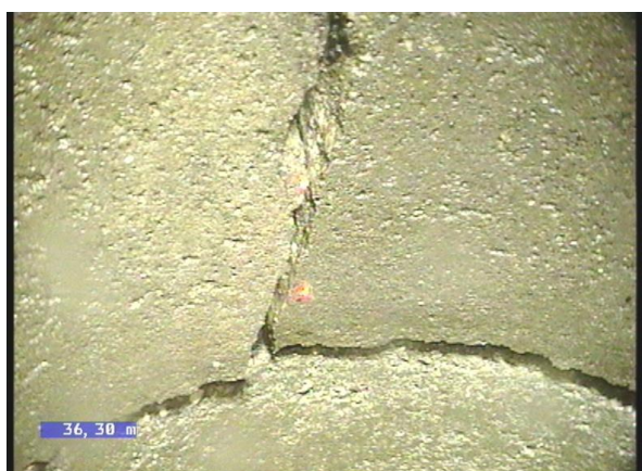
2-2-15B, 00:10:05.19, 35.50 Micro-fisura compleja, anchura de la fisura, 6mm desde 9 Reloj a 5 Reloj
