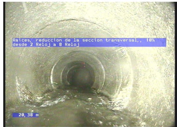
2-2-7A, 00:05:01.02, 20.38 Raíces, reducción de la sección transversal,, 10% desde 2 Reloj a 8 Reloj
