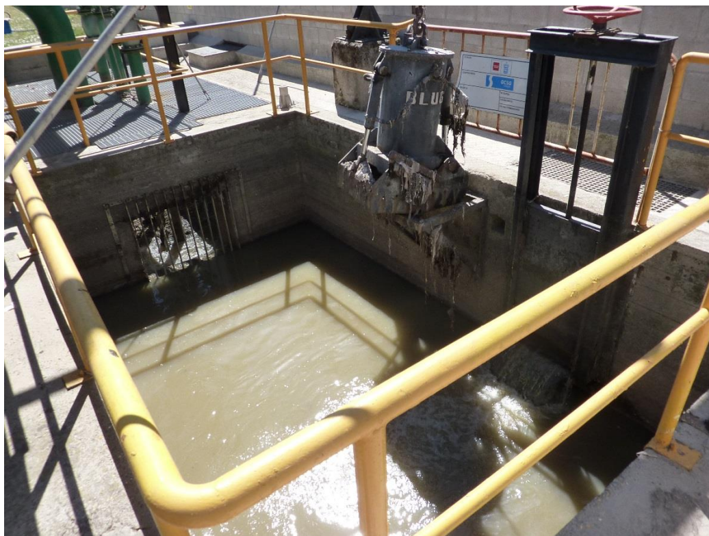
Pozo de gruesos, compuerta de entrada, cuchara bivalva y reja de paso a pozo de bombeo
