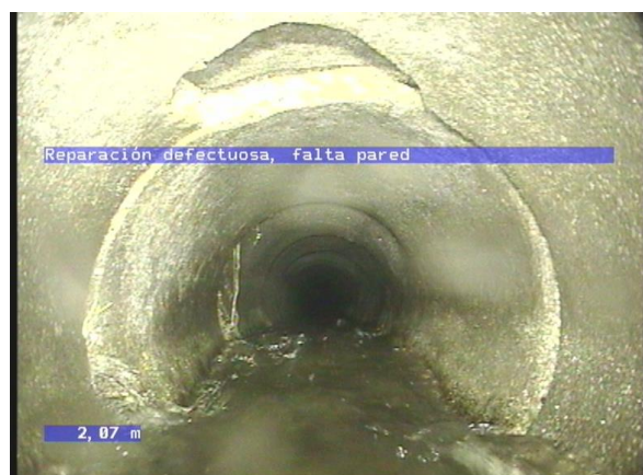
2-2-3A, 00:00:49.07, 2.07 Reparación defectuosa, falta pared
