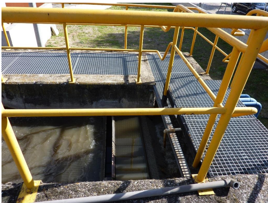
Agua de servicios (negro), dosificación de Cl_3Fe (blanco) y salida de tuberías de desarenador (verde)
