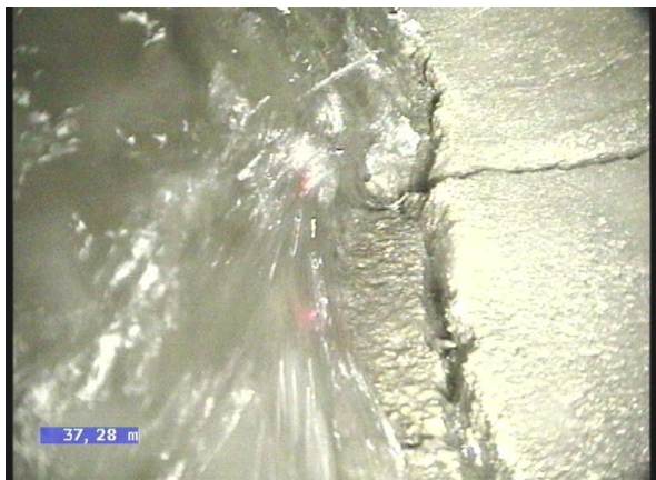
2-2-16B, 00:10:41.47, 36.56 Fisura abierta, longitudinal, anchura de la fisura, 10mm a 5 Reloj
