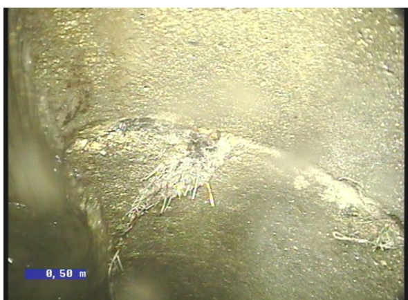
2-2-2B, 00:00:17.36, 0.27 Raíces, reducción de la sección transversal,, 5% desde 4 Reloj a 8 Reloj
