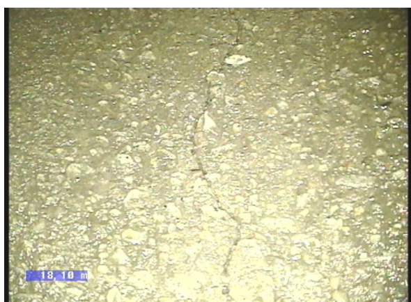
6-6-2B, 00:02:25.47, 17.49 Fisura, grieta superficial, longitudinal, anchura de la fisura, 1mm a 6 Reloj
