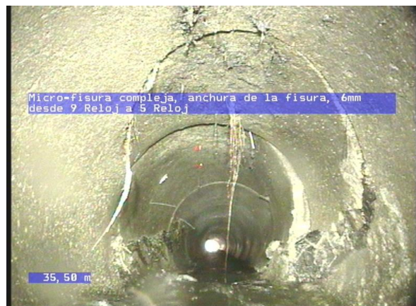
2-2-15A, 00:10:05.19, 35.50 Micro-fisura compleja, anchura de la fisura, 6mm desde 9 Reloj a 5 Reloj
