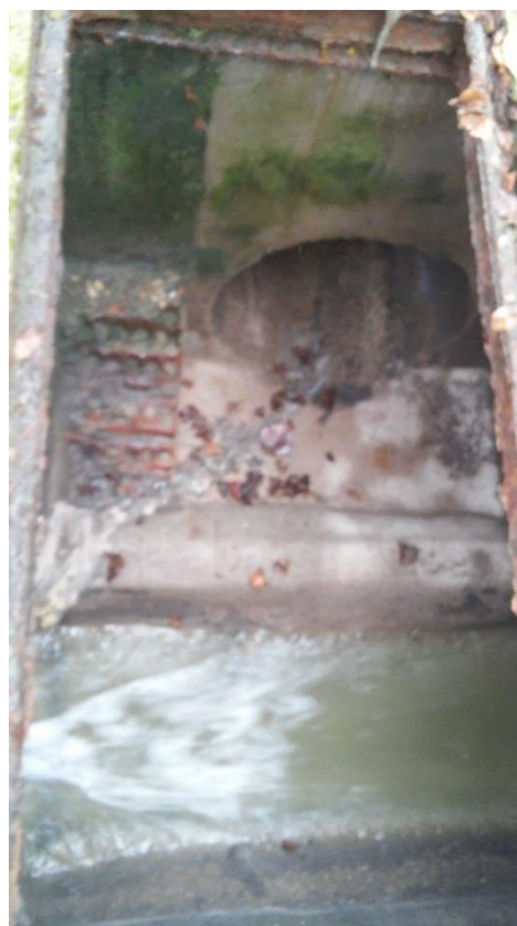
Interior de arqueta de entrada, vertedero a media caña e inicio de colector de alivio
