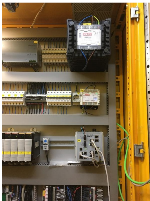
Ilustración 2: PLC Y SWITCH existente.
