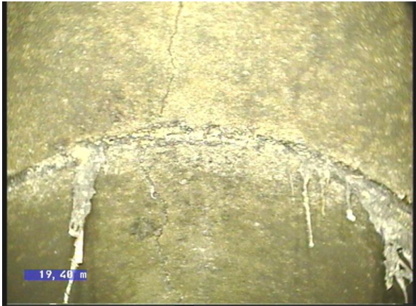
6-6-3B, 00:02:59.35, 18.60 Fisura abierta, longitudinal, anchura de la fisura, 1mm a 12 Reloj
