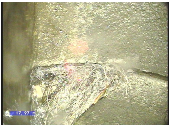
2-2-6B, 00:04:19.69, 17.41 Raíces, reducción de la sección transversal,, 5% desde 7 Reloj a 8 Reloj
