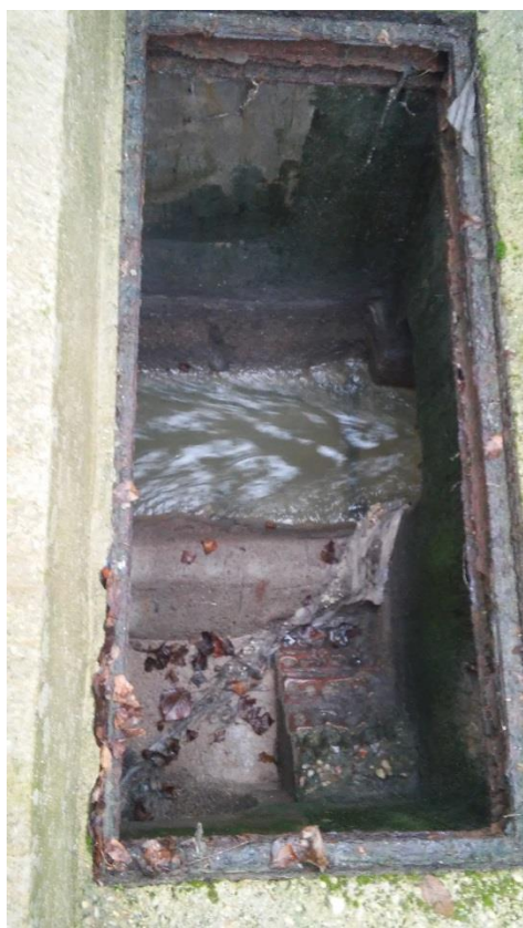
Interior de arqueta de entrada, vertedero a media caña e inicio de colector de alivio
