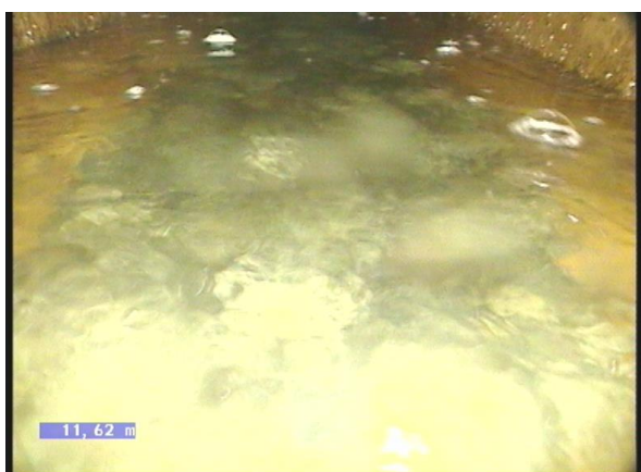
1-1-2B, 00:01:39.80, 11.52 Depósitos áridos gruesos (por ejemplo cascotes, gravar) en el hilo, grueso, 10%
