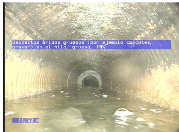
1-1-2A, 00:01:39.80, 11.52 Depósitos áridos gruesos (por ejemplo cascotes, gravar) en el hilo, grueso, 10%
