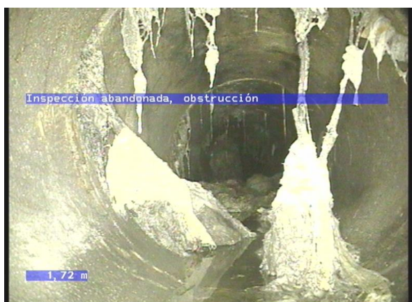
4-9-3A, 00:01:18.98, 1.72 Inspección abandonada, obstrucción / Raíces con toallitas
