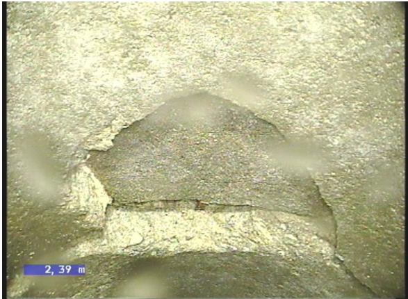
2-2-3B, 00:00:49.07, 2.07 Reparación defectuosa, falta pared
