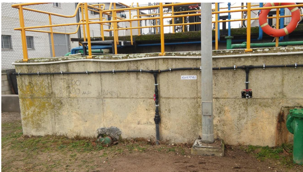
Agua de servicios (negro), dosificación de Cl_3Fe (blanco) y salida de tuberías de desarenador (verde)
