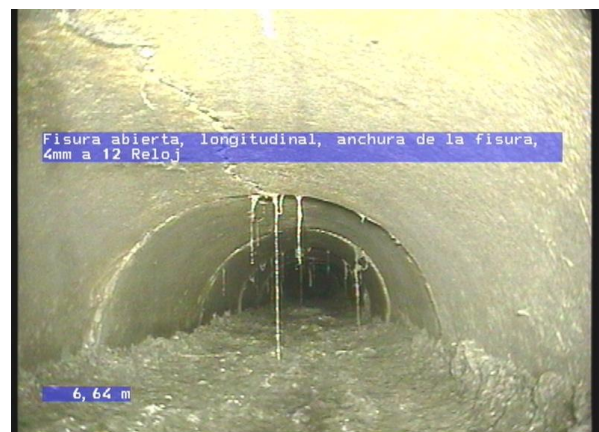
5-10-4A, 00:01:35.80, 6.64 Fisura abierta, longitudinal, anchura de la fisura, 4mm a 12 Reloj
