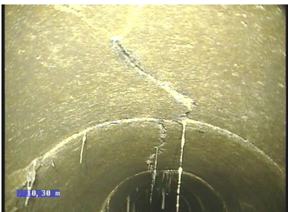
5-10-5B, 00:02:02.22, 9.58 Fisura, grieta compleja, anchura de la fisura, 4mm desde 10 Reloj a 2 Reloj
