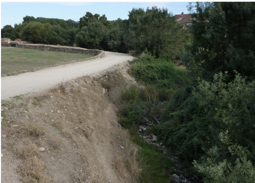
Terraplén de camino en margen izquierda que actúa como un encauzamiento artificial
