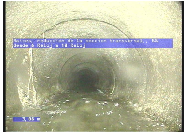
2-2-4A, 00:01:19.73, 3.08 Raíces, reducción de la sección transversal,, 5% desde 6 Reloj a 10 Reloj
