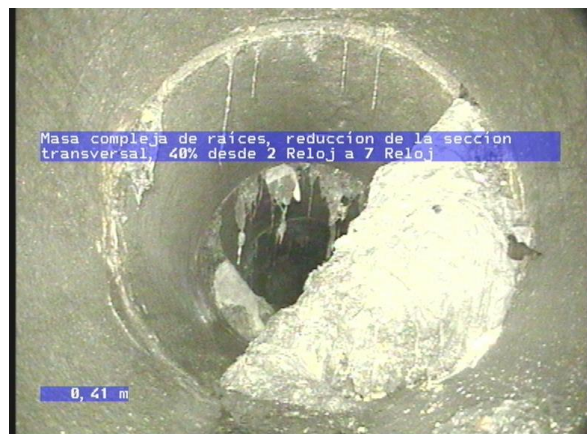
4-9-2A, 00:00:49.17, 0.41 Masa compleja de raíces, reducción de la sección transversal, 40% desde 2 Reloj a 7 Reloj
