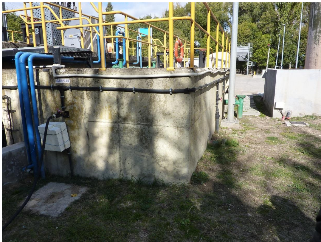
Muro de pretratamiento sobre el que se adosarán los nuevos canales de desbaste
