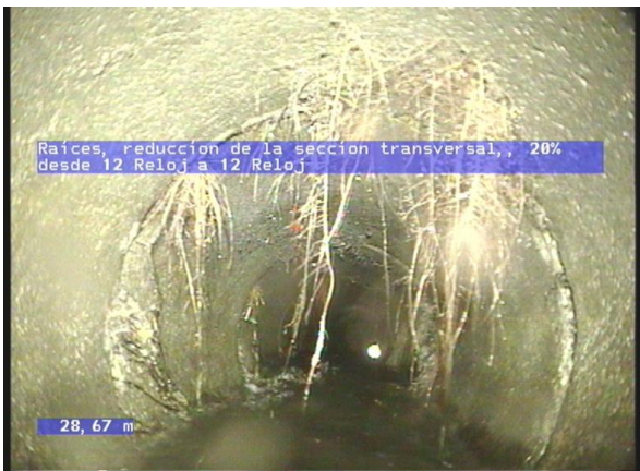
2-2-12A, 00:08:21.37, 28.67 Raíces, reducción de la sección transversal,, 20% desde 12 Reloj a 12 Reloj
