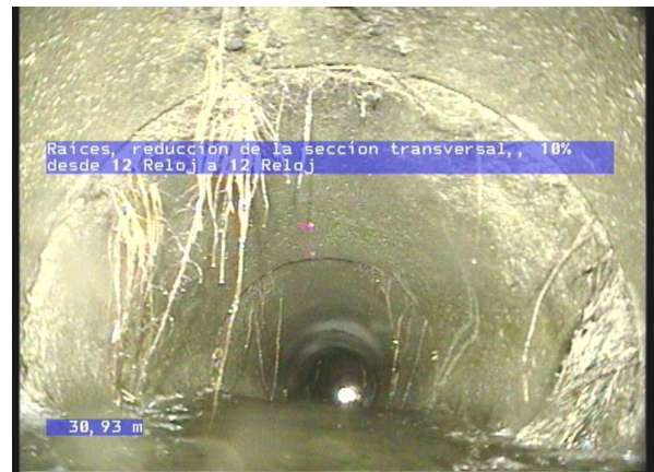
2-2-13A, 00:08:44.77, 30.93 Raíces, reducción de la sección transversal,, 10% desde 12 Reloj a 12 Reloj
