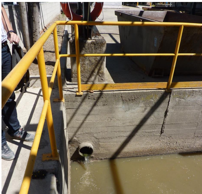
Vertido de red de saneamiento interior de la planta a pozo de gruesos
