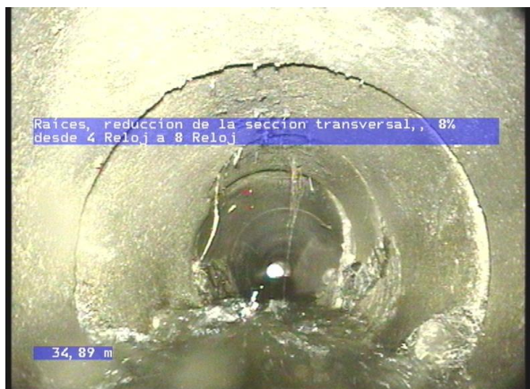
2-2-14A, 00:09:30.35, 34.89 Raíces, reducción de la sección transversal,, 8% desde 4 Reloj a 8 Reloj
