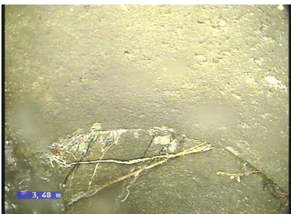
2-2-4B, 00:01:19.73, 3.08 Raíces, reducción de la sección transversal,, 5% desde 6 Reloj a 10 Reloj
