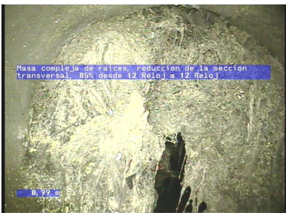
4-9-10A, 00:01:14.91, 13.01 Masa compleja de raíces, reducción de la sección transversal, 85 %, desde 12 a 12 Reloj
