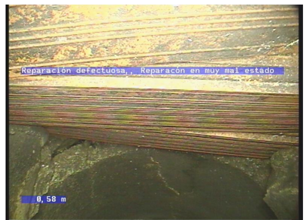
4-9-11A, 00:00:26.62, 13.42 Reparación defectuosa, Reparación en muy mal estado / Reduciendo la sección de 600h a 500H
