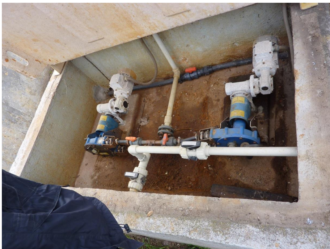
Bombas peristálticas de dosificación existentes
