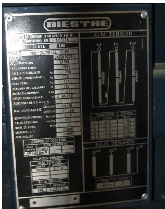
Ilustración 3: Placa de características transformador existente.
