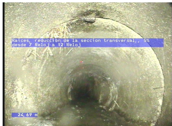
2-2-9A, 00:06:00.73, 24.69 Raíces, reducción de la sección transversal,, 5% desde 7 Reloj a 12 Reloj
