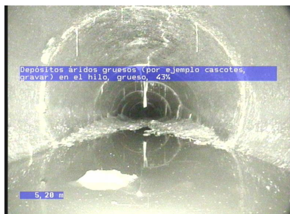
5-10-13A, 00:01:03.55, 17.20 Depósitos áridos gruesos (por ejemplo cascotes, grava) en el hilo, grueso, 43 %
