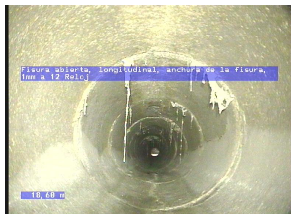
6-6-3A, 00:02:59.35, 18.60 Fisura abierta, longitudinal, anchura de la fisura, 1mm a 12 Reloj
