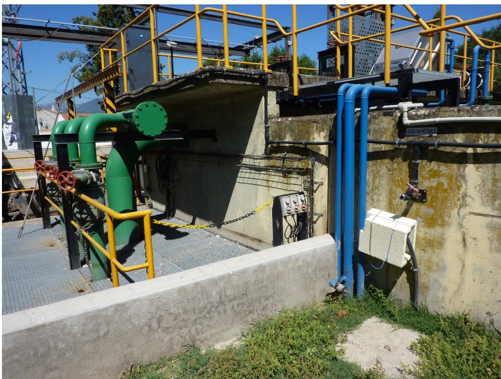
Impulsión a pretratamiento (verde) desde pozo de bombeo y conducciones de aire (azúl) a desarenador
