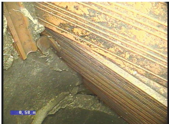
4-9-11B, 00:00:26.62, 13.42 Reparación defectuosa,, Reparación en muy mal estado / Reduciendo la sección de 600h a 500H
