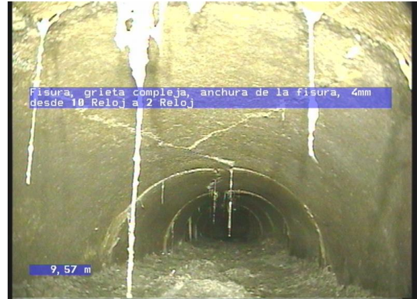
5-10-5A, 00:02:02.22, 9.58 Fisura, grieta compleja, anchura de la fisura, 4mm desde 10 Reloj a 2 Reloj
