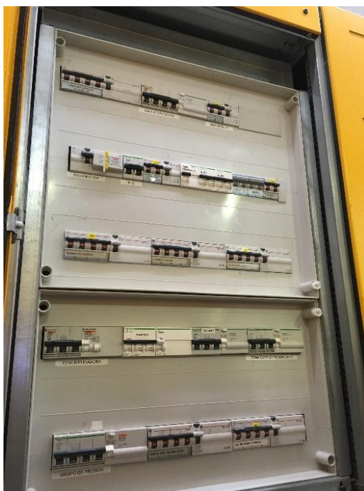
Ilustración 4: Módulo en el que se instalará el interruptor para alimentación del nuevo CCM 2.
