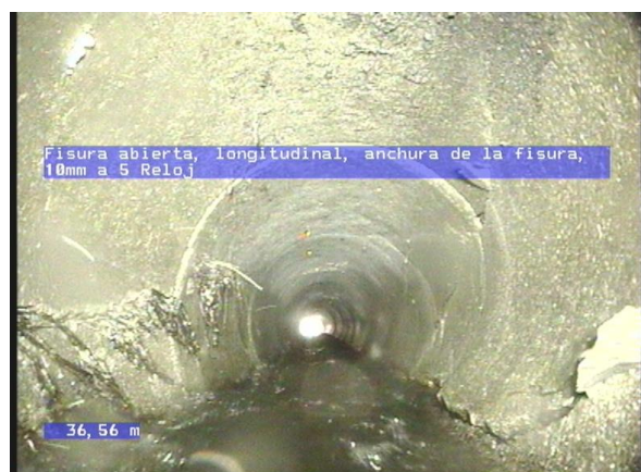
2-2-16A, 00:10:41.47, 36.56 Fisura abierta, longitudinal, anchura de la fisura, 10mm a 5 Reloj
