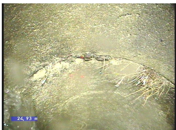
2-2-9B, 00:06:00.73, 24.69 Raíces, reducción de la sección transversal,, 5% desde 7 Reloj a 12 Reloj
