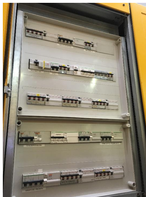
Ilustración 2: Módulo en el que se instalará el interruptor para alimentación del nuevo CCM 2.
