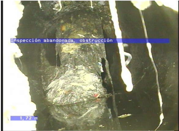
4-9-9A, 00:01:58.90, 12.29 Inspección abandonada, obstrucción / Raices
