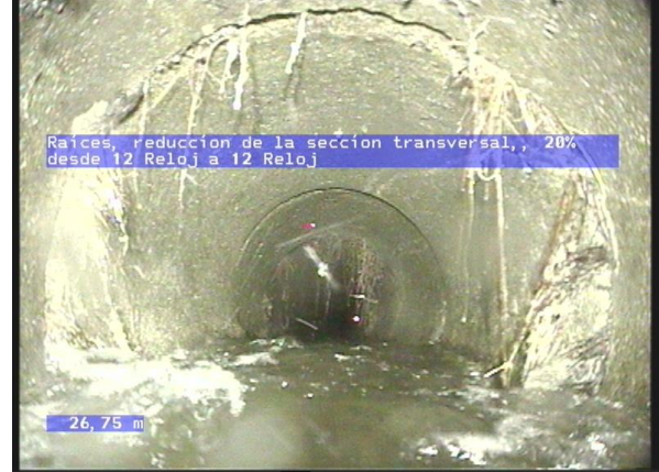
2-2-11A, 00:07:47.72, 26.75 Raíces, reducción de la sección transversal,, 20% desde 12 Reloj a 12 Reloj
