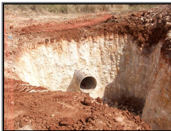
Pozo de salida de la hincia
