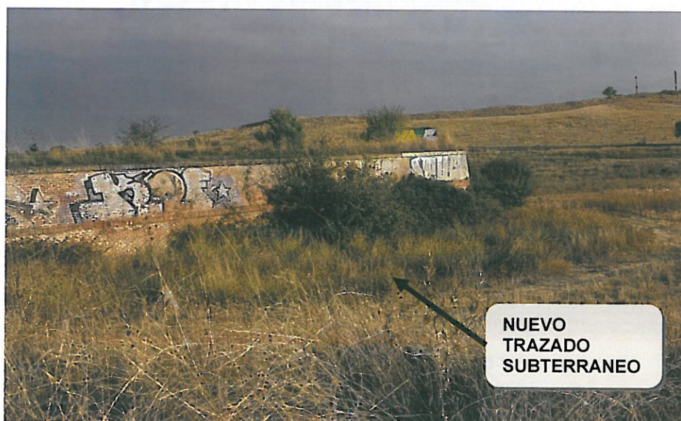
Foto 4. Vista del nuevo trazado subterráneo de LSAT paralela al Canal bajo existente, desde conexión de CT CB-14 hasta zona apoyo nº16070
