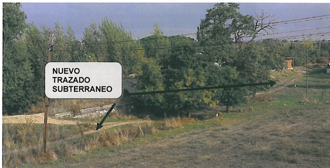
Foto 5. Vista del nuevo trazado subterráneo de LSAT paralela al Canal bajo existente, desde conexión de CT CB-14 hasta zona apoyo nº16070
