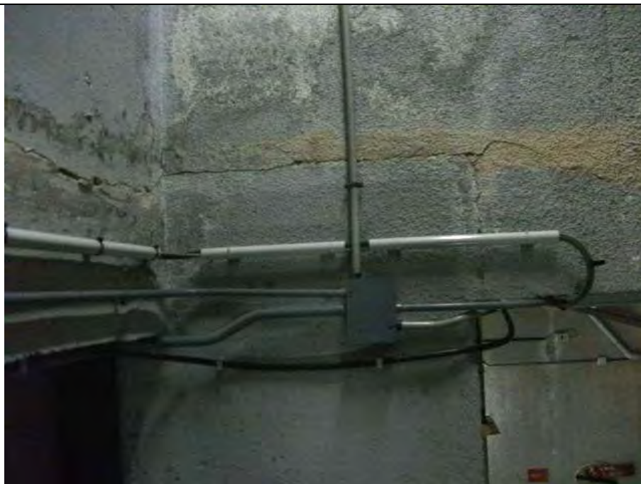
Foto 14. Grieta horizontal en el hueco de la escalera de acceso a la sala de bombas
