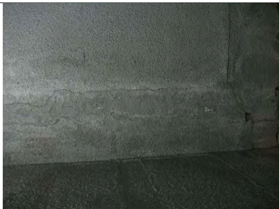
Foto 19. Grietas en el techo de la sala de bombas
