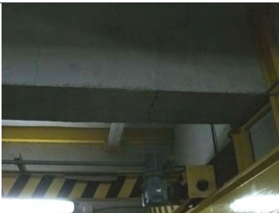
Foto 17. Grieta vertical situada junto al nudo de arranque de una viga en la sala de bombas
