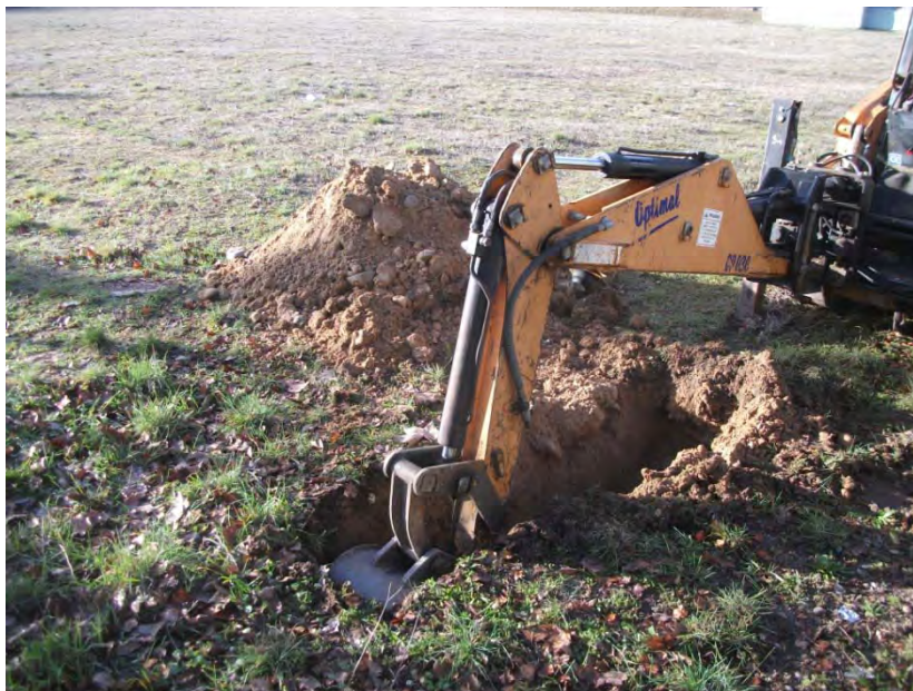
Fotografía 4: Ejecución de la calicata C-1
