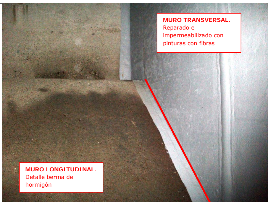
Foto 10. Encuentro muro transversal y longitudinal. Berma de hormigón en muro longitudinal
