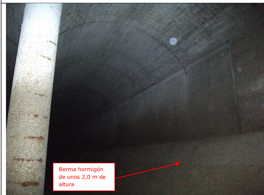
Foto 2. Berma de hormigón en intradós muro longitudinal
