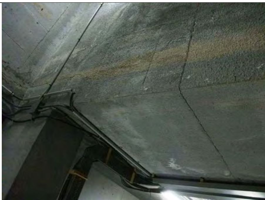
Foto 15. Grieta en la viga que arranca junto al hueco de la escalera
