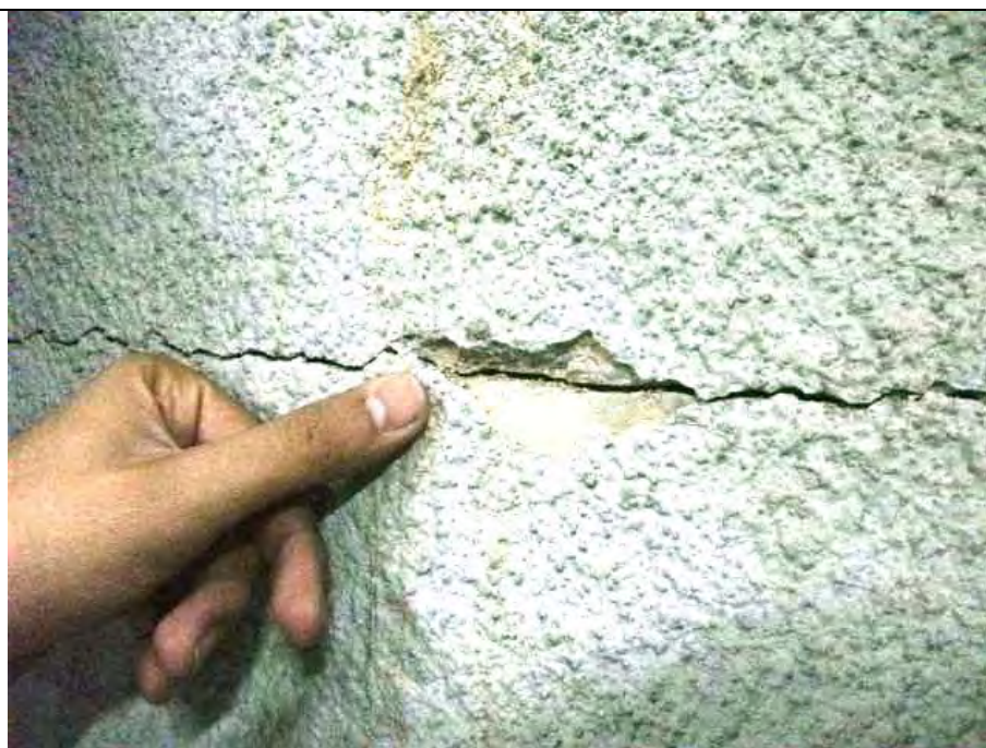
Foto 16. Grieta horizontal en la sala de bombas
