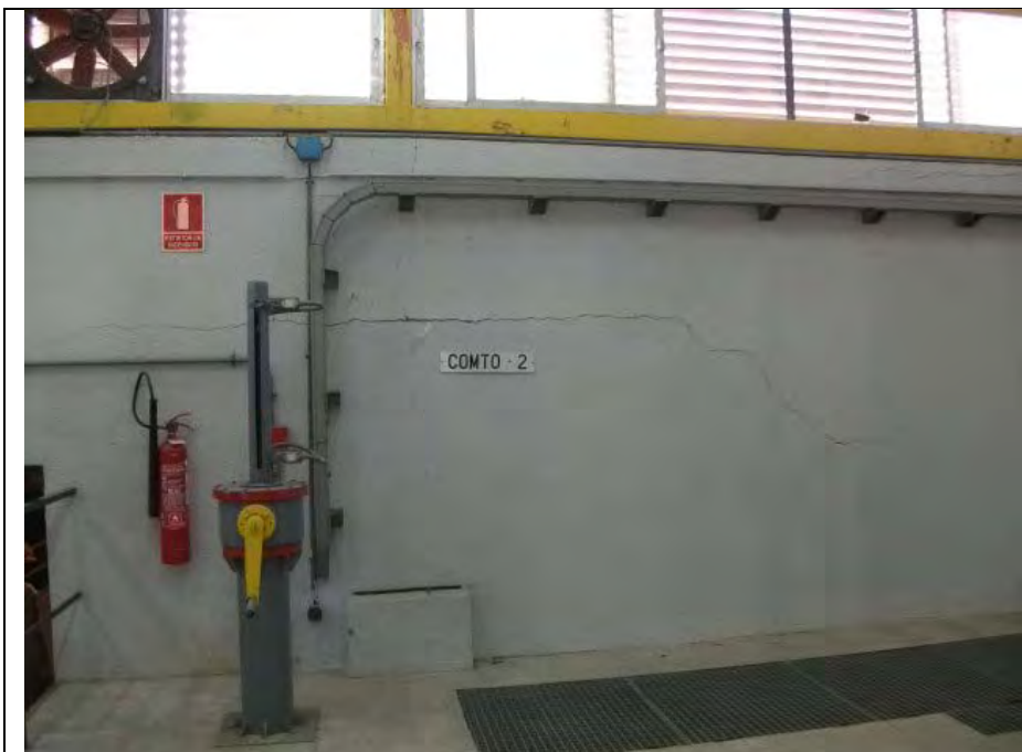
Foto 12. Grieta horizontal en en la entrada del edificio de bombas
