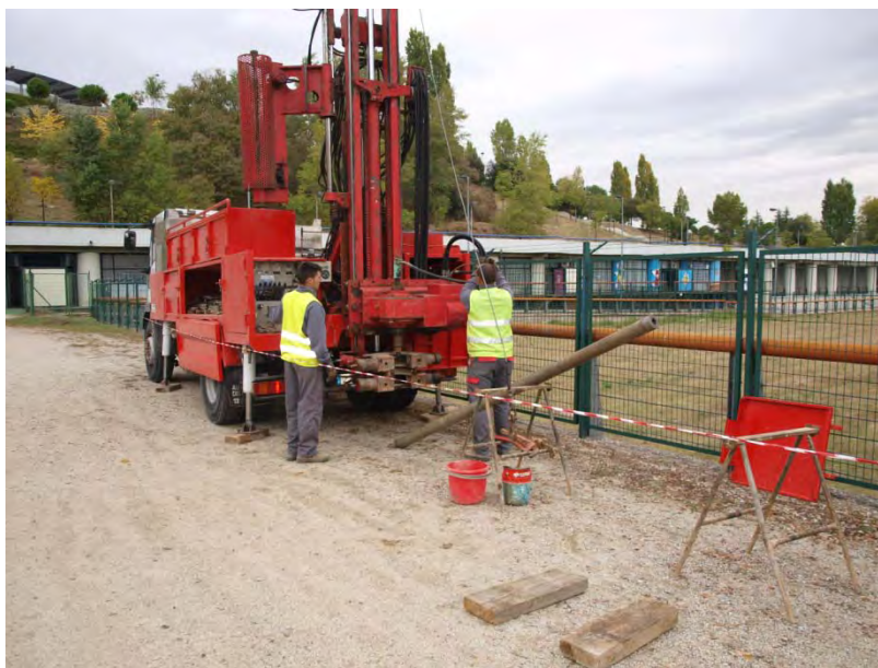
Fotografía 1: Máquina de sondeos Mobile Drill N80 durante la ejecución del sondeo S-6
