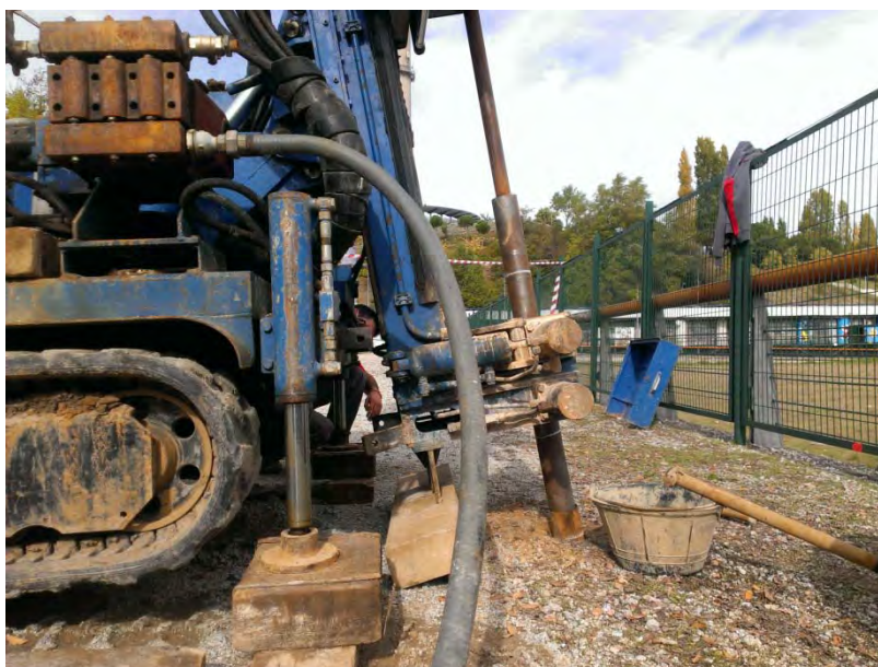
Fotografía 2: Máquina de sondeos Tecoinsa TP50-D2 durante la ejecución del sondeo inclinado S-5
