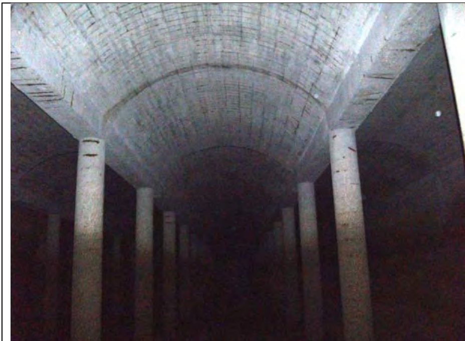
Foto 1. Aspecto generalizado de bóvedas. Armadura vista y con corrosión avanzada
