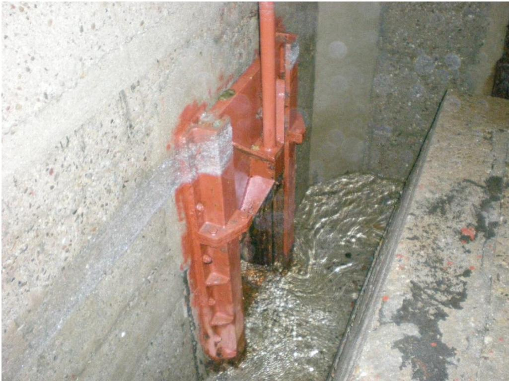
**12. Compuerta mural entre depósito y canal de alimentación bombeo (3)**
