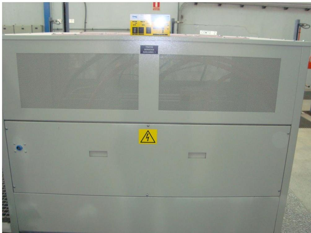
15. Trafo servicios auxiliares 20 kV/420 V de 160 kVA(1)
