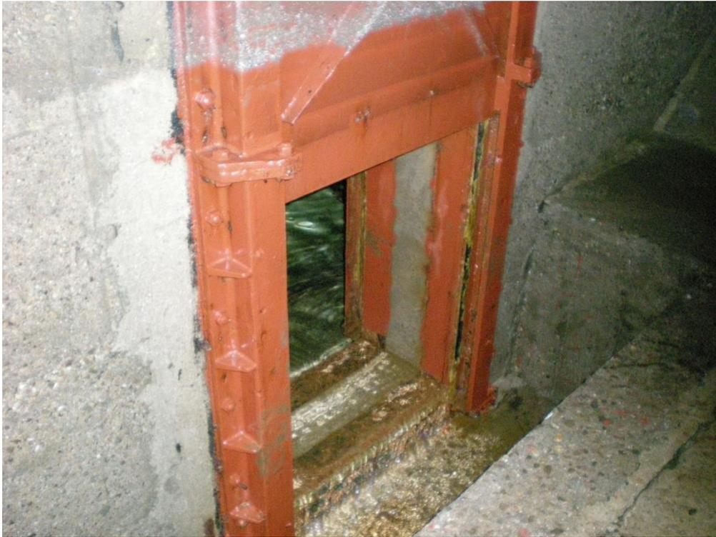
**11. Compuerta mural entre depósito y canal de alimentación bombeo (2)**
