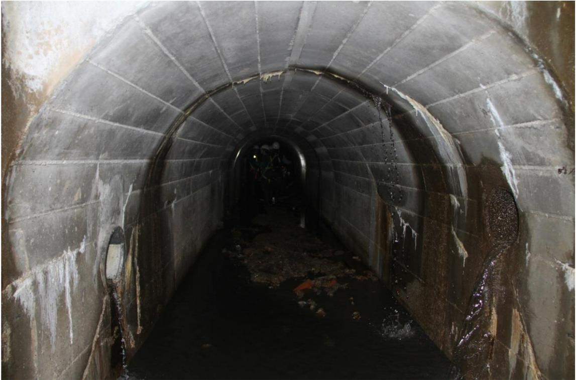
**5. Conexión tuberías de drenaje solera depósito con galería de drenaje.**
