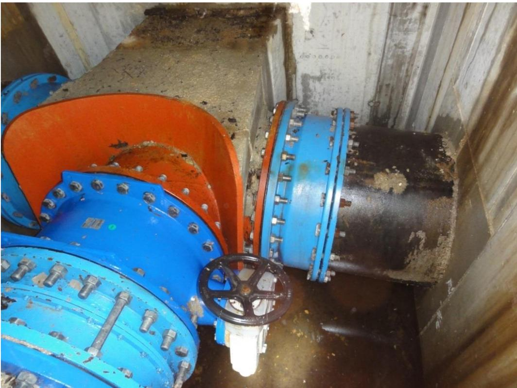
12. Arqueta de conexión: Aducción DN 800 mm e impulsión DN 900 mm.
