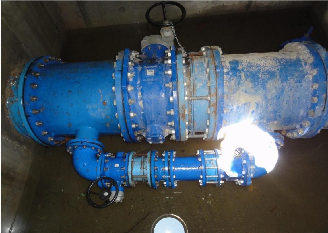
**13 Arqueta de conexión. Aducción bombeo en línea con Aducción DN 800 mm con alimentación depósito El Pinar.**
