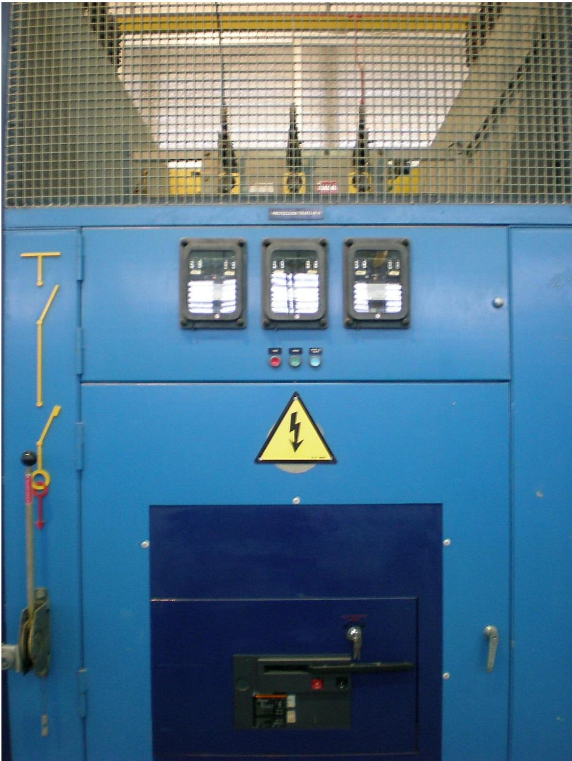
**13. Protección Trafo nº 4 20kV/6 kV de 1600 kVA**
